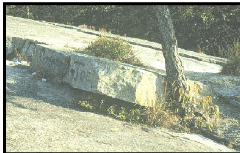
Figura 3.48 Fotografía que muestra el fracturamiento debido a actividad biológica de las plantas (tomada de Arellano, 2002).
