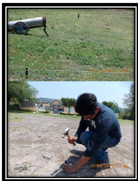
Figura 29. Marcación del terreno con hilo y estacas.
