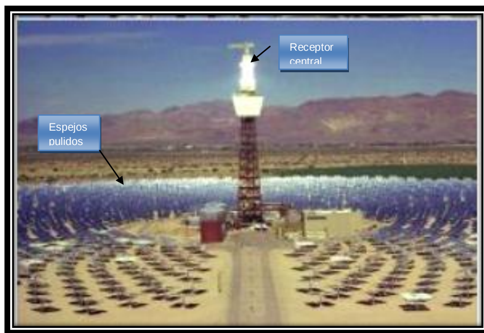
Figura 2.12 Fotografía de un receptor central con heliostatos (Estrada, 2013)
