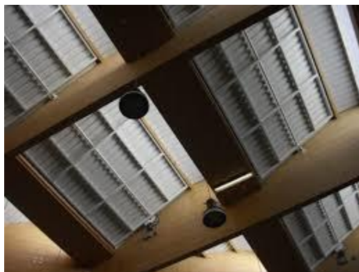
Ilustración 0-2 algunas estaciones de trabajo cuentan con diseños dirigidas a darles a los usuarios un adecuado nivel de confort con respecto a iluminación, clima y flujo de aire.
