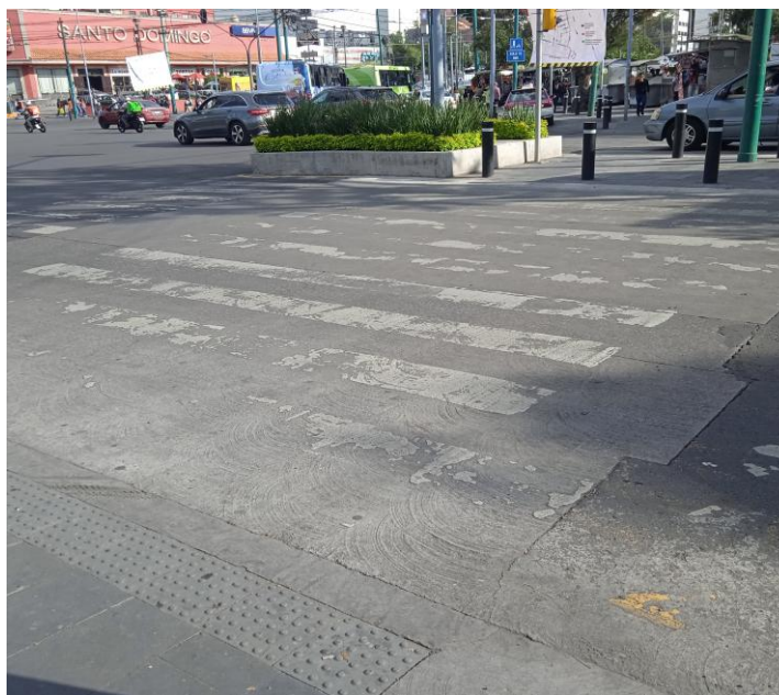
Figura 12: Estado de los señalamientos horizontales en la salida/acceso poniente de la glorieta
