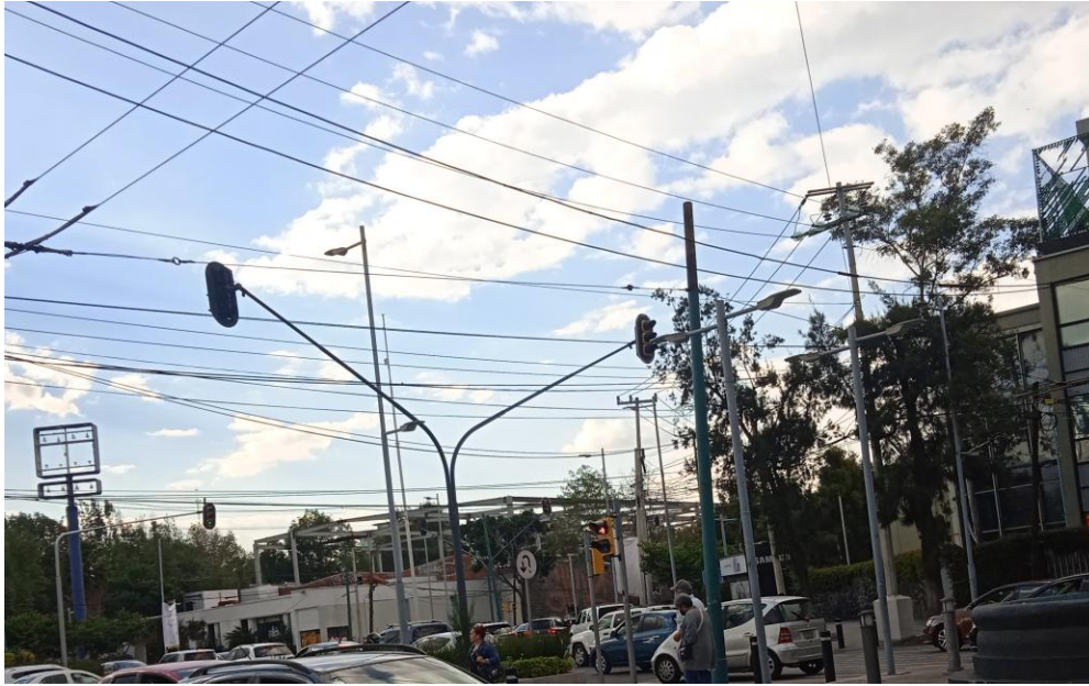
Figura 10: Acceso/Salida Oriente de la glorieta
