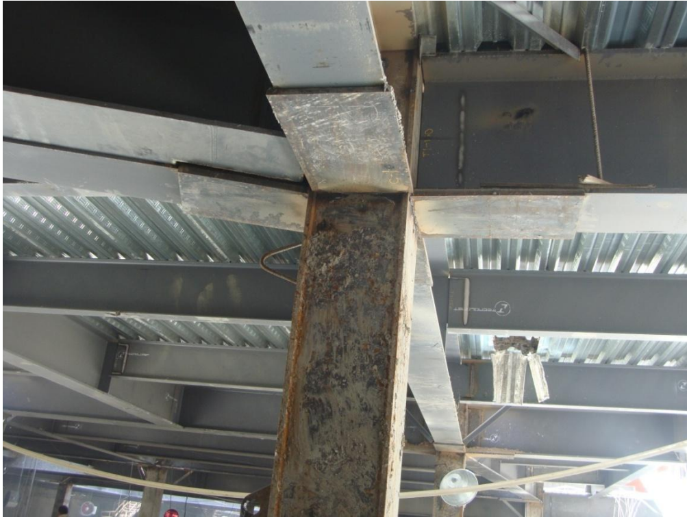
Fotografía 28.- Nodo estructura metálica
