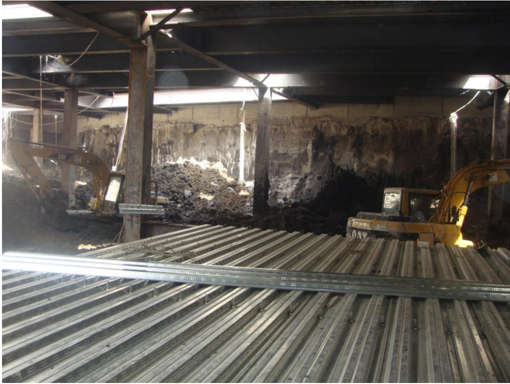
Fotografía 37.- Losacero y excavación
