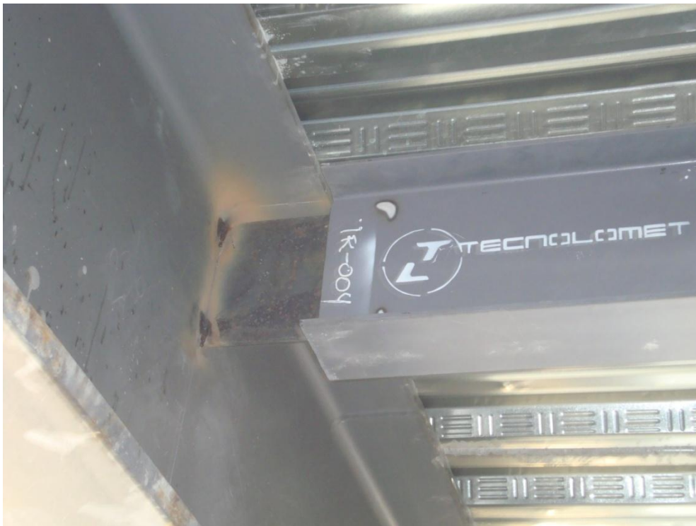
Fotografía 29.- Conexión trabe primaria a secundaria
