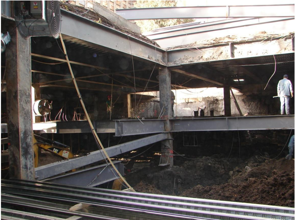
Fotografía 55.- Ventilador de inyección en la esquina de la lumbrera en planta baja
