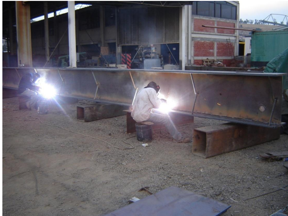
Fotografía 15.- Armado y soldado de la columna.
