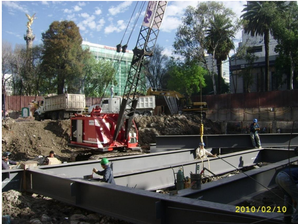
Fotografía 21.- Montaje estructura metálica en planta baja
