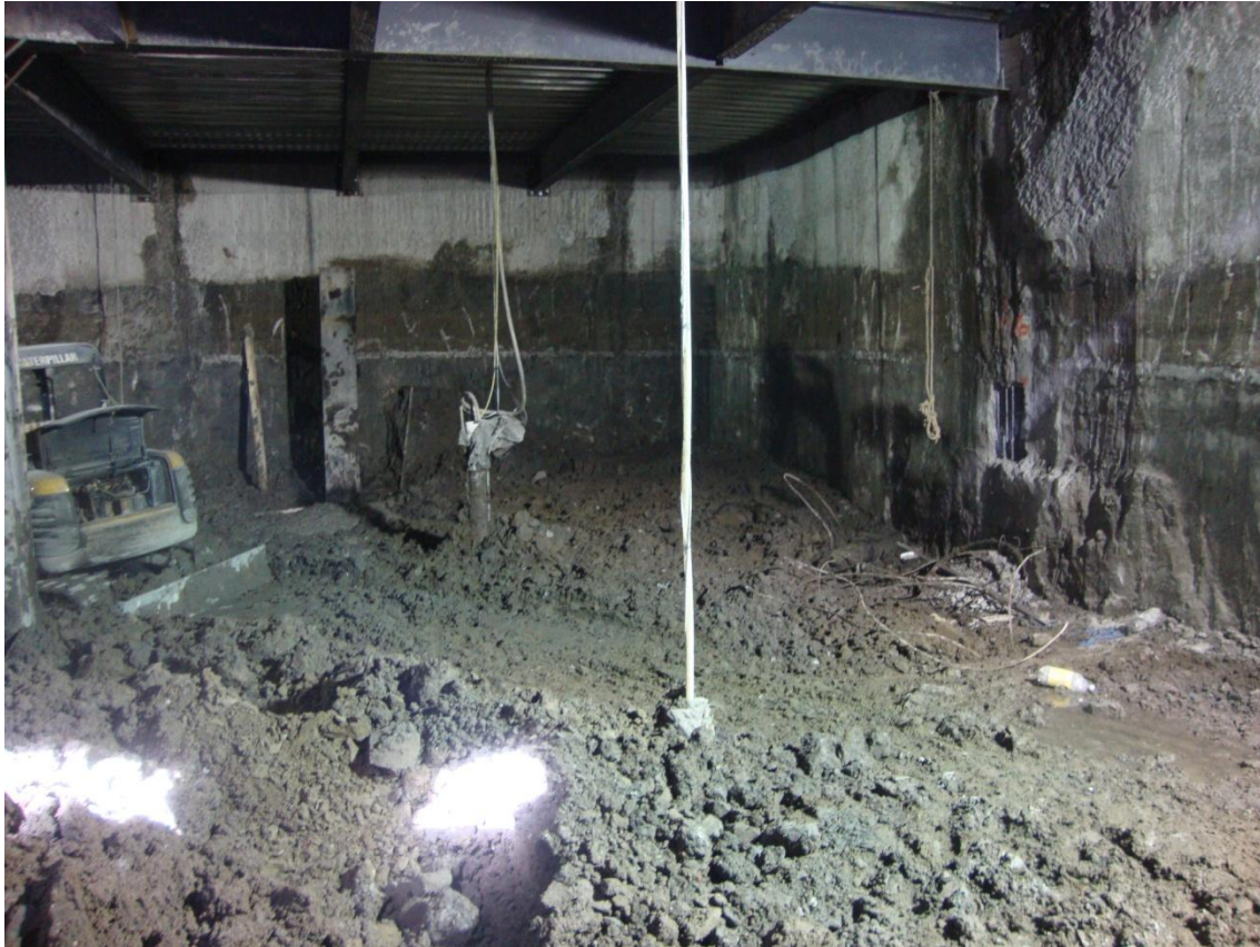
Fotografía 54.- Pozos descubiertos durante la excavación
