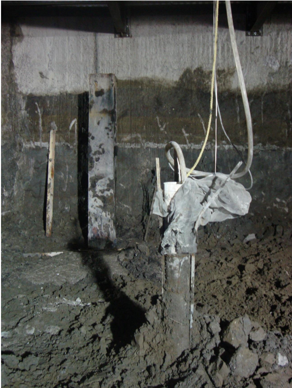
Fotografía 53.- Detalle de pozo de abatimiento, ademe, manguera
