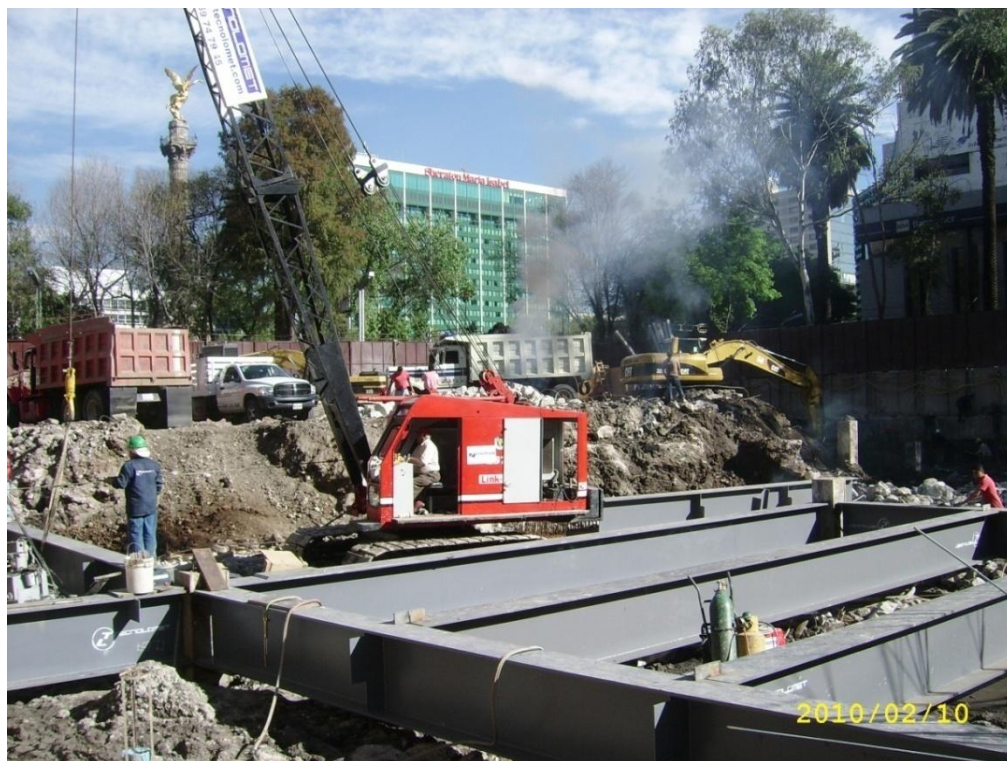
Fotografía 22.- Montaje estructura metálica en planta baja
