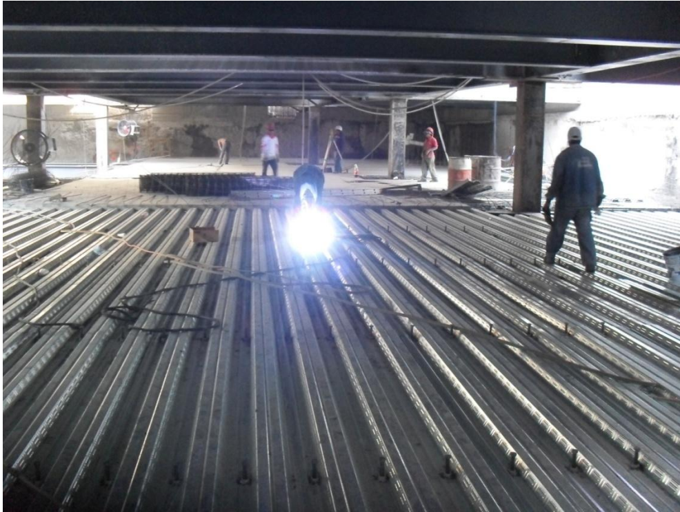
Fotografía 35.- Detalle losacero con pernos Nelson
