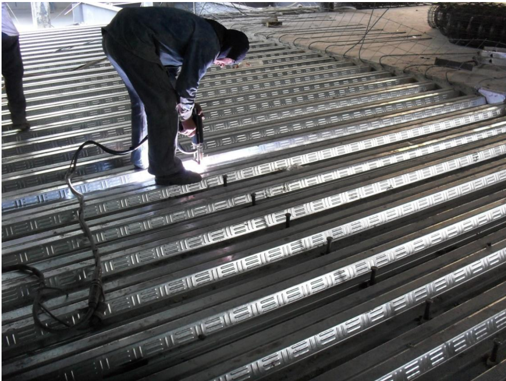
Fotografía 36.- Colocación de pernos Nelson
