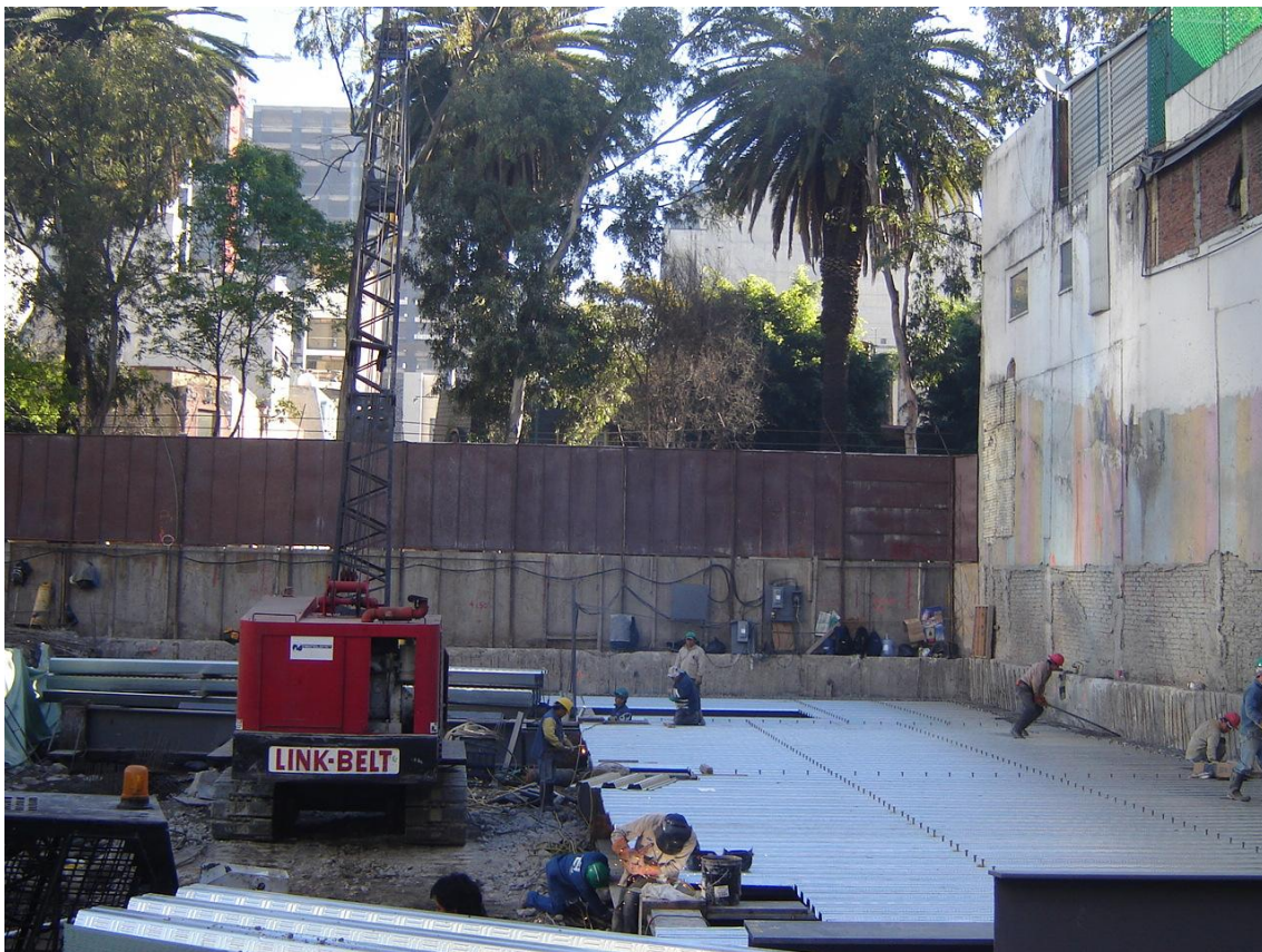
Fotografía 34.- Losacero en planta baja
