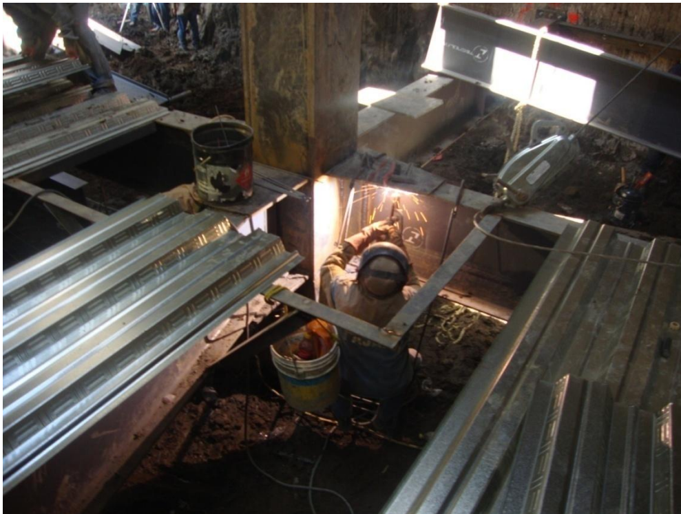
Fotografía 26.- Soldadura en conexiones
