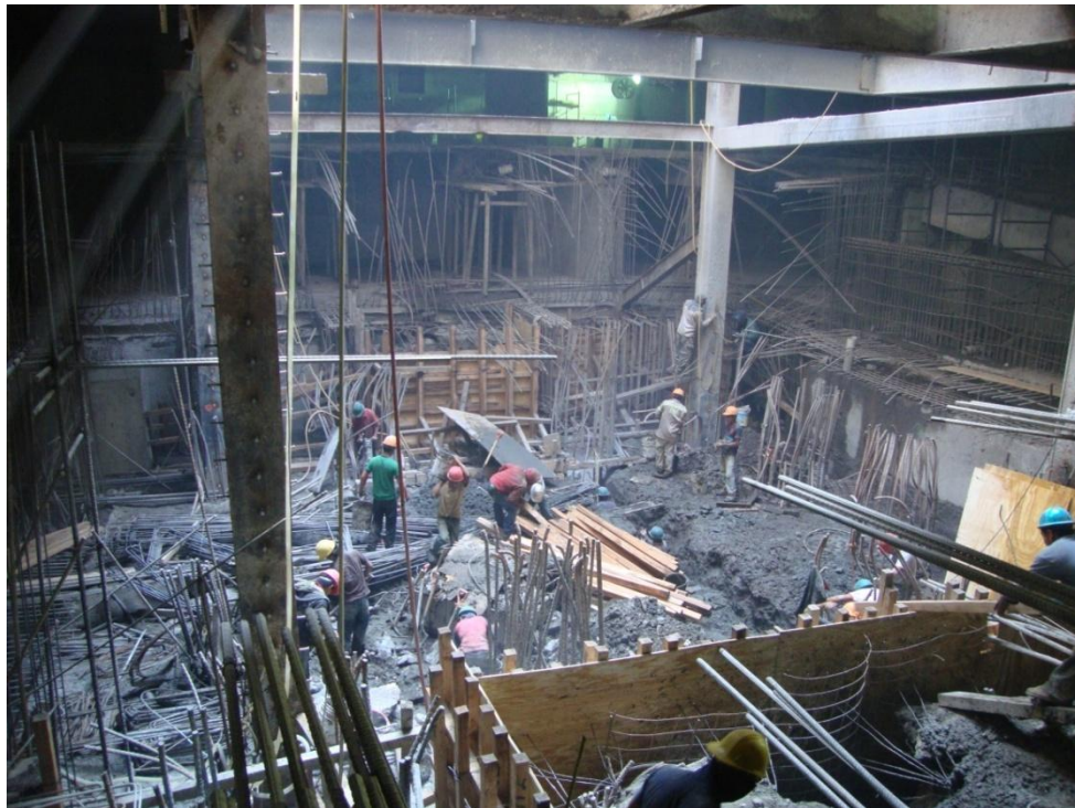
Fotografía 51.- Trabajos en losa de fondo
