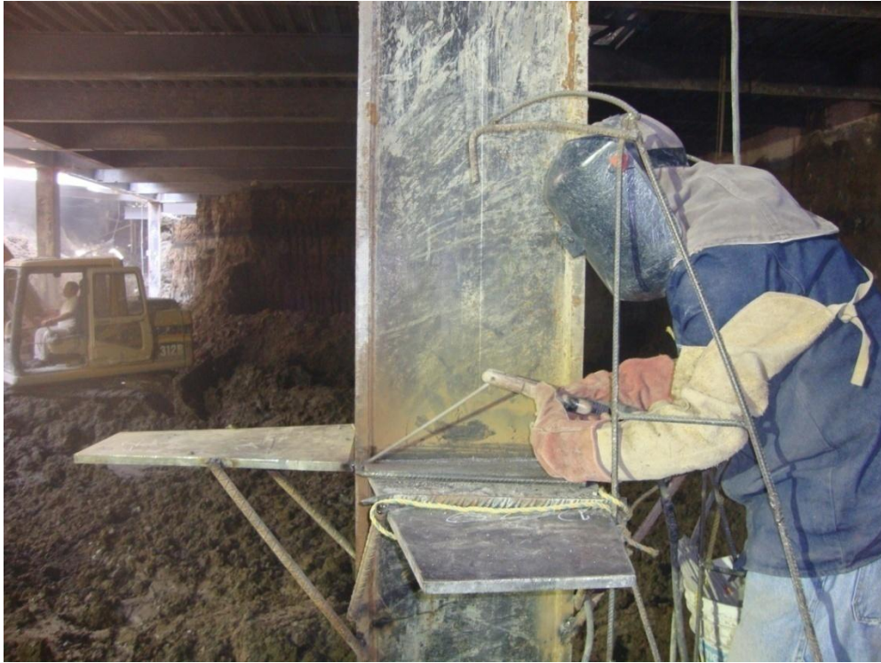
Fotografía 30.- Conexión a momento
