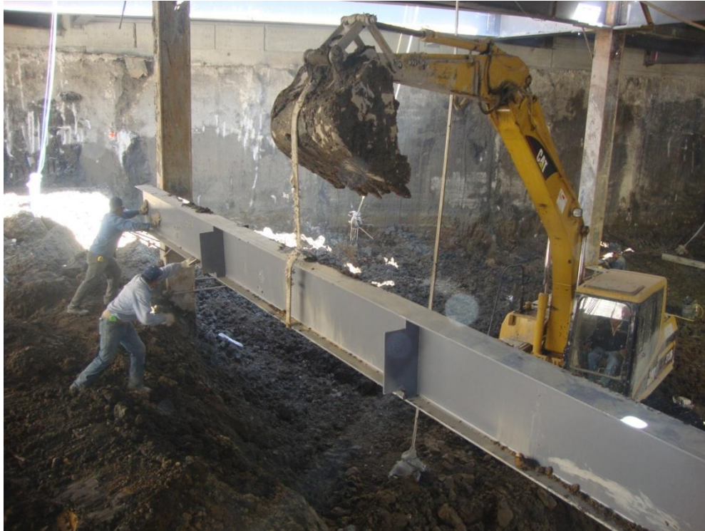
Fotografía 25.- Montaje estructura metálica con mini excavadora en sótano 1
