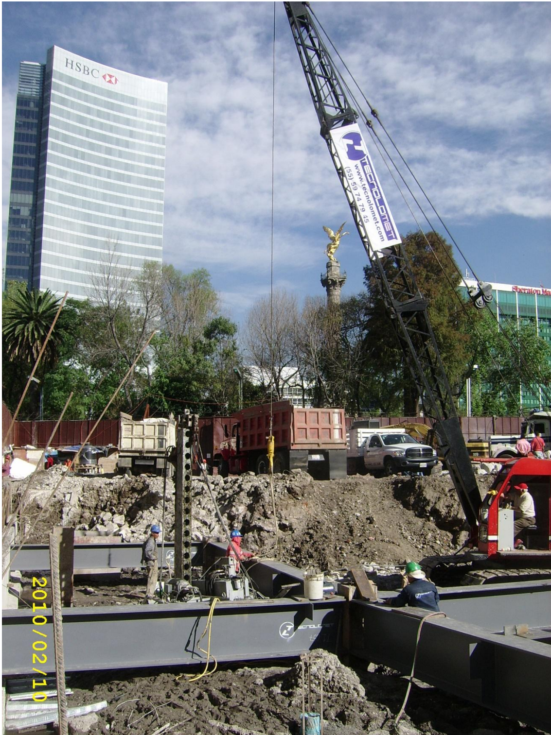
Fotografía 18.- Montaje estructura metálica en planta baja, conexión a columnas
