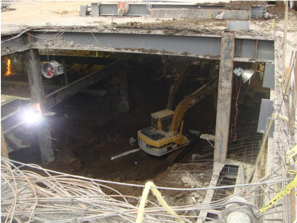
Fotografía 43.- Excavación desde lumbrera sótano 2
