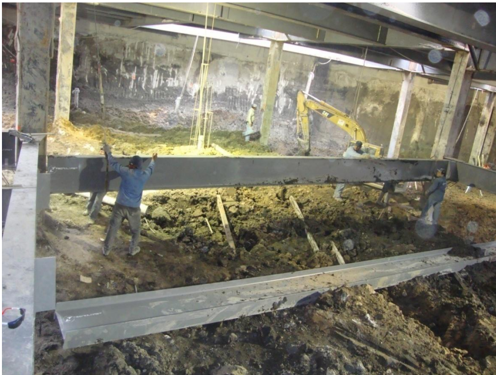
Fotografía 24.- Montaje estructura metálica con tirfo en sótano 1
