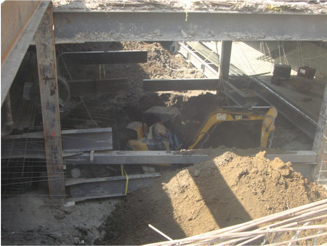
Fotografía 40.- Mini excavadora traspaleando a lumbrera
