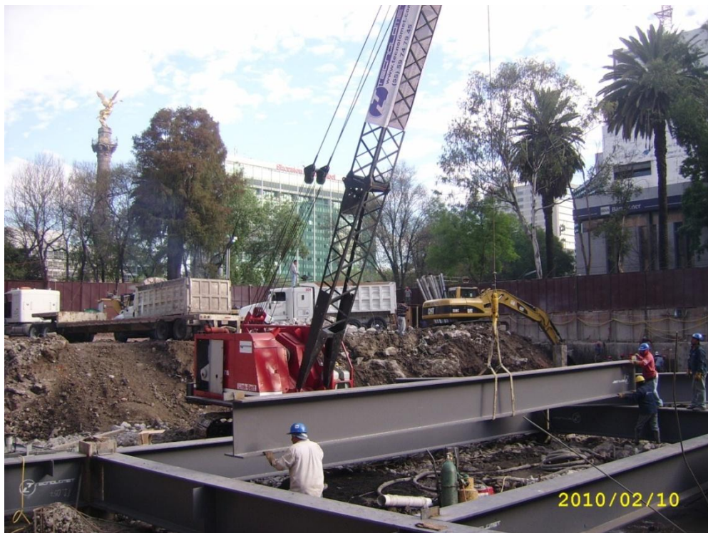
Fotografía 20.- Montaje estructura metálica en planta baja y excavación a cielo abierto
