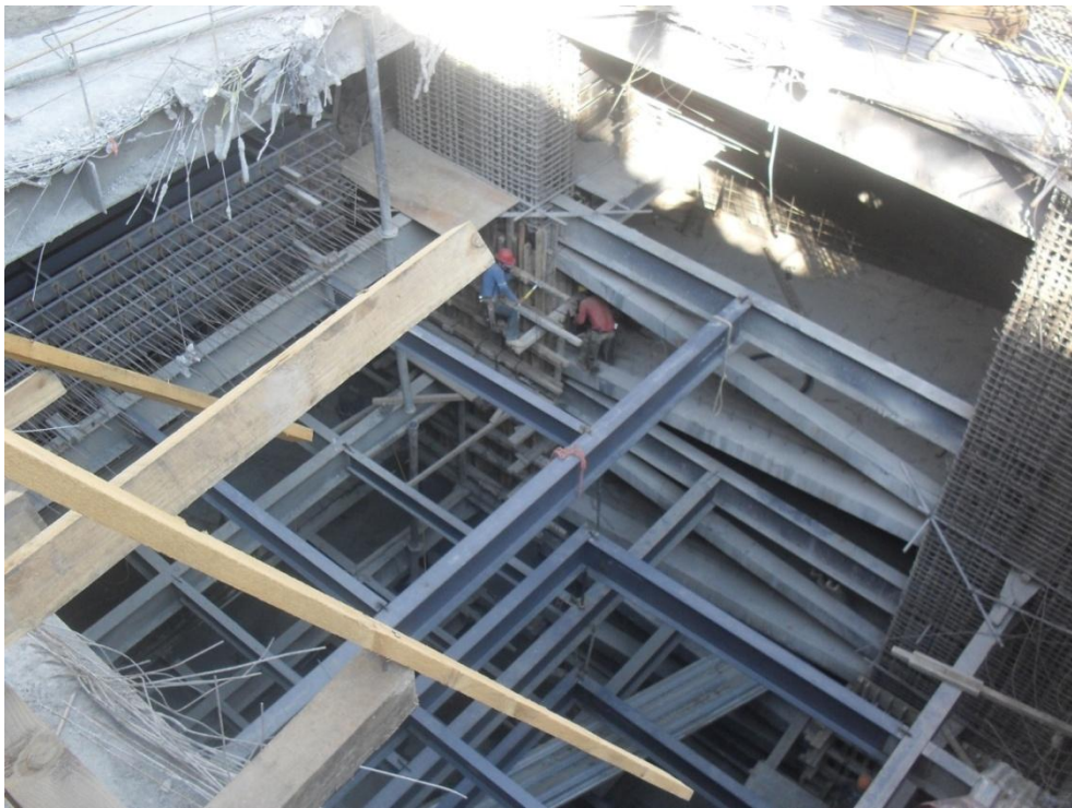
Fotografía 33.- Cierre de lumbra con estructura metálica
