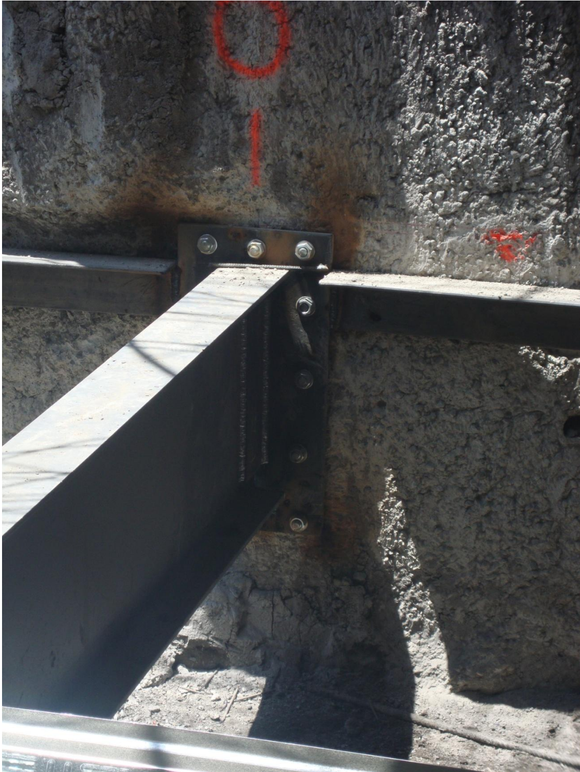
Fotografía 27.- Conexión a muro Milán y ángulo losacero
