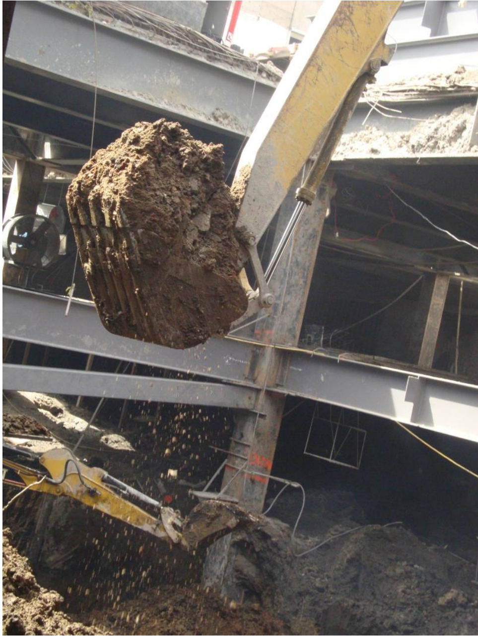
Fotografía 41.- Retroexcavadora rezagando a camión.
