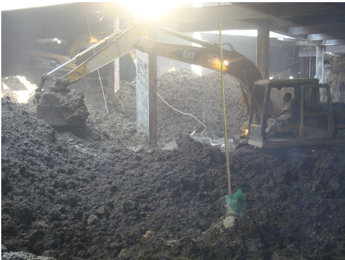
Fotografía 52.- Vista de pozo (manguera) durante la excavación
