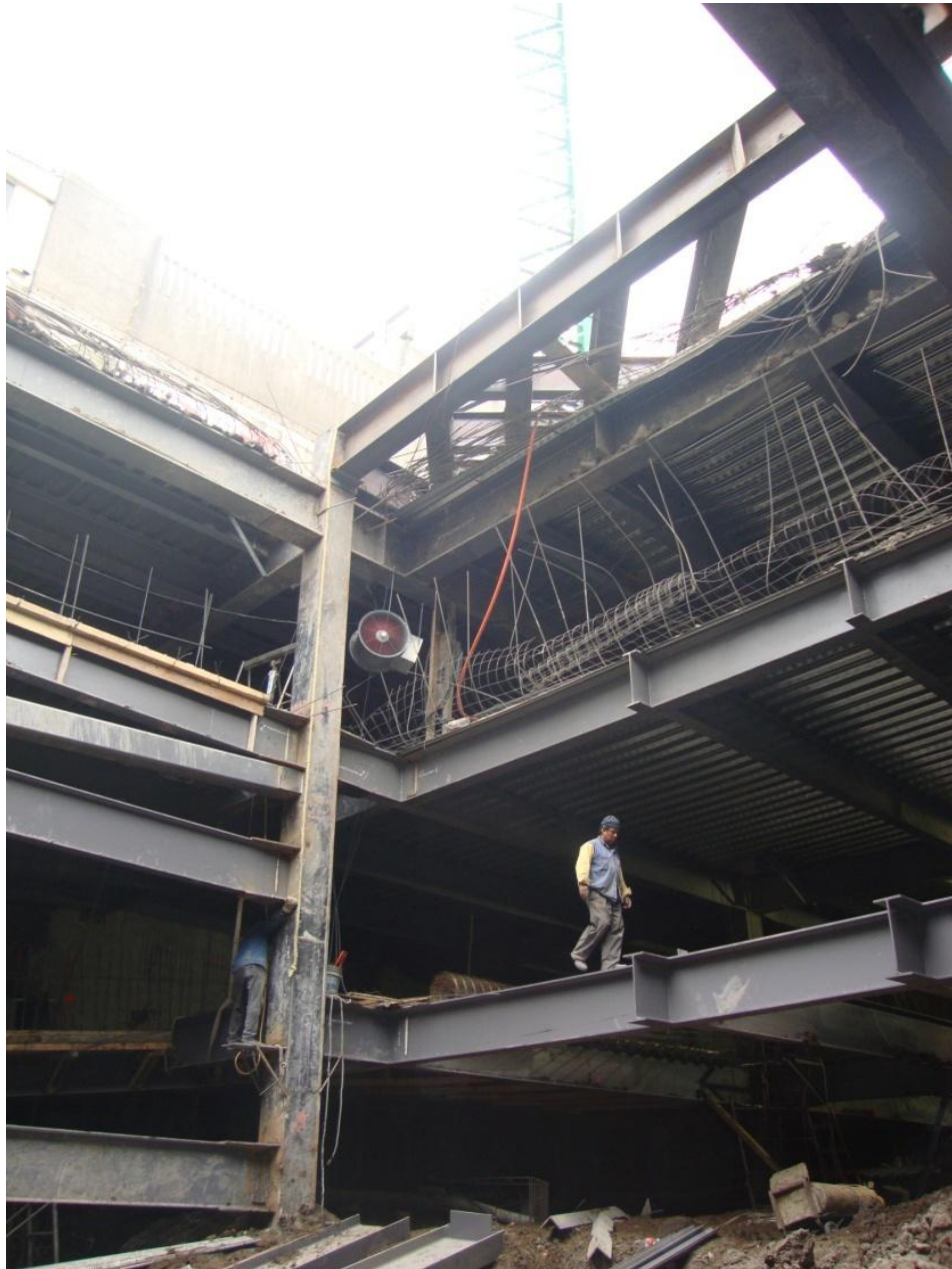
Fotografía 47.- Vista general sótano 1,2 y 3
