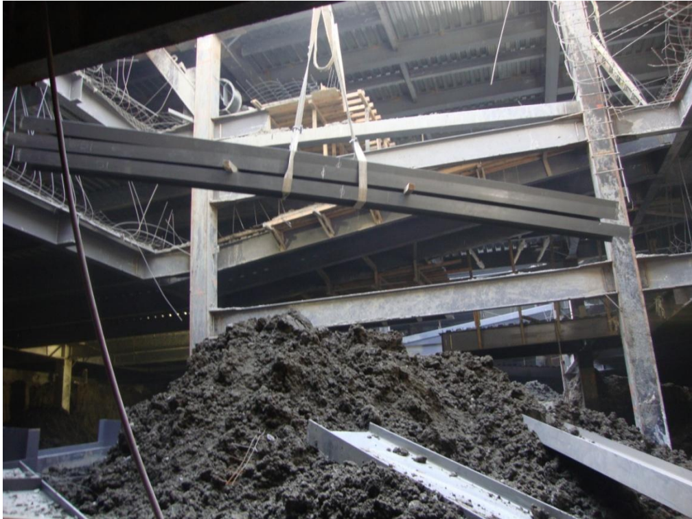
Fotografía 32.- Bajada de traveses a sótanos
