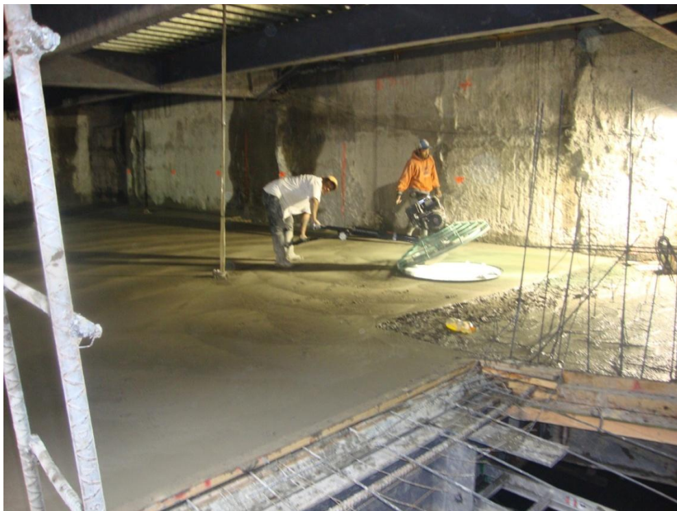
Fotografía 38.- Pulido losa
