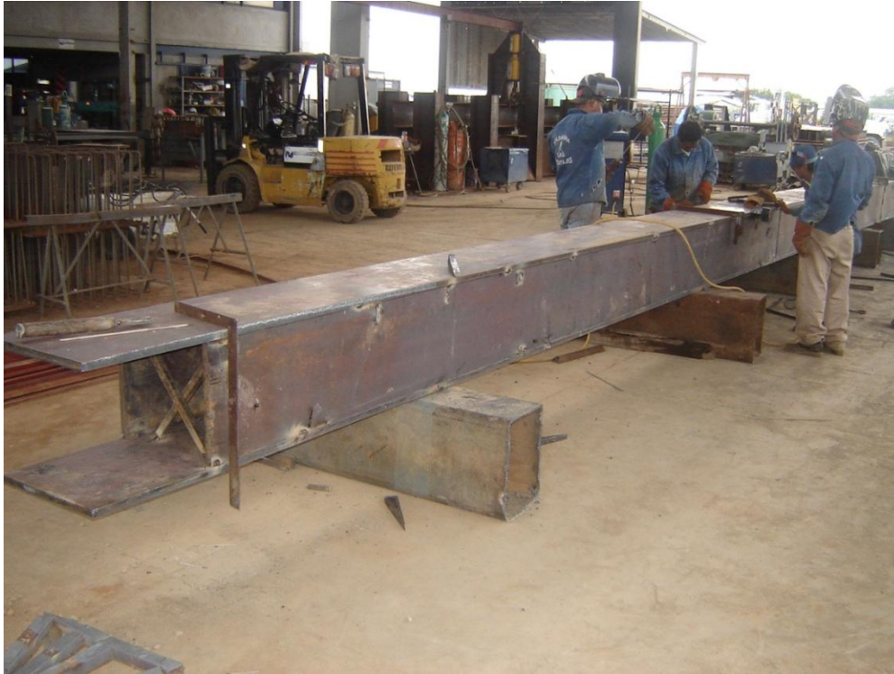
Fotografía 16.- Armado de la columna
