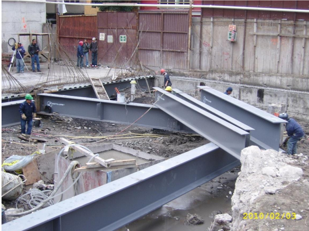
Fotografía 19.- Montaje estructura metálica en planta baja.
