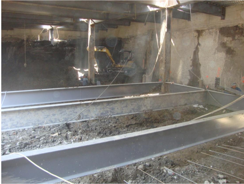
Fotografía 23.- Estructura metálica en sótano 1
