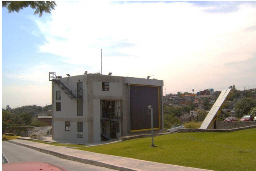
Figura 2.25 Horno Solar de Alto Flujo en México. [2.9]
