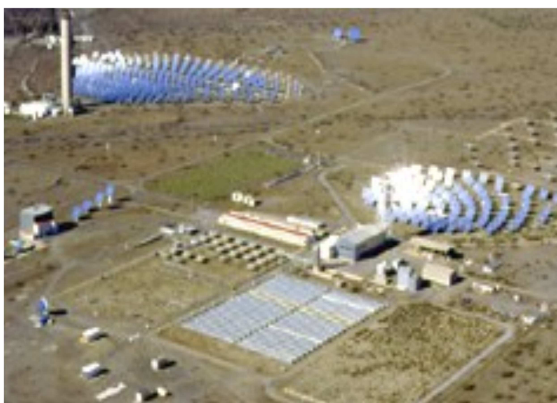
Figura 2.3 Instalación del Proyecto CESA. [2.14]
