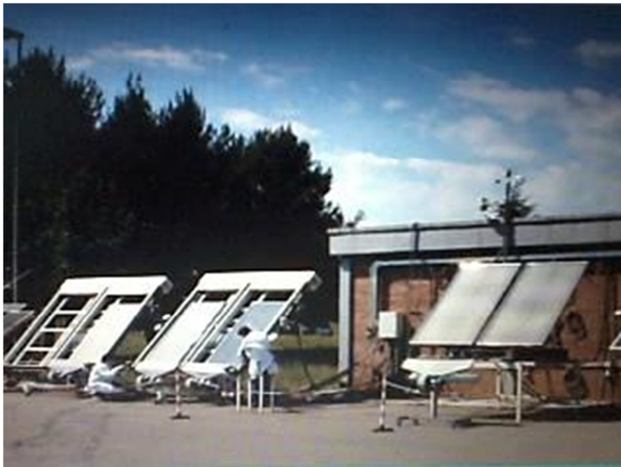
Figura 2.19 Vista de los Colectores Solares en prueba. [2.15]
