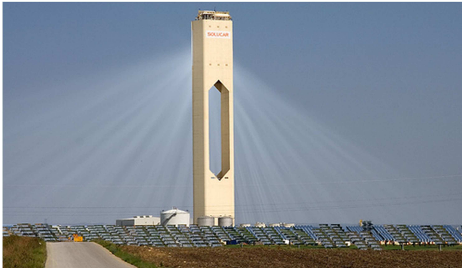
Figura 1.12 Torre Principal de una Central Solar. [1.18]
