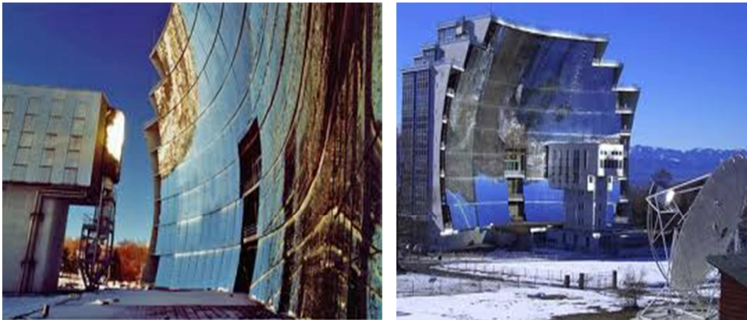
Figura 2.14 Horno solar constituido de 63 paneles solares. Horno Odelio. (Horno Solar más grande del mundo). [2.10]
