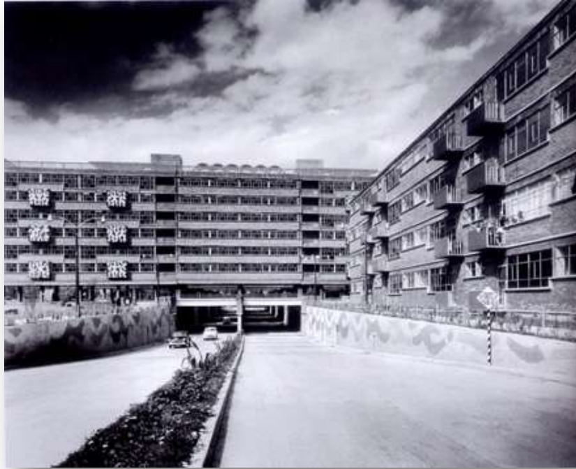
Fotografía No. 9 Paso a desnivel del Cetro Urbano Presidente Juárez, vista hacia el Sur, desde la calle de Orizaba
