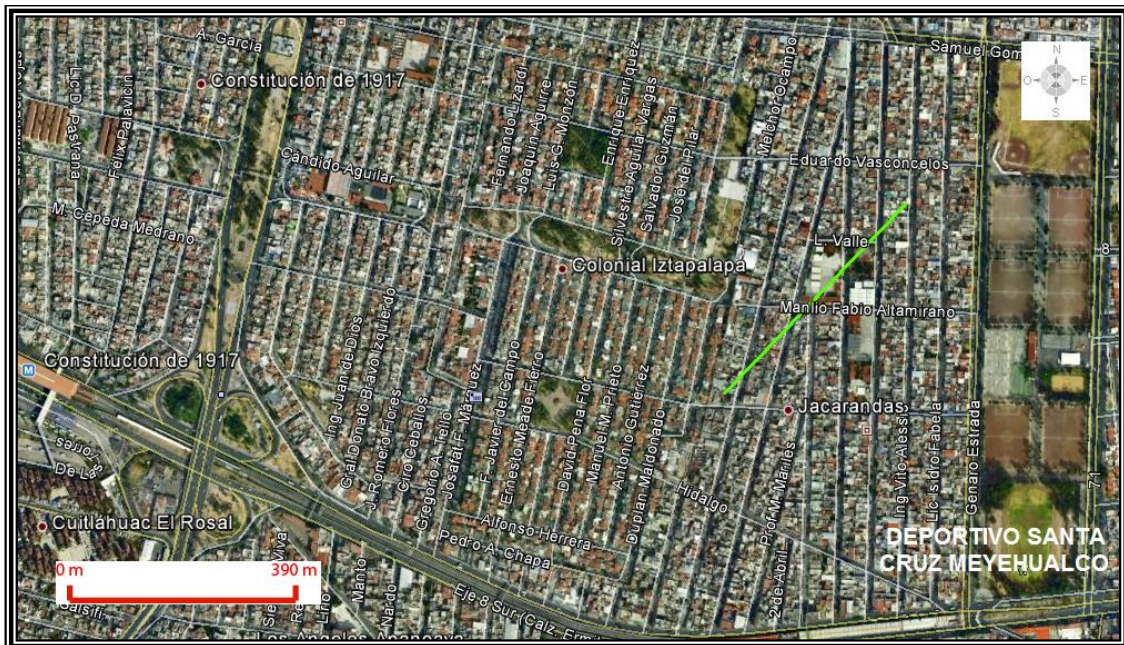
Figura 4.19. Imagen que muestra la falla representada en una imagen de Google Earth, en la colonia Jacarandas.
