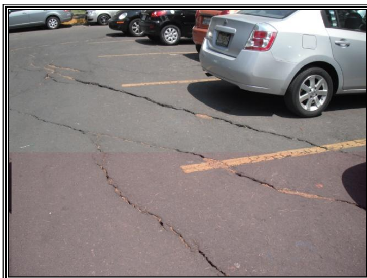
Figura 1.4.13. Fotografía tomada en dirección perpendicular al fracturamiento en un sitio en Azcapotzalco D.F.
