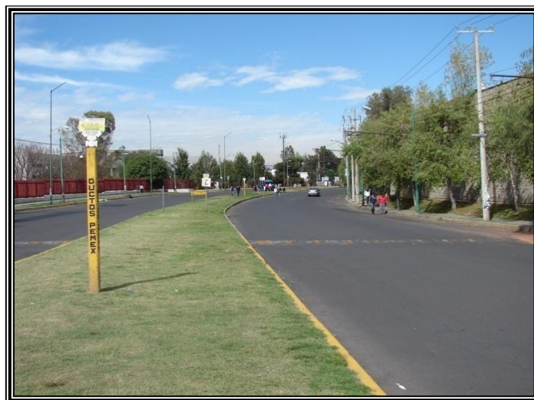
Figura 6.26. Ductos de gas de PEMEX en las inmediaciones de la Unidad Profesional Adolfo López Mateos, Campus Zacatenco del IPN; las fracturas cruzan de forma oblicua los ductos.
