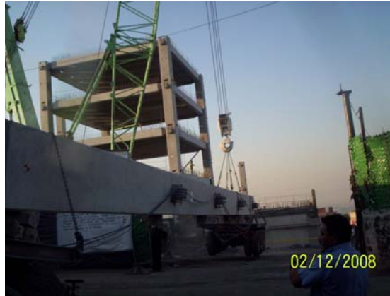
FIGURA 32. IZAJE DE COLUMNAS
