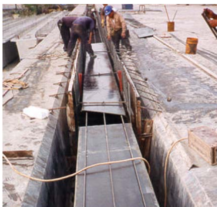
FIGURA 26. COLADO EN MOLDES
