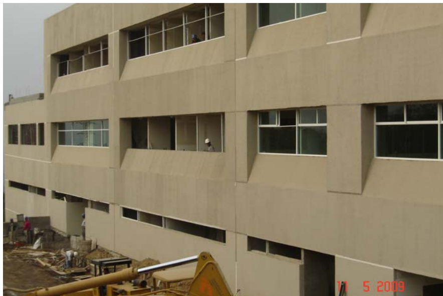
FIGURA 37. FACHADA TERMINADA, COLOCACIÓN DE VIDRIOS Y CANCELERÍA.
