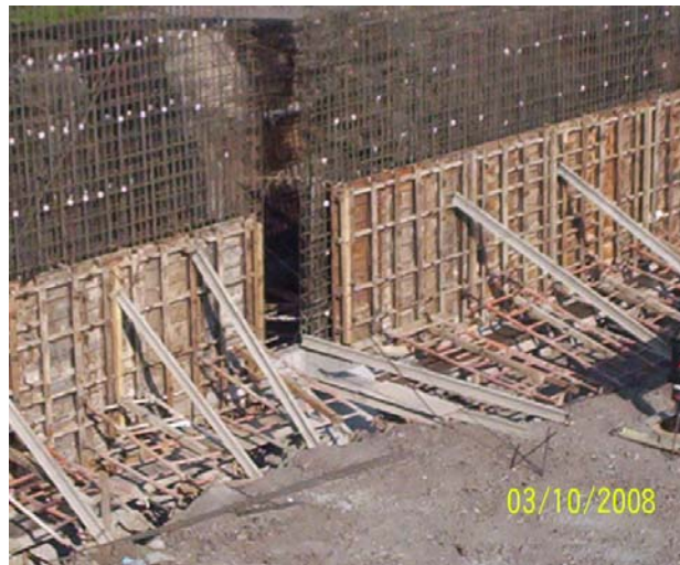
FIGURA 22. MUROS DE CONTENCIÓN
