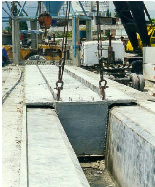
FIGURA 29. DESMOLDE DE ELEMENTOS PRECOLADOS
