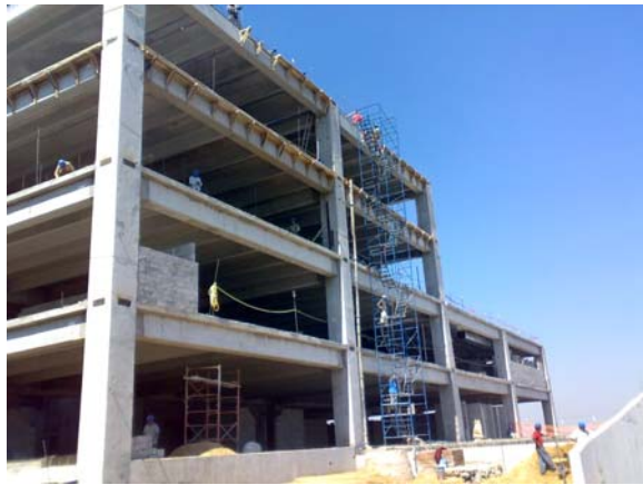
FIGURA 35. SISTEMA DE LOSAS Y COLUMNAS
