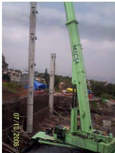
FIGURA 20. MONTAJE DE COLUMNA CON GRÚA
