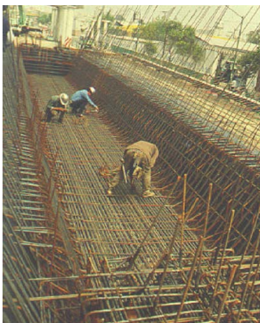
FIGURA 25. ARMADO DE TRABES
