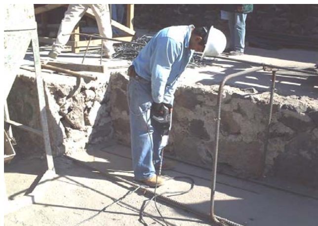
FIGURA .9 TRABAJOS DE CAMPO
