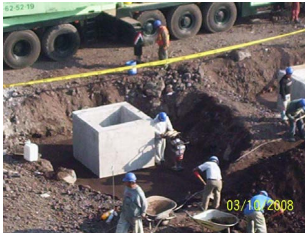
FIGURA. 12 CIMENTACIONES, DADOS DE LAS ZAPATAS AISLADAS
