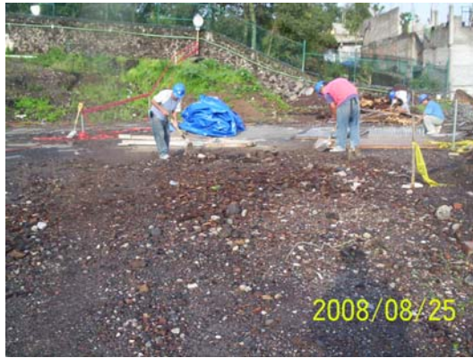
FIGURA. 14 TRABAJOS DE TOPOGRAFÍA
