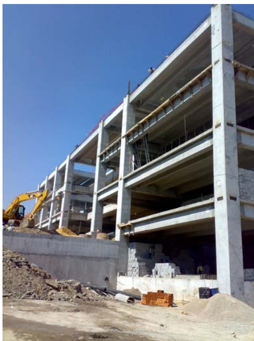
FIGURA 36. PERSPECTIVA DE LA OBRA
