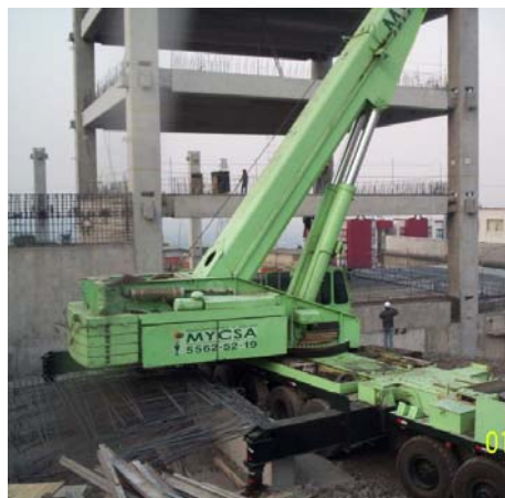
FIGURA 31. MONTAJE DE COLUMNAS
