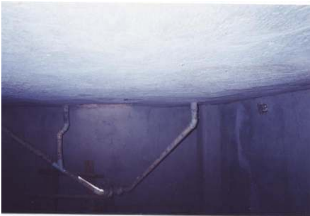
Colocación de poliducto para instalación eléctrica
