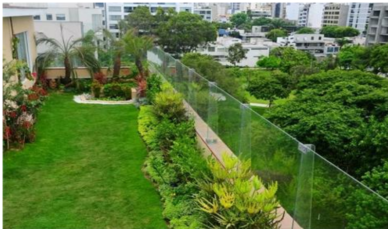
Figura 2.3. Ejemplo de azotea semi-intensiva [23].
