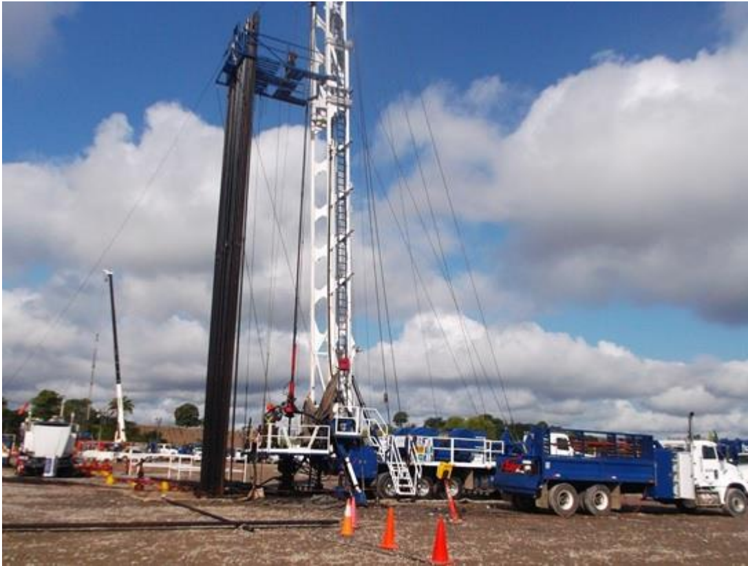
Figura 3.1 Introducción de tubería de producción con un Equipo MCU
