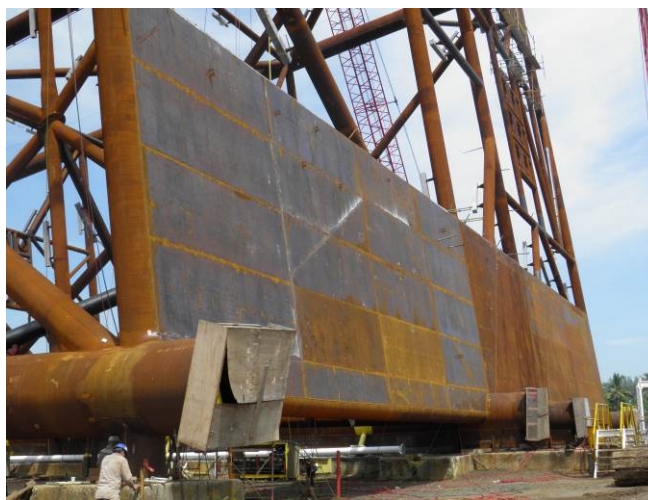
Figura 2.18. Placa base de una subestructura.
