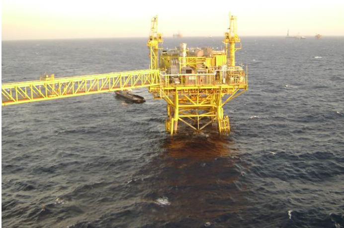
Figura 2.35. Plataforma de generación eléctrica (PG-Zaap-C).
