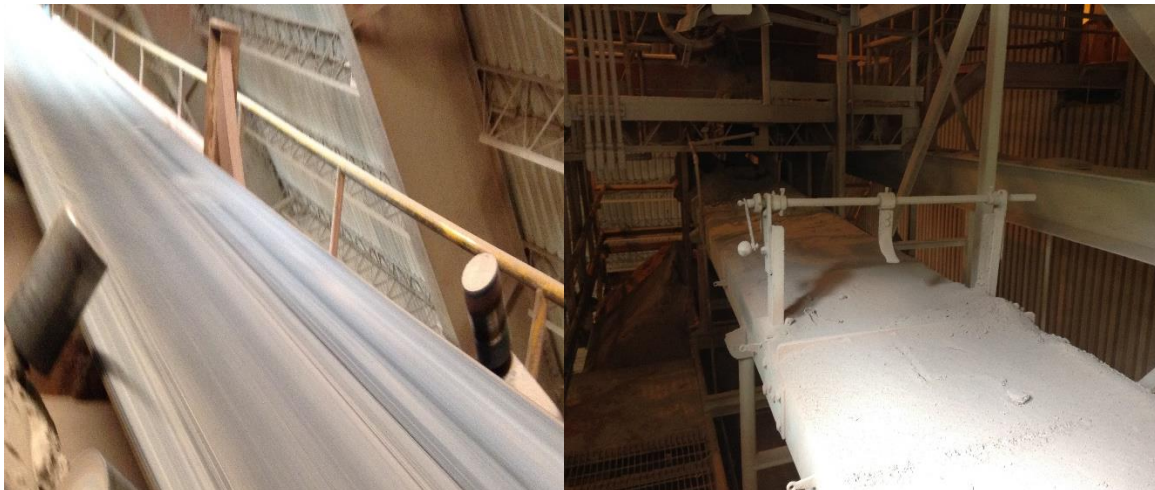
IMAGEN 7.3.5. DETECTORES DE MOVIMIENTO.
