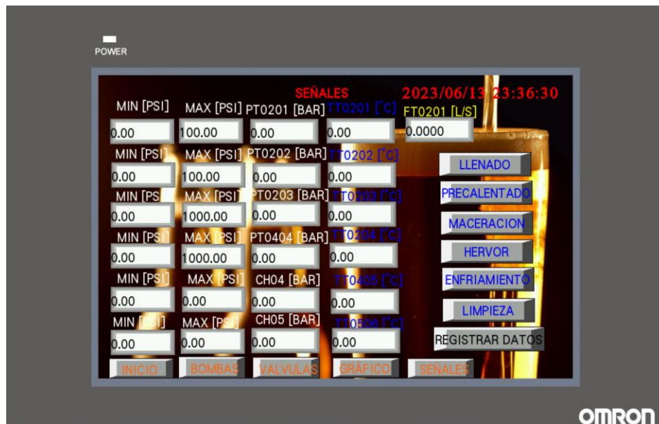
Pantalla de monitoreo de señales en HMI
