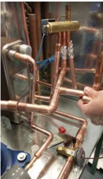
Imagen 150 Colocación provisional de las tuberías de cobre junto con accesorios
