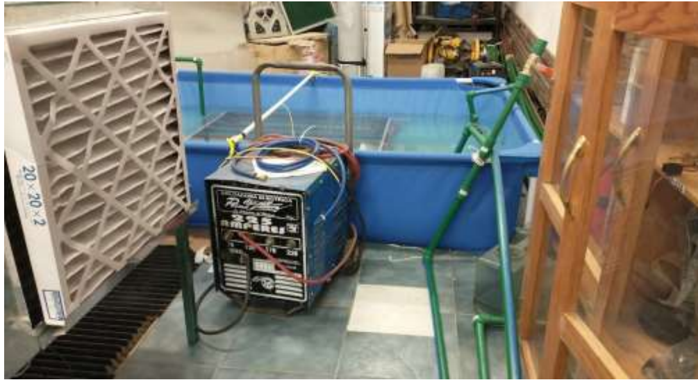
Imagen 162 Alberca para el agua de salida del intercambiador de placas
