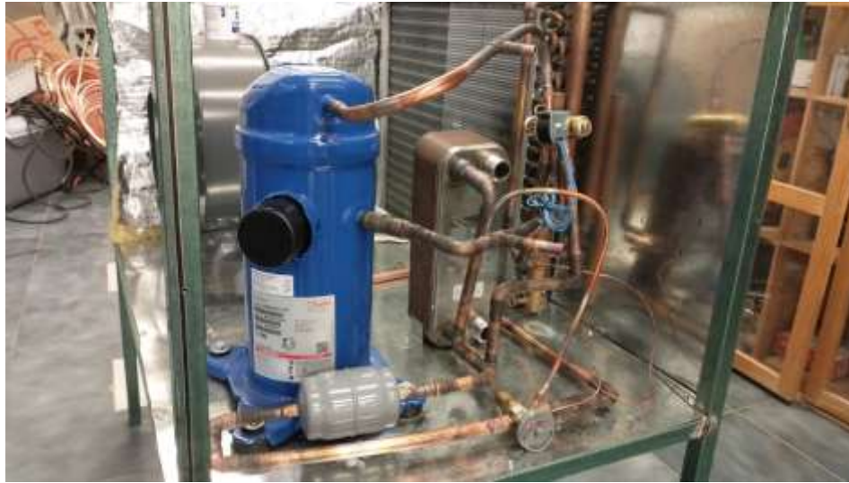
Imagen 154 Arreglo final de tuberías
