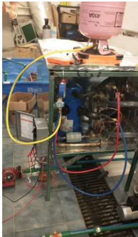
Imagen 159 Boya de refrigerante sobre báscula y conexiones del manifold
