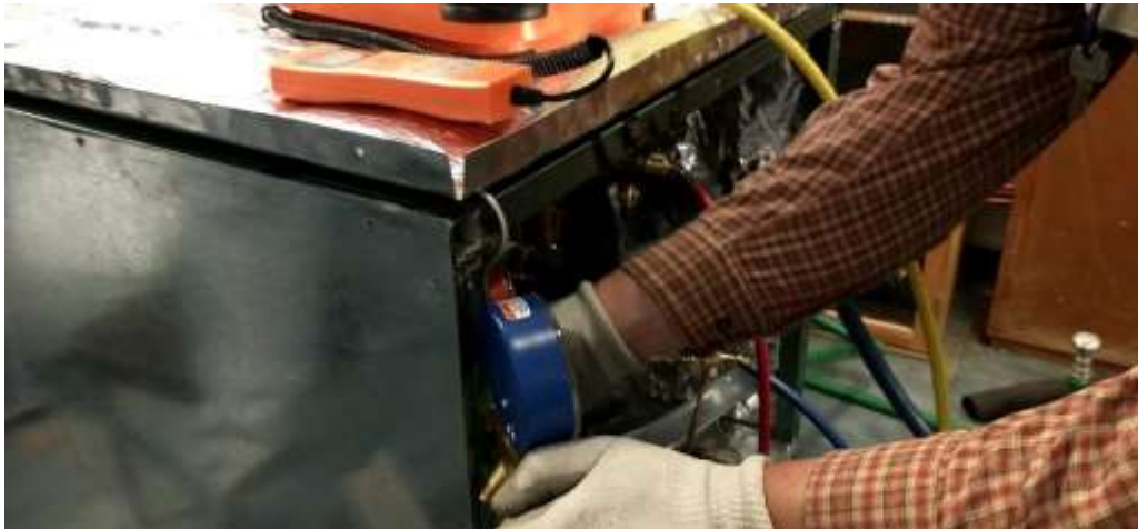
Imagen 161 Apertura de las válvulas del manifold para proseguir con el llenado de refrigerante
