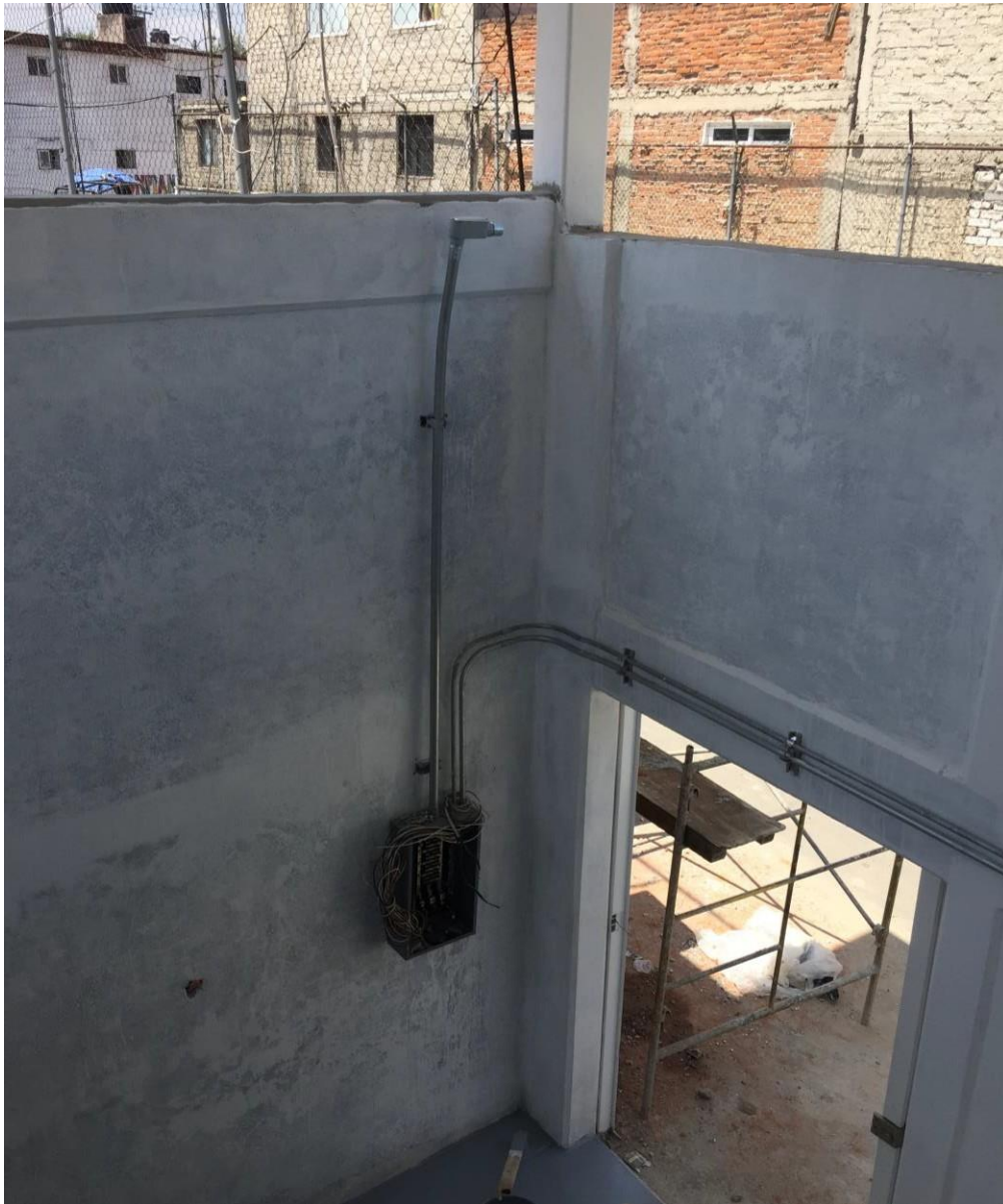
Figura 3.4 Instalación del tablero eléctrico de la planta de biodiésel
