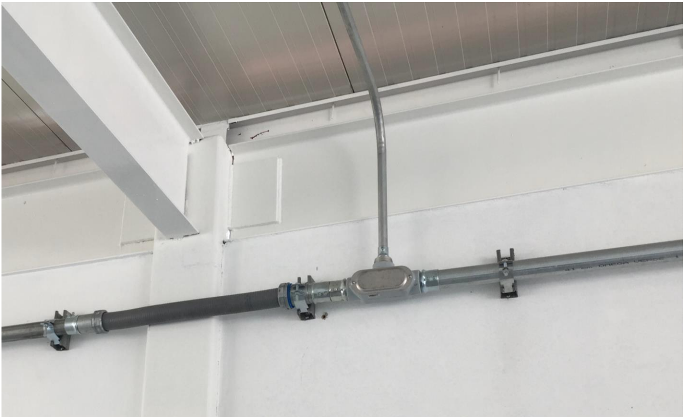
Figura 3.5 Instalación de elementos eléctricos
