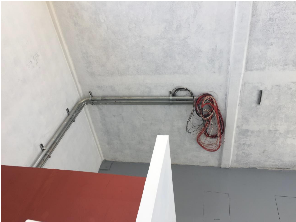
Figura 3.3 Fijación de tubo conduit
