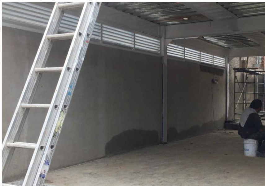
Figura 3.2 Edificio para la planta de biodiésel
