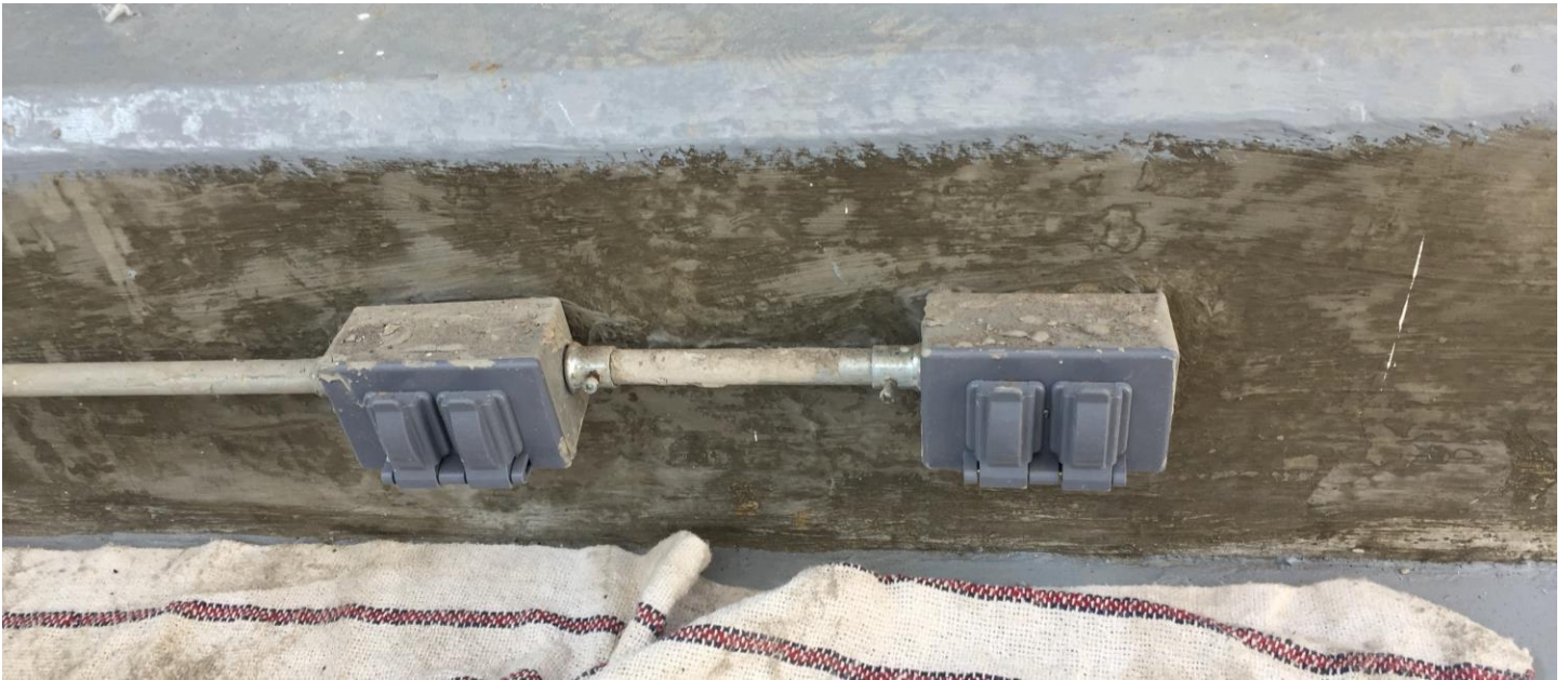
Figura 3.7 Instalación de contactos dúplex con condulet tipo Fs
