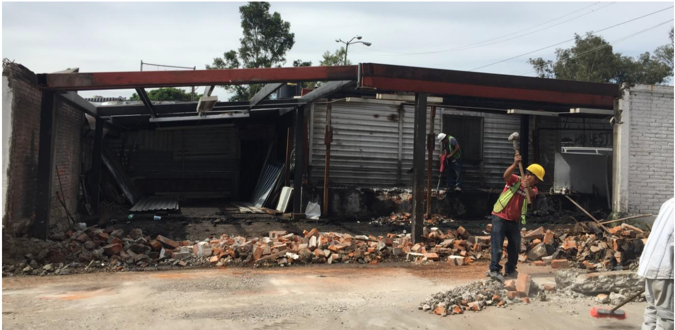
Figura 3.1 Demolición del edificio que ocupaba el lugar destinado para la planta de biodiésel
