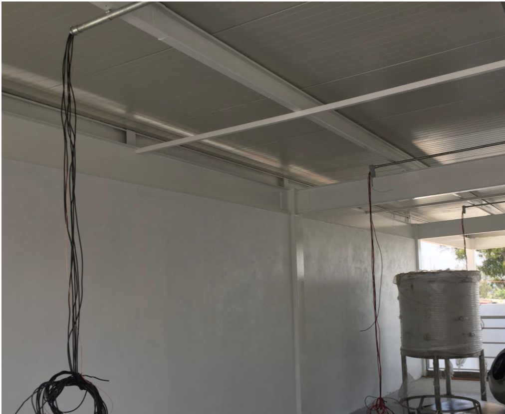
Figura 3.12 Trabajos de canalización de los conductores eléctricos
