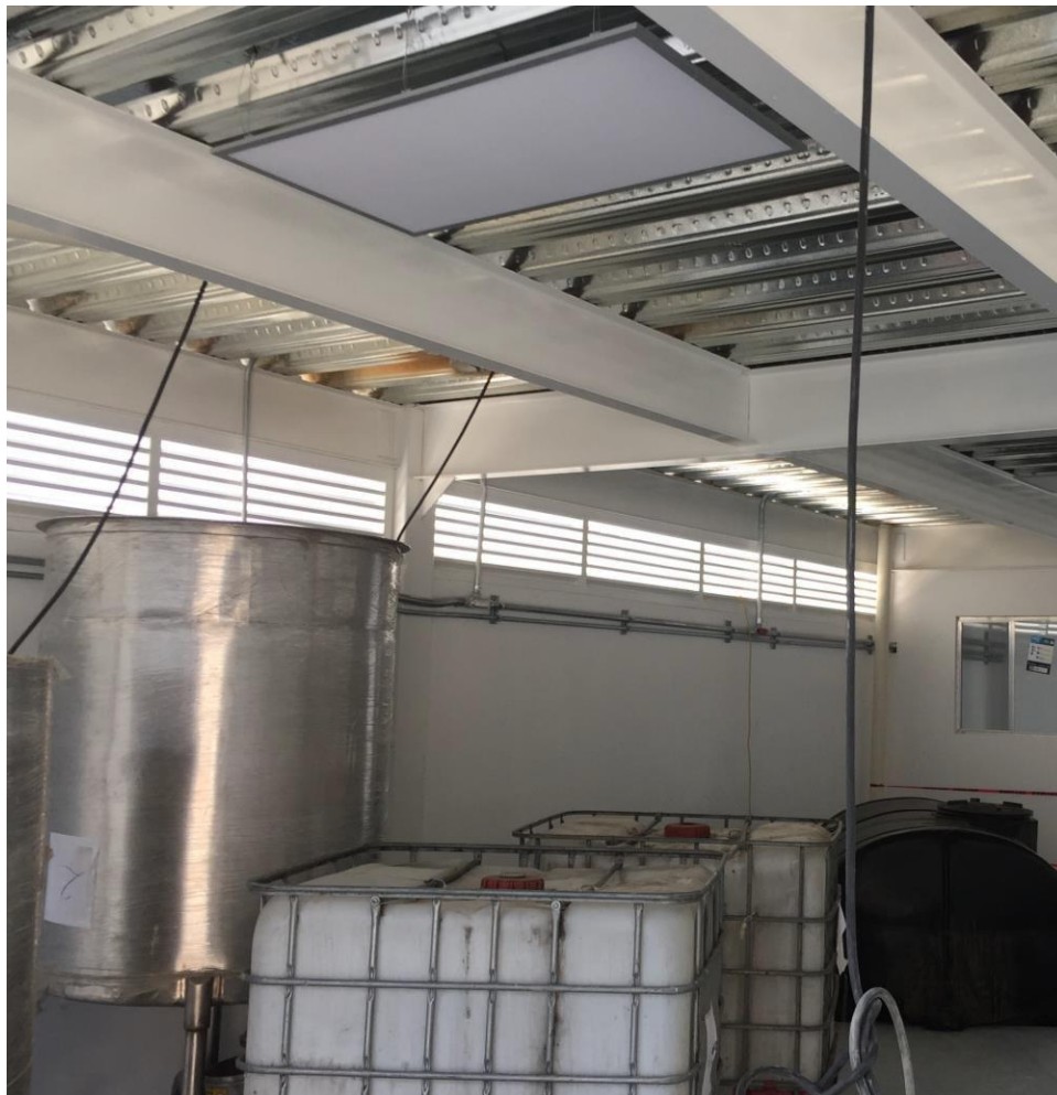
Figura 3.9 Instalación de luminaria TecnoLite Modelo Pan-Led/60W
