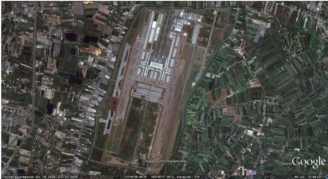
Figura 5-55 Vista Aérea del Aeropuerto Internacional de Bangkok Suvarnabhumi
