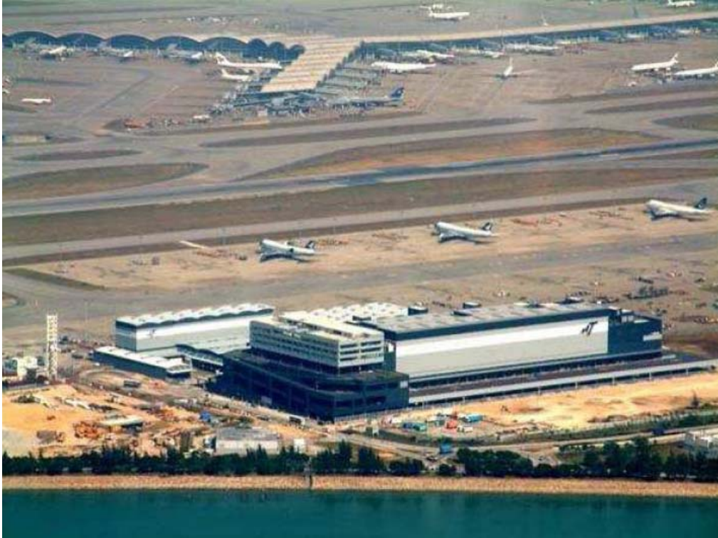
Figura 5-29 Terminal de Carga de Asia Fuente: AAT
