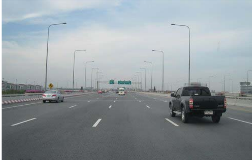
Figura 5-88 Autopista de circunvalación a BKK Fuente: Google Earth
