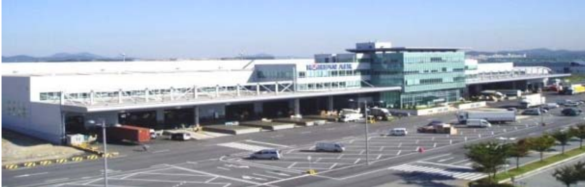
Figura 5-44 Frente de la terminal 2 de Korean Air Cargo Fuente: Korean Air Cargo
