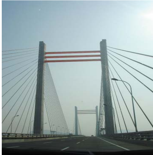
Figura 5-84 Vía de acceso al puerto de Yangshan Fuente: Google Earth
