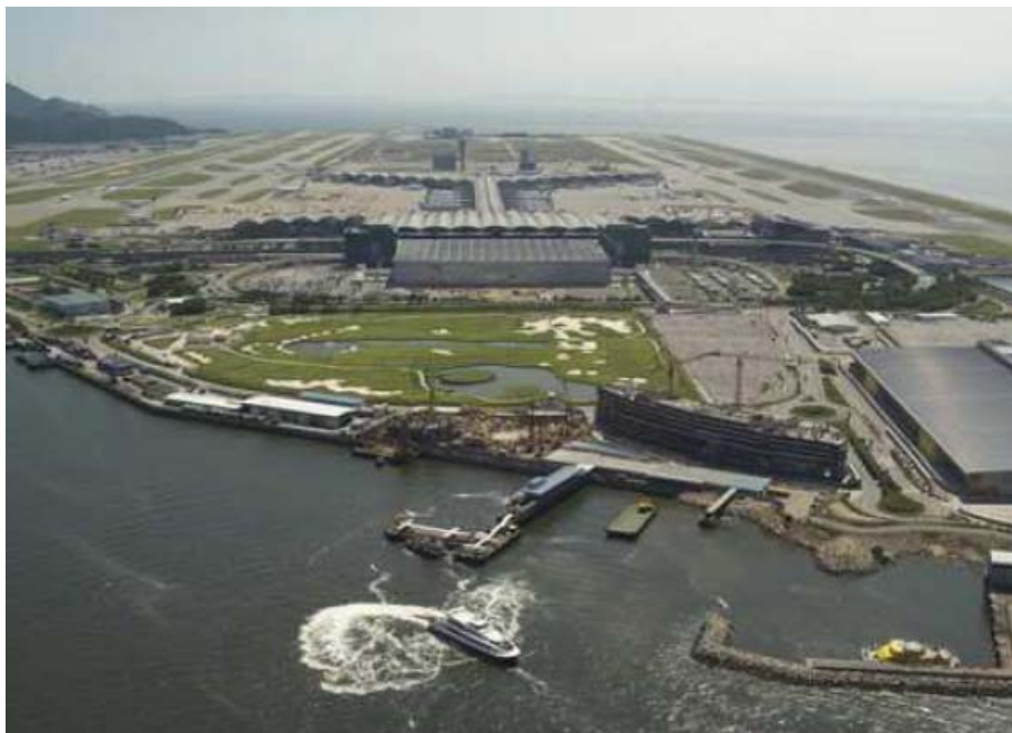
Figura 5-25 Vista aérea de HKG
