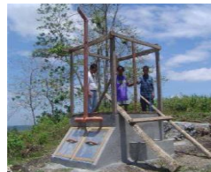
Figura 4.50 Construcción de un sistema de cámaras de deshidratación.
