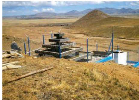
Figura 4.22 Aireador combinado con filtros ascendentes en la comunidad Tahari de Bolivia.
