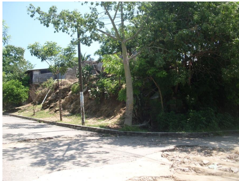
Fotografía. 25., Casas a la orilla de un talud con posibilidad de derrumbe colonia H3
