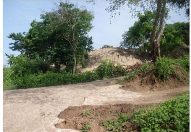
10.- Deslizamiento cerca de escuela (El Faisán)
