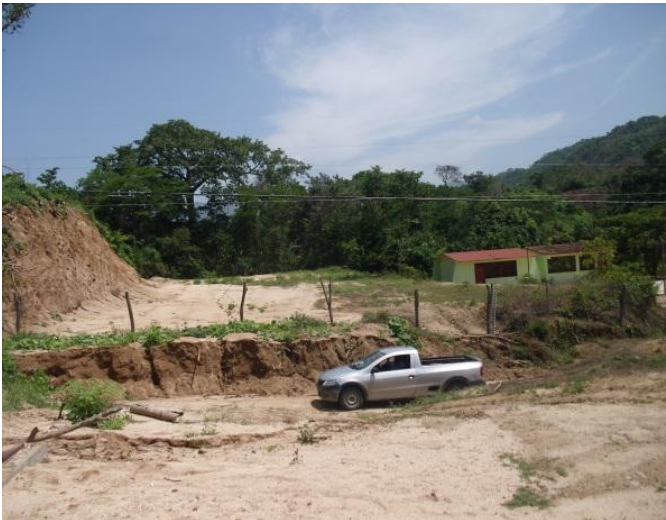
Fotografía 11.- Posible deslizamiento Escuela, Las Pozas
