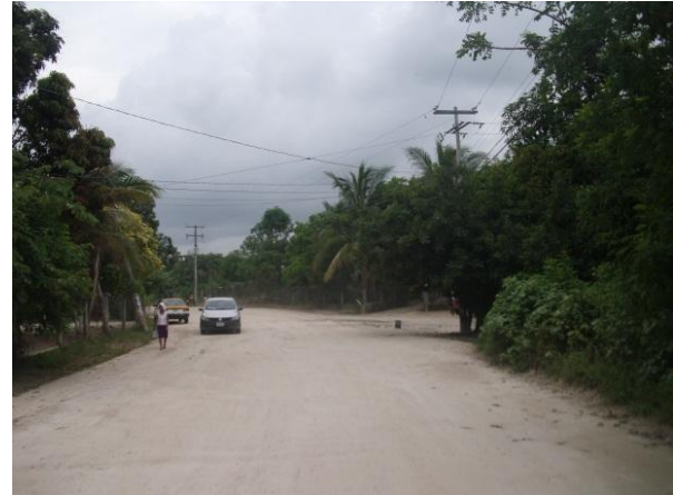
Fotografía 18.- Erosión en Colonia Tejal Santa María Huatulco
