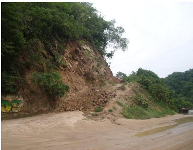
Fotografía 5.- Derrumbe Puente de Coyula
