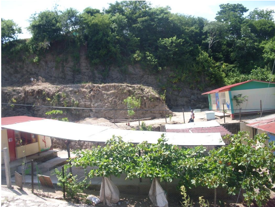
Fotografía 24., Kinder ubicado en una ladera peligrosa colonia H3
