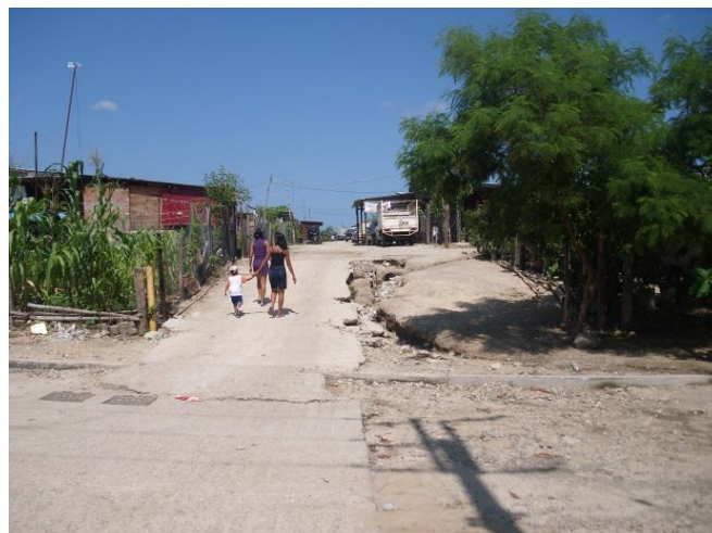
Fotografía 29. Asentamiento de casas afectadas por erosión
