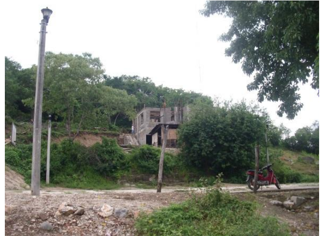
Fotografía 14.- Ladera peligrosa (Bajos de Coyula)
