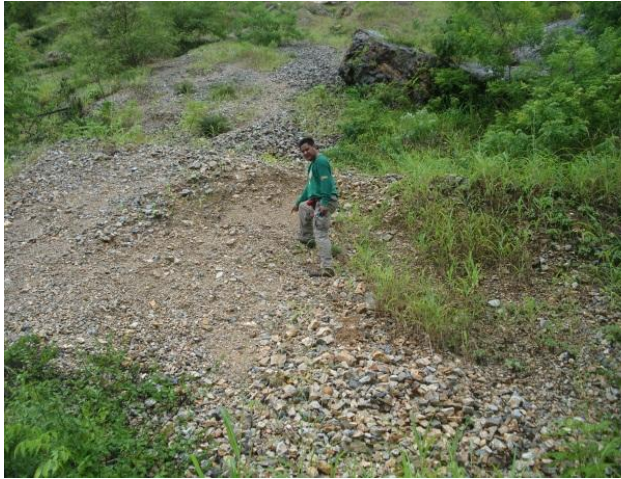
Fotografía 7.- Derrumbe Falla Chacalapa (Chacalmata)
