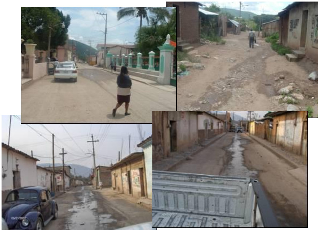
Descargas de aguas residuales hacia la calle.
