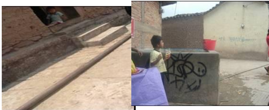
Red de agua potable superficial y piletas (hidrantes) sobre la calle.
