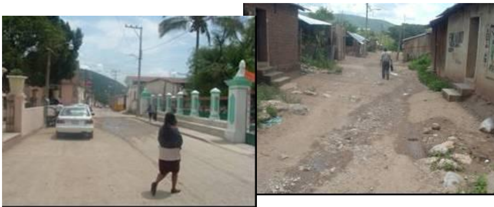
Escurrimiento de aguas residuales en las calles.
