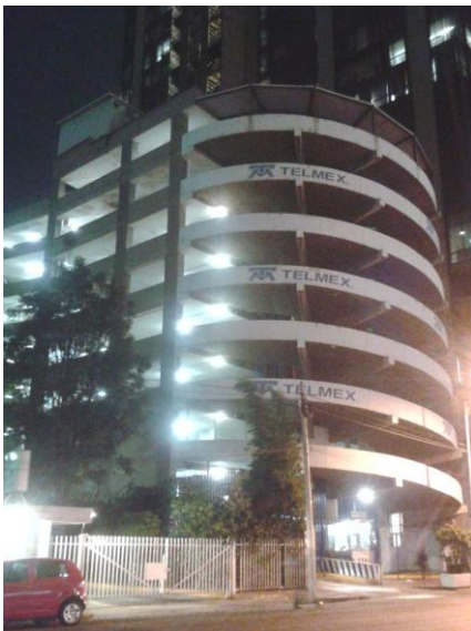
Figura 26) Rampa de Caracol estacionamiento Telmex esq. Av. Universidad y Río Churubusco. Elaboración propia 2011.
