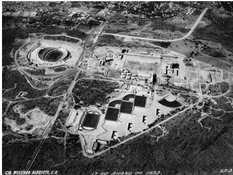
Figura 3) Vista aérea de Ciudad Universitaria, Enero 1952.
