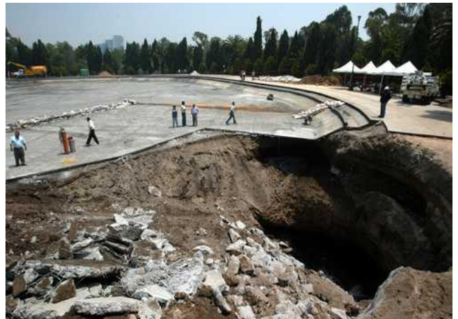
Fotografía 13. Fisura vista desde otra perspectiva
