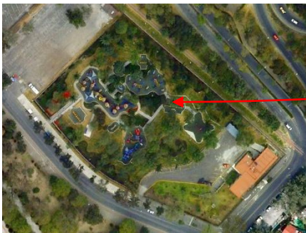
Figura 19a Construcción de nuevas instalaciones dentro del Bosque
