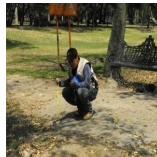
Fotografía 8. Camino peatonal colapsado en donde se observa el desnivel del piso.
