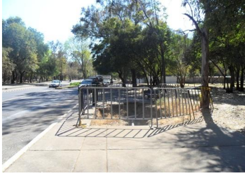
Fotografía 1. En donde se muestra la cavidad de una mina antigua expuesta en la superficie; en la cercanía del estacionamiento de GLM Comunicaciones.
