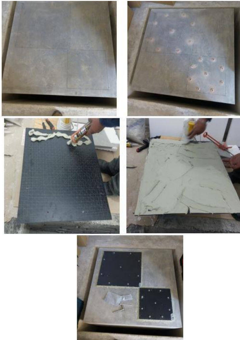
Fig. 3.9 Procedimiento de instalación de la base de los sensores. Proporcionada por F. Navarro.
