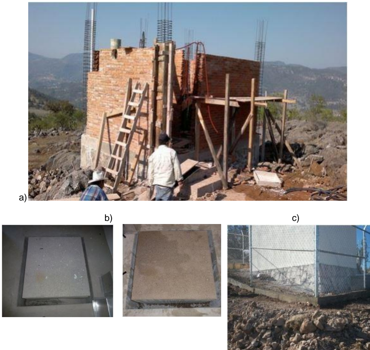
Fig. 3.4 a) Construcción de los muros de una estación sísmológica. b) Pilar donde se colocan los instrumentos sísmicos. c) Malla ciclónica exterior. Imágenes proporcionadas por F. Navarro.
