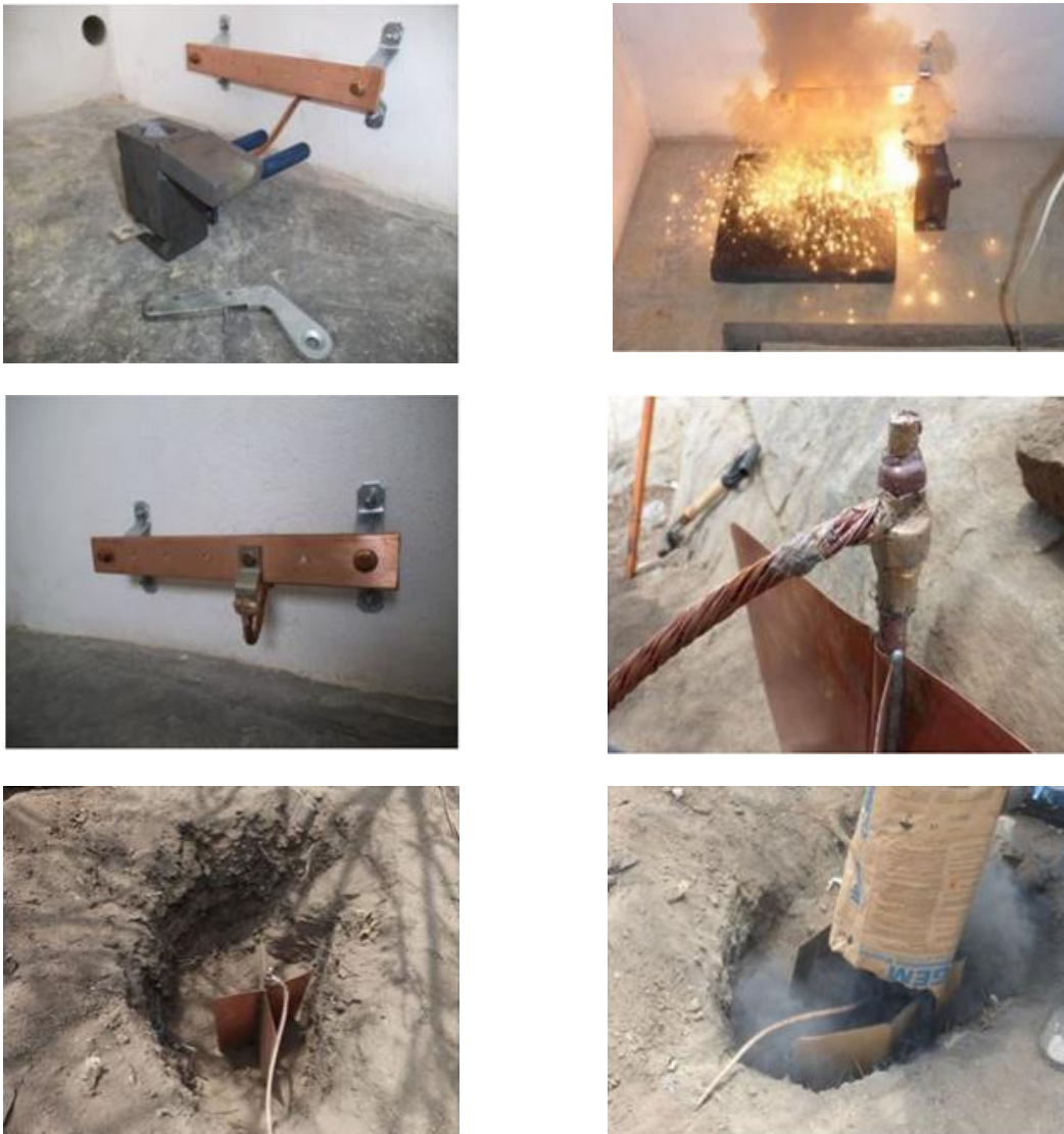
Fig. 3.5 Construcción de la tierra física. Imágenes proporcionadas por F. Navarro.
