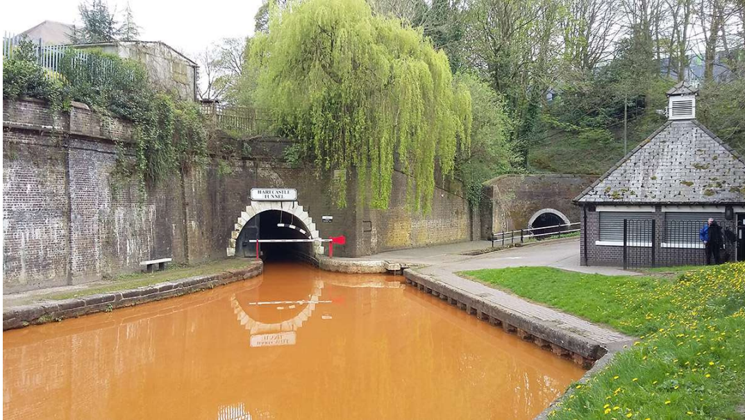
Figura 1.12. Túneles de Harecastle, izquierda túnel construido por Telford (1783) y derecha túnel construido por James Bradley (1777), Francia. Ref. [27].
