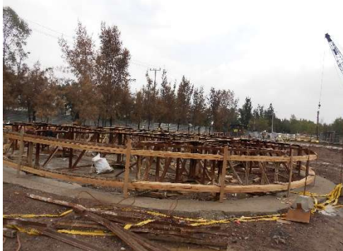
Figura II.83. Fabricación de tanque de flotación, [Cortesía ICA, Arq. Lizbeth Vazquez V.]
