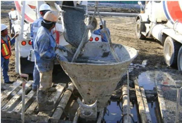
Figura III.50 Colado de Muro Milán con tubería Tremie [Cortesía Ing. Daniel Falcao]
