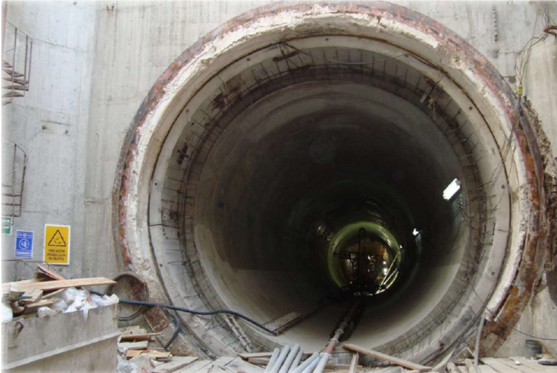
Figura III.159 Preparación de acero de refuerzo para traba de borde, [cortesía ICA].
