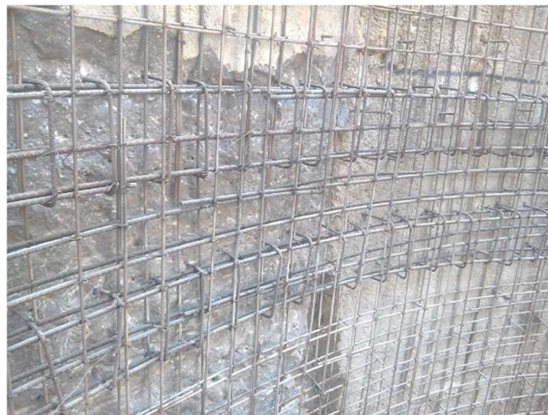
Figura III.71 Acero de refuerzo de anillo de rigidez [Cortesía ICA]
