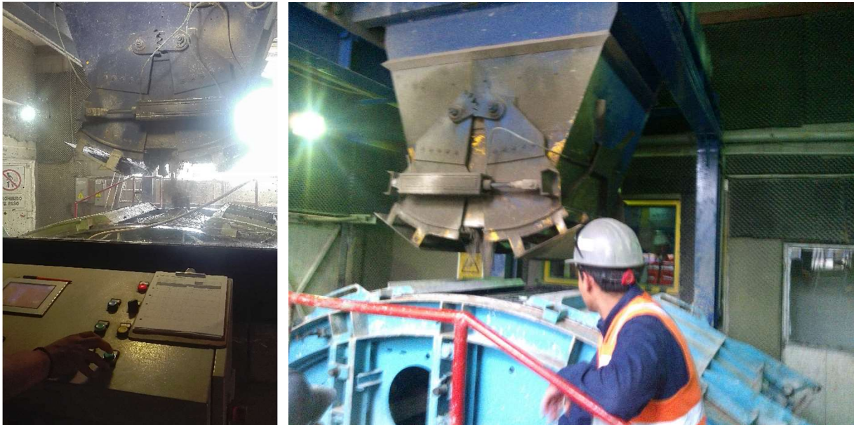
Figura II.38. Cámara de colado de dovelas. [Propia y Cortesía ICA, Ing. Eduardo Zaragoza]
