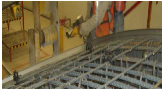
Figura III.105 Cerrado del molde [Cortesía Ing. Carlos J. Ilhuicatzí González].
