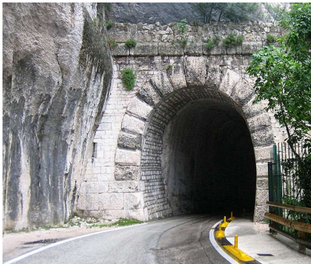
Figura 1.9. Túnel de Furlo (Nápoles), Italia. Ref. [21].
