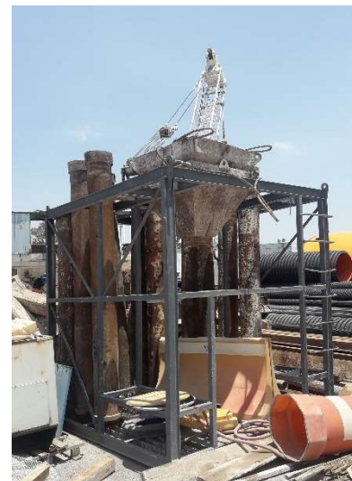
Figura II.67. Tubería Tremie, [Cortesía ICA].
