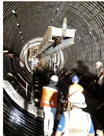
Figura II.80. Grúa pórtico y trabe carril, [Propia]
