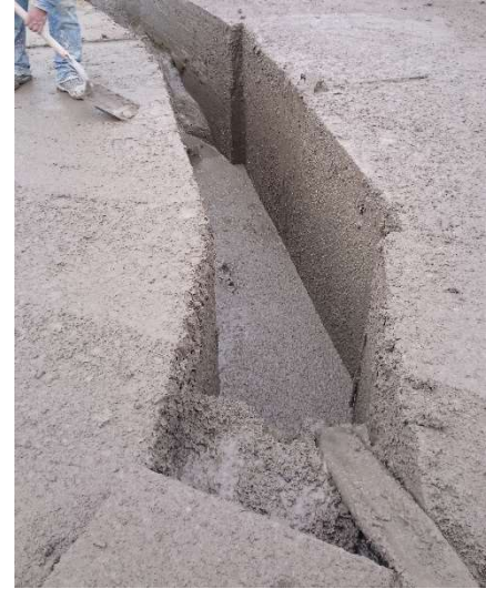
Figura III.40 Excavación de paneles de pantalla perimetral. [Cortesía Ing. Daniel Falcao].
