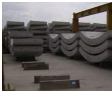
Figura III.120 Acopio de dovelas [Cortesía ICA].
