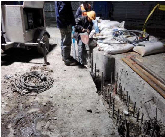
Figura III.53 Descabece de Muro Milán [Cortesía ICA]
