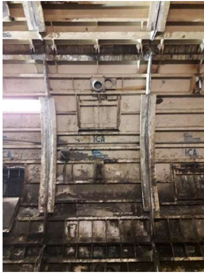
Figura III.156 Ventanas de hastial de cimbra telescópica [Propia].
