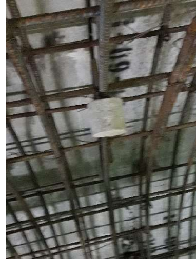
Figura III.149 Separador de concreto en lecho Superior, [Propia].
