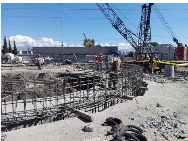
Figura III.55 Colocación de acero de refuerzo de trabe de coronamiento [Cortesía Ing. Rosalba Trujillo Pech]
