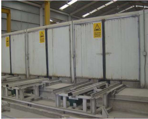
Figura III.112 Cámara de curado de dovelas
