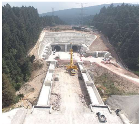
Figura 1.63. Plataforma del Portal Poniente del tren interurbano México-Toluca, Estado de México. Ref. [94].
