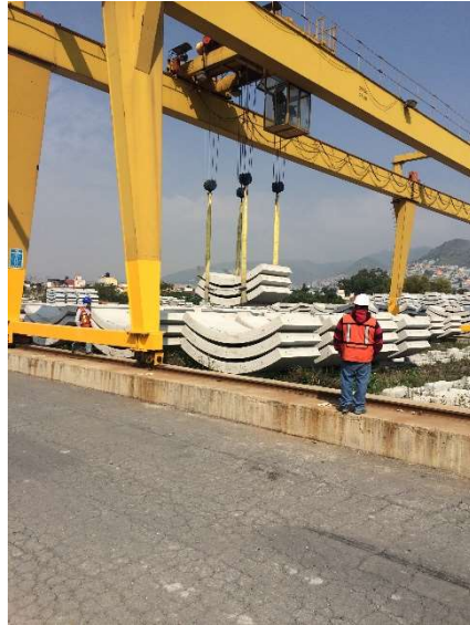
Figura II.46. Grúa tipo portal de 50 m de claro, 24 toneladas de capacidad, [Cortesía ICA]
