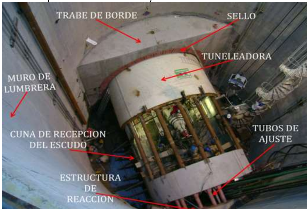
Figura III.134 Sistema de atraque en lumbrera, cortesía ICA.
