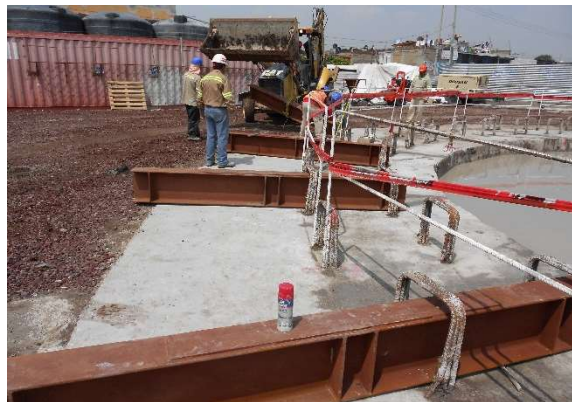
Figura III.19 Viguetas metálicas de atraque. [Cortesía Arq. Lizbeth Vázquez V.].
