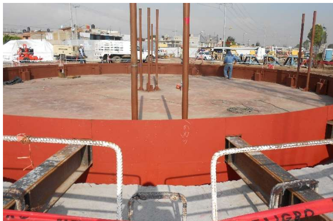
Figura III.22 Sujeción de tanque de flotación, [Cortesía Arq. Lizbeth Vázquez V.].
