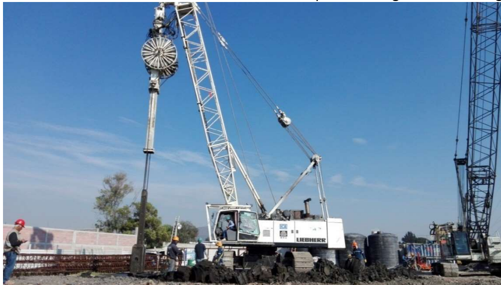
Figura III.36 Excavación de paneles de pantalla perimetral. [Cortesía Ing. Daniel Falcao].
