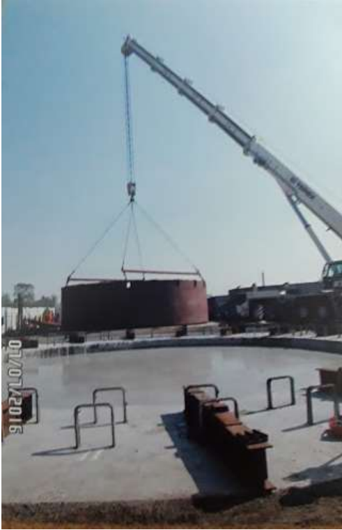
Figura III.20 Izaje y colocación de tanque de flotación en lumbrera [Cortesía Ing. Pedro Barrios].
