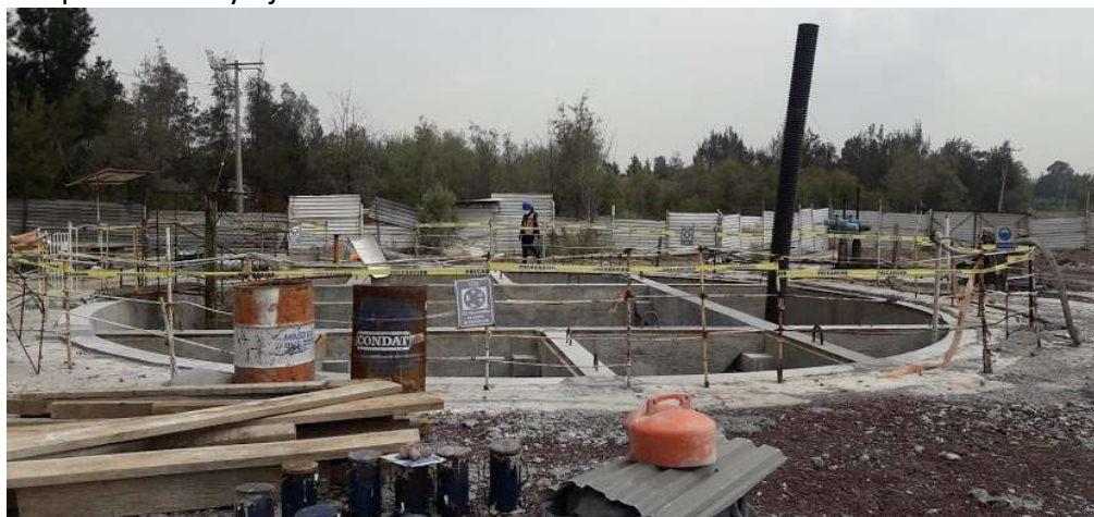
Figura III.93 Losa tapa de Lumbrera, [Propia].
