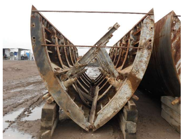
Figura III.152 Ensamble de cubeta de cimbra telescópica en superficie [Cortesía M.I Mario A. Aguilar Téllez].
