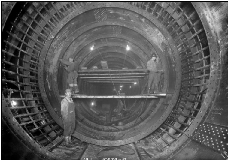
Figura 1.24. Fotografía del túnel del acueducto Delaware, (Nueva York), E.U.A. Ref. [48].
