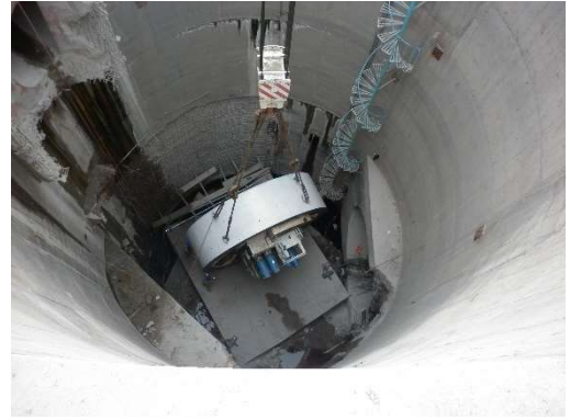
Figura III.126 Bajada del primer cuerpo de escudo [Cortesía Ing. Eduardo Zaragoza].
