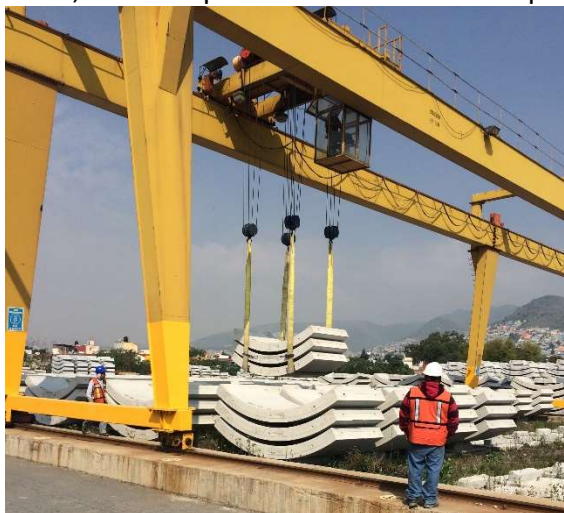
Figura III.121 Acopio definitivo de dovelas [Cortesía ICA].
