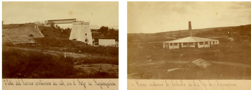
Figura 1.35. Horno Continuo de Cal y Horno de tabiques para el Túnel de Tequixquiac. Ref. [68] y Ref. [69].
