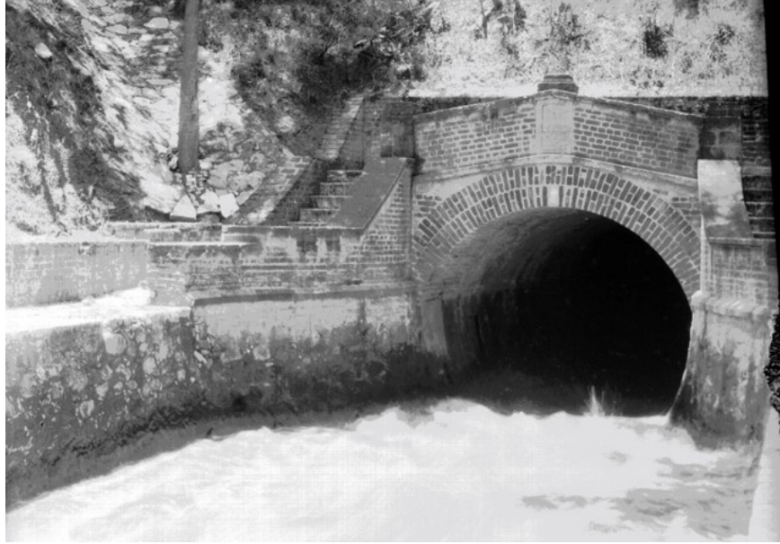
Figura 1.37. Fotografía Gran Canal del Desagüe y Túnel de Tequixquiac. Ref. [70].
