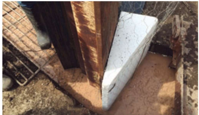
Figura III.43 Colocación de junta CWS [Cortesía Arq. Lizbeth Vázquez V.]
