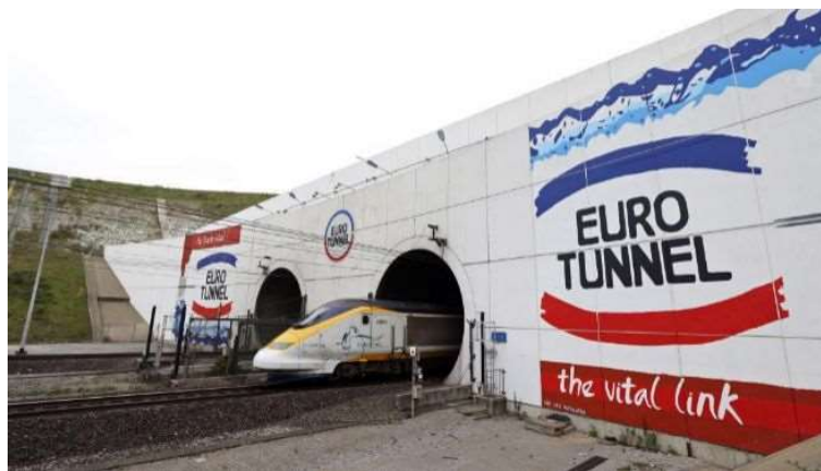
Figura 1.25. Fotografía del Túnel Canal de la mancha (Eurotunnel), Francia. Ref. [53].
