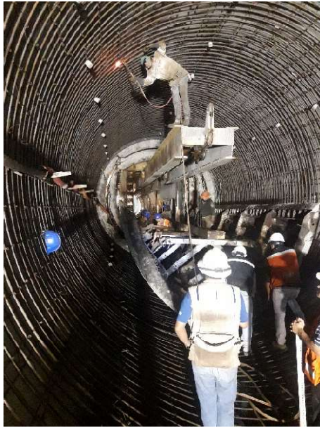
Figura III.153 Colocación de sección inferior de la cimbra telescópica [Propia].
