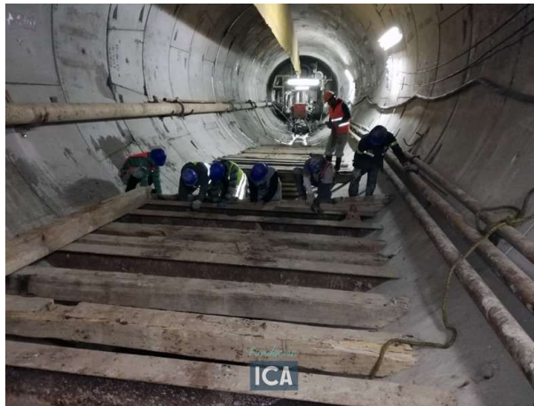
Figura III.143 Colocación de polines para instalación de cambio California, [cortesía ICA].
