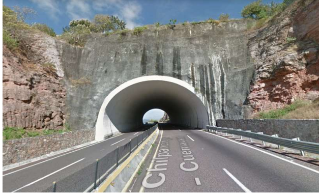
Figura 1.49. Túnel Los Querendes (Portal Sur), Guerrero, Estados Unidos Mexicanos. Ref. [83].
