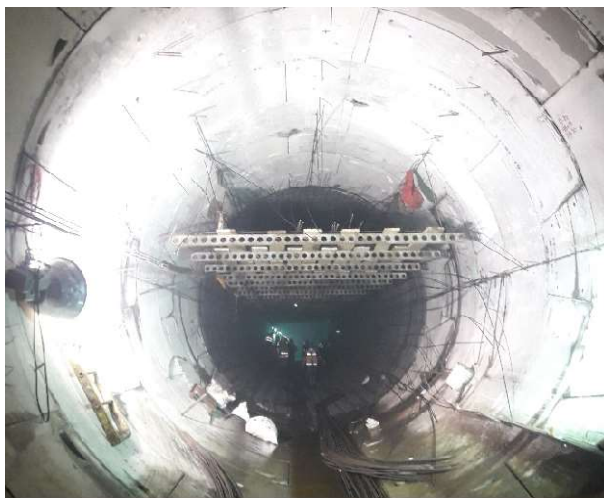
Figura III.146 Andamio colocado en túnel, [Propia].
