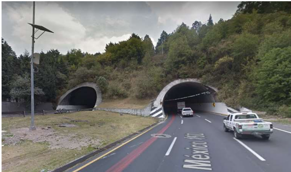
Figura 1.45. Túneles Acopilco (Portal Oriente), Edo. de México, Estados Unidos Mexicanos. Ref. [79].
