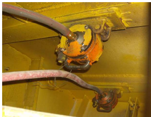
Figura III.108 Vibrador en molde [Cortesía Ing. Carlos J. Ilhuicatzí González].
