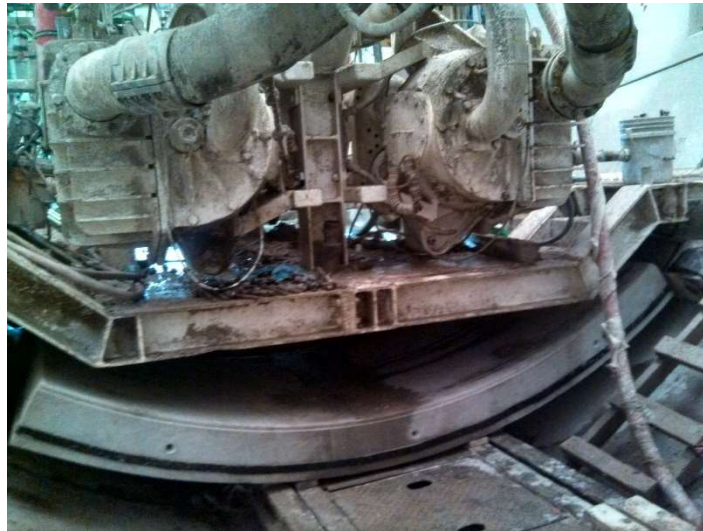
Figura 1.83. Cama o mesa de traslado dovelas. [Cortesía ICA, Ing. Eduardo Zaragoza]
