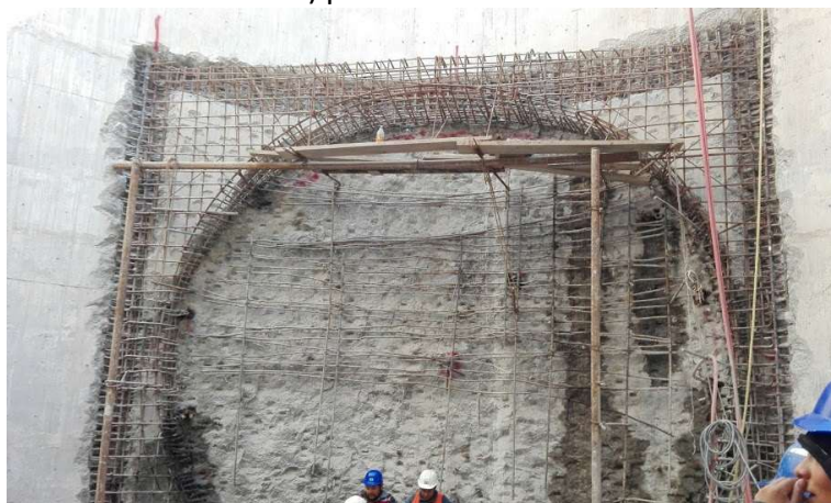
Figura III.80 Acero de refuerzo colocado para portal [Propia].
