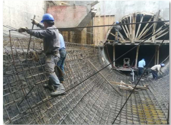
Figura III.88 Colocación de acero de refuerzo de media caña [Cortesía ICA].
