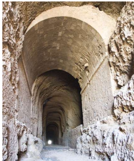
Figura 1.10. Túnel de Mina de Daroca (Zaragoza), España. Ref. [23].
