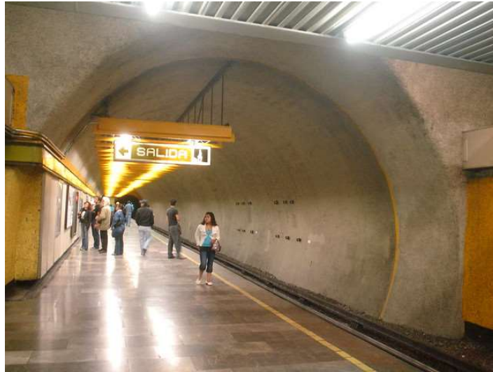
Figura 1.46. Túnel de la estación Miguel Ángel de Quevedo de la línea 3 del STCM. Ref. [80].
