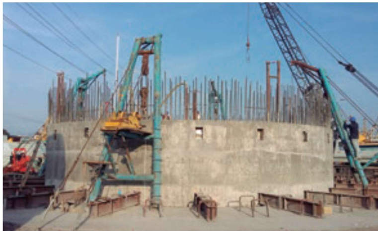
Figura III.29 Conclusión de primer ciclo de colado, [Cortesía Arq. Lizbeth Vázquez V.].
