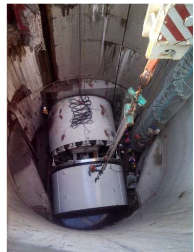
Figura III.130 Bajada del faldón del escudo [Cortesía Ing. Eduardo Zaragoza].
