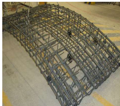
Figura III.102 Separadores en armado [Cortesía Ing. Carlos J. Ilhuicatzí González].
