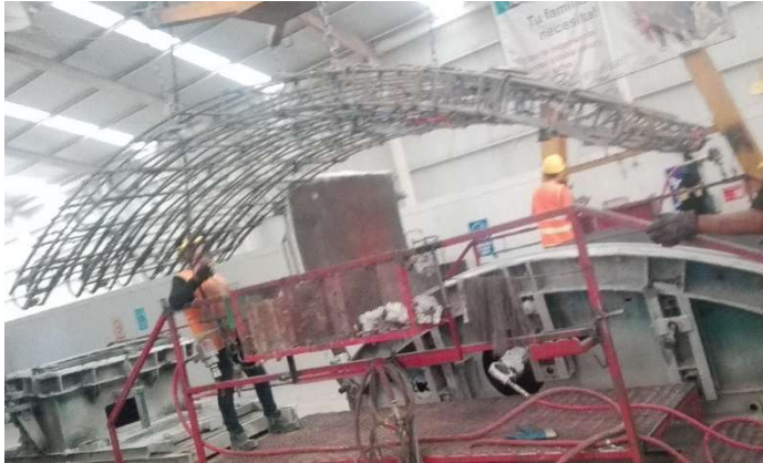
Figura III.103 Colocación de armado en molde [Propia].
