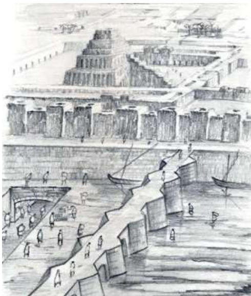
Figura 1.2. Construcción del túnel bajo el Éufrates en Babilonia. Ref. [6].
