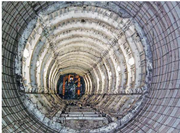
Figura 1.53. Túnel Interceptor Río de los remedios, Estado de México. [Cortesía: CONiISA].
