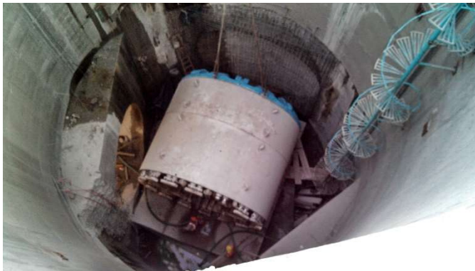
Figura III.129 Descenso y conexión de la cabeza de corte [Cortesía Ing. Eduardo Zaragoza].
