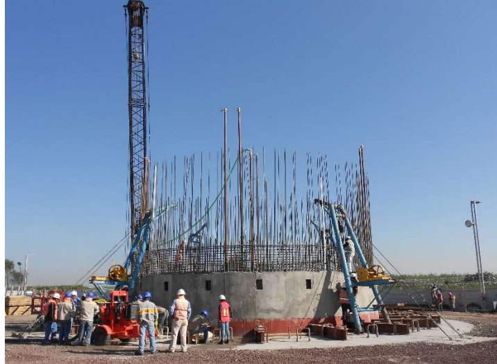
Figura III.28 Conclusión de primer ciclo de avance, [Cortesía Arq. Lizbeth Vázquez V.].
