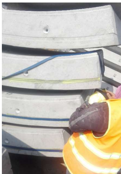
Figura III.122 Colocación de sello perimetral hydrotite en dovela. [Propia]
