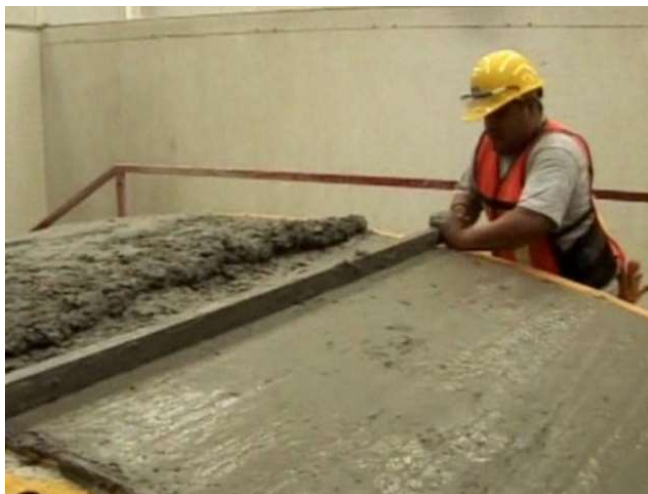
Figura III.109 Enrasado de concreto de dovela [Propia].
