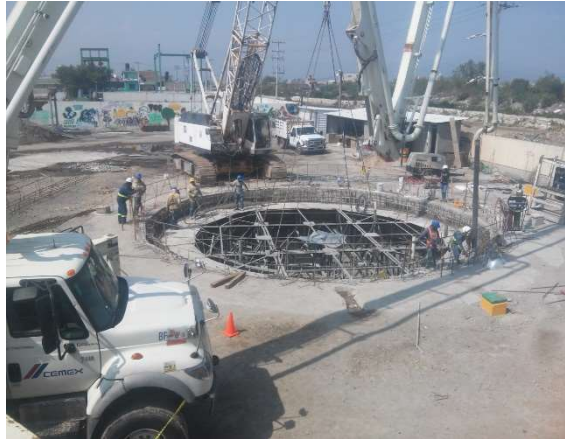
Figura III.72 Construcción de trabe de coronamiento [Cortesía ICA]
