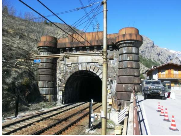
Figura 1.18. Túnel Fréjus (Modane), Francia. Ref. [36].
