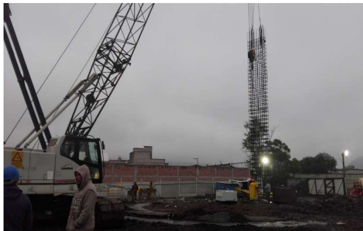
Figura III.47 Colocación de acero de refuerzo en panel de lumbrera con muro Milán [Cortesía ICA].
