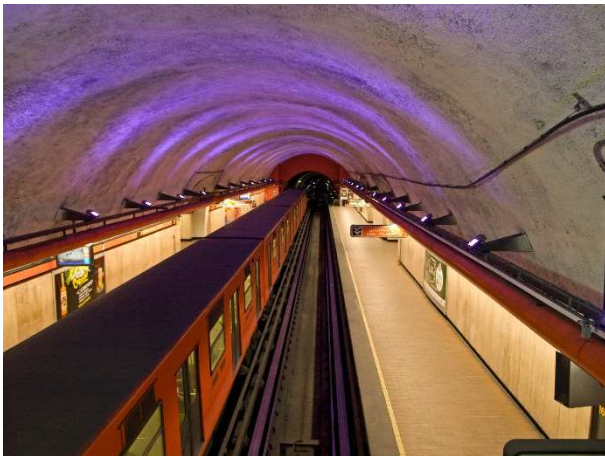
Figura 1.47. Túnel de la estación Barranca del Muerto de la línea 7 del STCM. Ref. [81].
