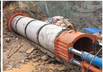
Figura 1.71. Equipos de excavación mecanizada a sección completa (Topo, escudo y empuje de tubos).
