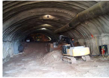
Figura 1.70. Ejemplo de excavación, media sección superior en una fase y banco en fases. Ref. [99].
