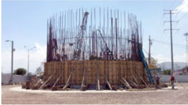
Figura III.27 Cimbrado de una lumbrera flotada, [Cortesía Arq. Lizbeth Vázquez V.].
