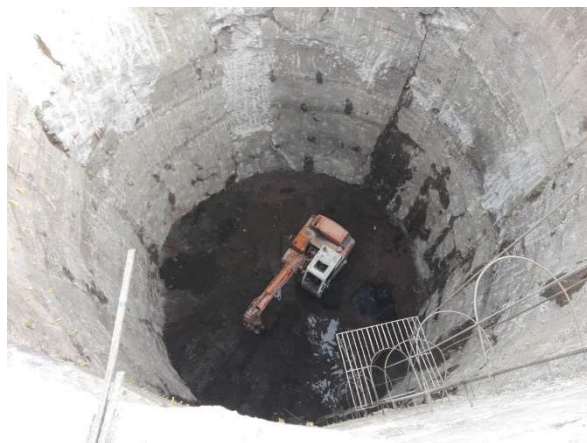
Figura III.58 Excavación de lumbrera 7 a cielo abierto. [Cortesía Ing. Rosalba Trujillo Pech]
