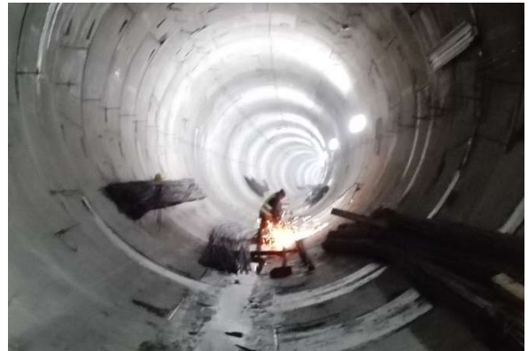
Figura III.145 Habilitado y corte del acero de refuerzo, [Propia].
