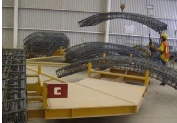
Figura III.100 Colocación de armado carrusel [Cortesía Ing. Carlos J. Ilhuicatzí González].
