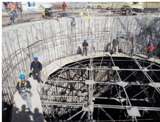
Figura III.68 Colocación de acero de refuerzo con cimbra colgante [Cortesía ICA]
