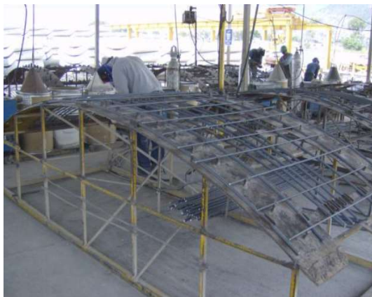
Figura III.98 Habilitado de acero para parrilla [Cortesía Ing. Carlos J. Ilhuicatzí González].
