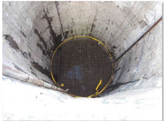
Figura III.63 Acero de refuerzo de losa de fondo colocado [Cortesía ICA]
