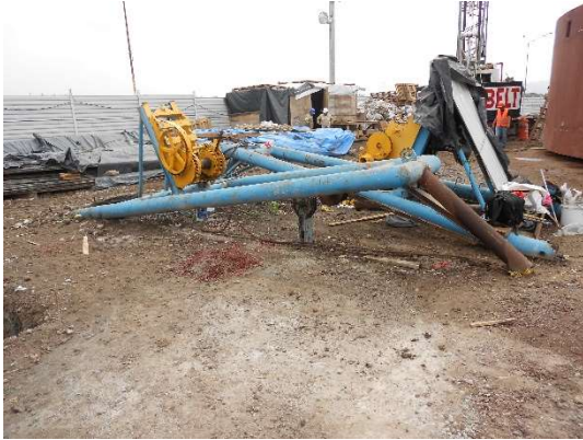
Figura II.81. Plumas de izaje y control, [Cortesía ICA, Arq. Lizbeth Vazquez V.]
