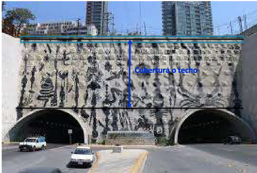
Figura 1.65. Cobertura o techo de Túnel San Pedro-Loma larga. Ref. [96].
