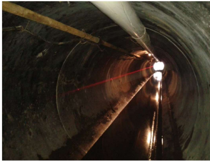
Figura 1.80. Láser de sistema de guiado en túnel. [Cortesía: Ing. Isaías Hernández Soto].
