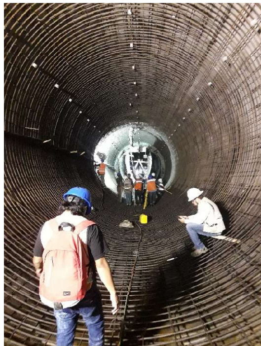
Figura III.150 Acero de refuerzo de revestimiento definitivo colocado, [Propia].
