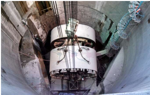
Figura III.127 Descenso del segundo cuerpo del escudo [Cortesía Ing. Eduardo Zaragoza].
