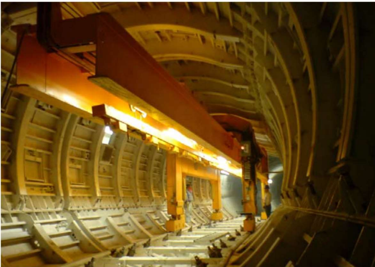
Figura II.79. Grúa pórtico y trabe carril, [Cortesía ICA]
