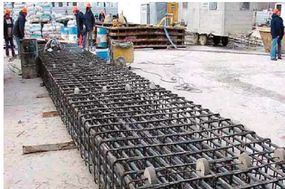
Figura III.46 Separadores circulares para armado de muro Milán [Cortesía Ing. Jaime Castañeda Martínez]
