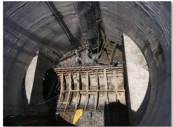
Figura III.90 Colado de pendiente de media caña [Cortesía ICA].
