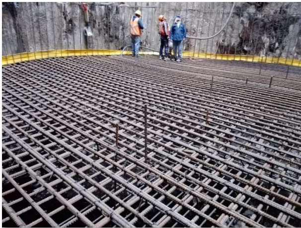
Figura III.62 Acero de refuerzo de losa de fondo colocado [Cortesía ICA]
