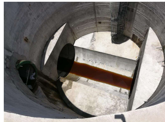
Figura III.92 Colado de pendientes de media caña [Cortesía ICA].
