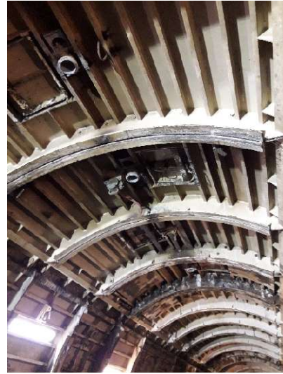
Figura III.157 Ventanas de clave de cimbra telescópica [Propia].
