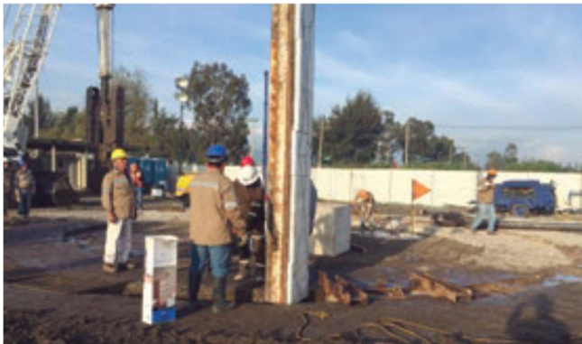
Figura III.42 Colocación de juntas CWS [Cortesía Arq. Lizbeth Vázquez V.]
