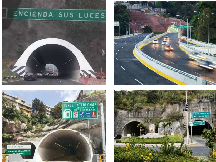
Figura 1.57. Túneles de Supervía Poniente, CDMX, Estados Unidos Mexicanos. Ref. [90].
