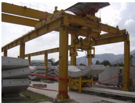
Figura III.119 Grúa para acopio de dovelas [Cortesía ICA].
