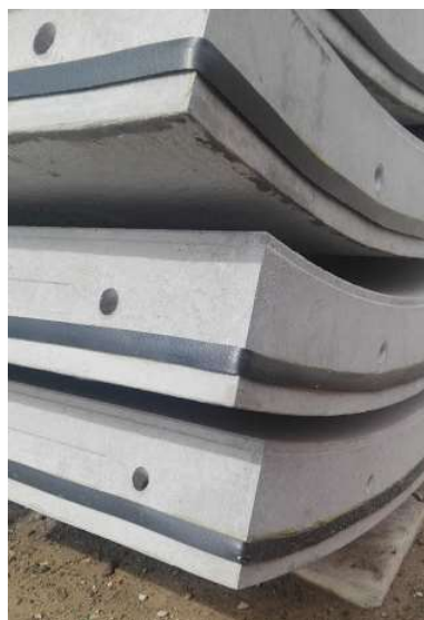
Figura III.123 Colocación de sello perimetral de neopreno en dovela. [Propia]
