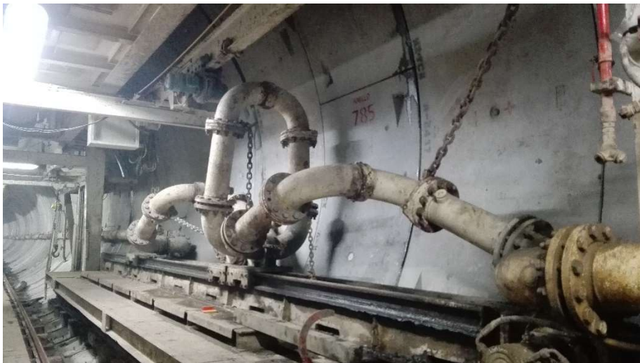
Figura II.20. Sistema de extensión de tubería de rezaga del escudo EPB (HK-S364), también llamada “Snorkels” [Propia]
