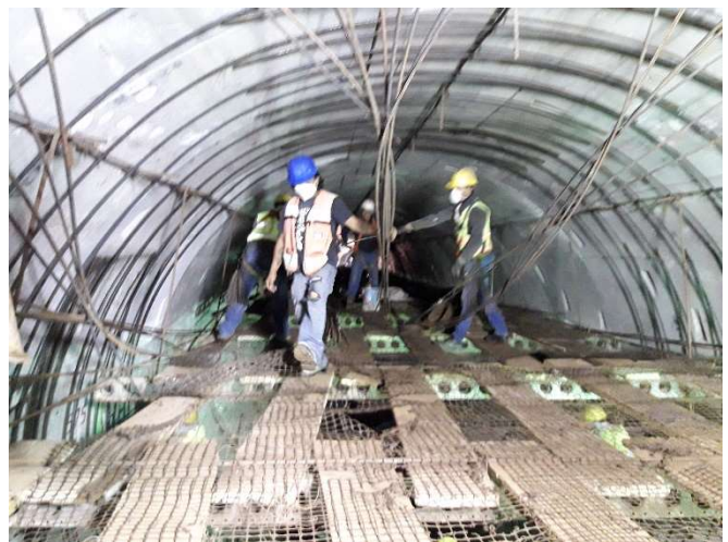
Figura III.147 Andamio colocado en túnel, [Propia].
