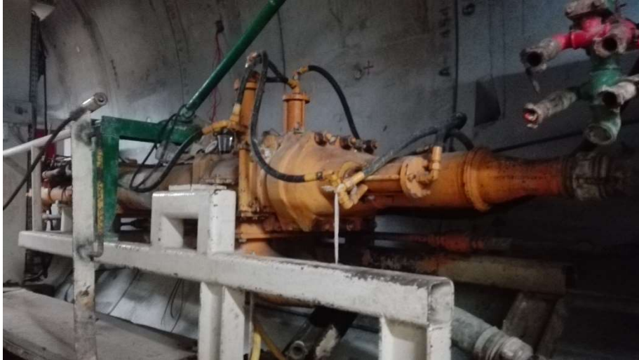
Figura II.19. Bomba de extracción de rezaga del escudo EPB (HK-S364), [Propia]
