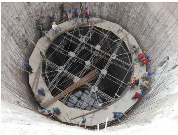
Figura III.67 Colocación de acero de refuerzo con cimbra colgante [Cortesía ICA]
