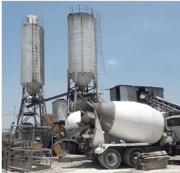
Figura II.59. Planta de concreto, [Propia]
