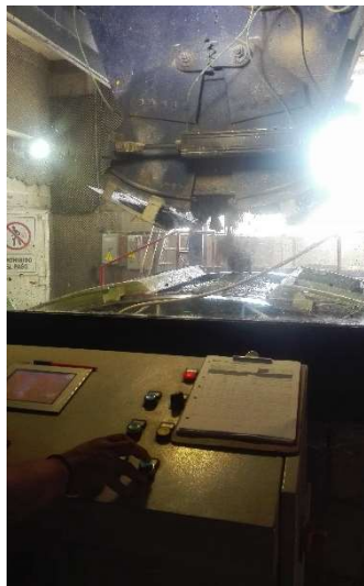
Figura III.107 Colocación y vibrado de concreto [Propia].
