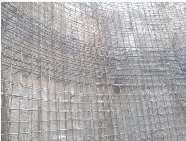
Figura III.70 Acero de refuerzo de anillo de rigidez [Cortesía ICA]
