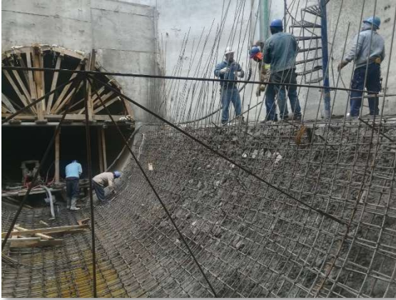
Figura III.87 Colocación de acero de refuerzo de media caña [Cortesía ICA].
