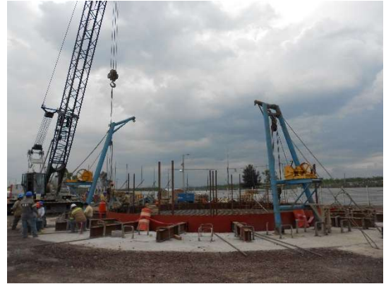
Figura II.82. Plumas de izaje y control, [Cortesía ICA, Arq. Lizbeth Vazquez V.]
