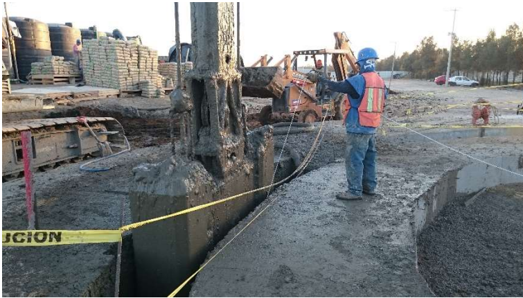
Figura III.39 Excavación de paneles de pantalla perimetral. [Cortesía Ing. Daniel Falcao].
