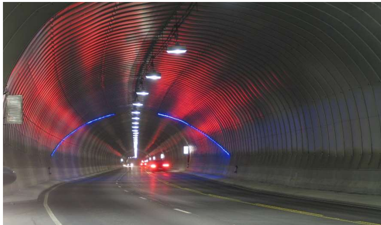
Figura 1.27. Fotografía del túnel Eiksund, Noruega. Ref. [57].
