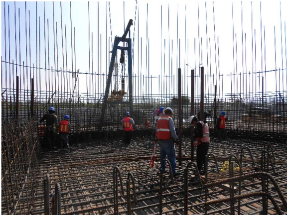
Figura III.25 Habilitado y colocación del acero de refuerzo de losa de fondo de lumbra, [Cortesía Arq. Lizbeth Vázquez V.].
