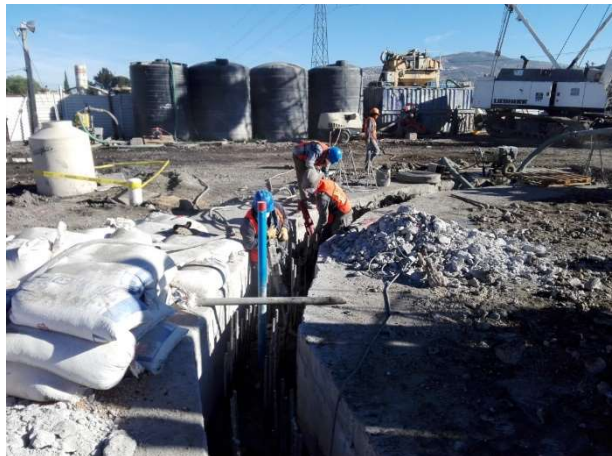
Figura III.54 Limpieza de material producto del descabece [Cortesía Ing. Rosalba Trujillo Pech]
