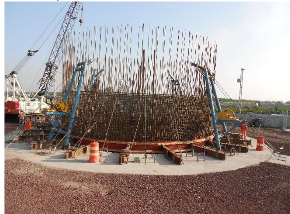
Figura III.26 Habilitado y colocación del acero de refuerzo de muro de lumbra flotada, [Cortesía Arq. Lizbeth Vázquez V.].
