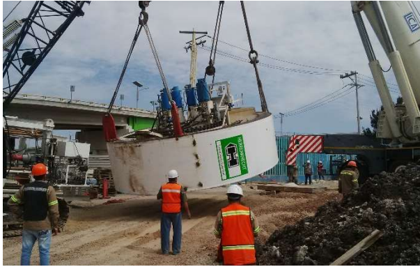
Figura III.125 Maniobras de izaje del primer cuerpo del escudo [Cortesía Ing. Eduardo Zaragoza].
