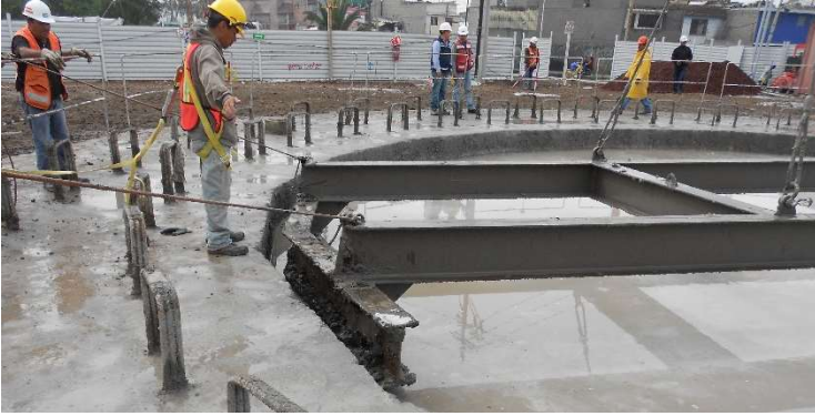
Figura III.15 Verificación de profundidad y verticalidad con escantillón. [Cortesía M.I Mario Aguilar].
