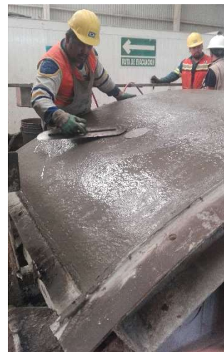
Figura III.110 Pulido de concreto de dovela [Propia].
