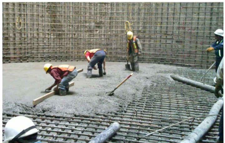
Figura III.65 Colado de Losa de fondo de Lumbrera 7.
