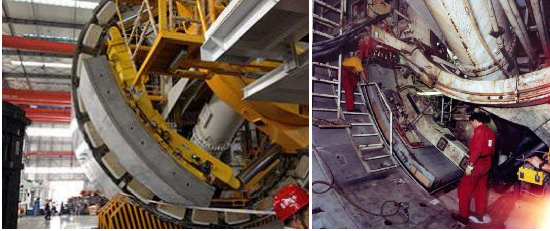
Figura 1.84. Erector de tuneladora colocando una dovela. Ref. [110], y Ref. [111]
