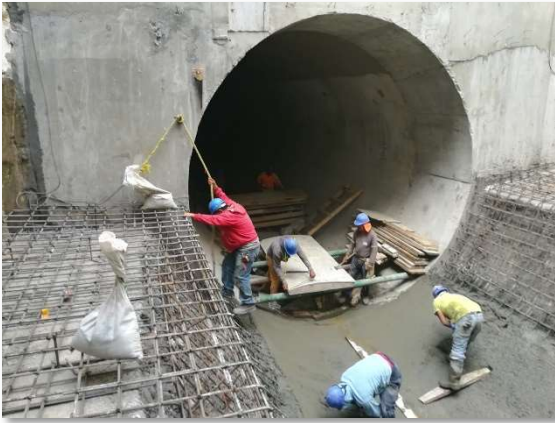
Figura III.89 Colado de cubeta de media caña [Cortesía ICA].
