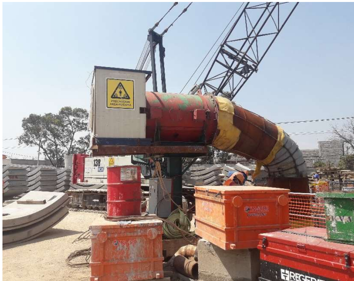
Figura II.14. Sistema de ventilador "Korfmann" del escudo EPB (HK-S364), [Propia]
