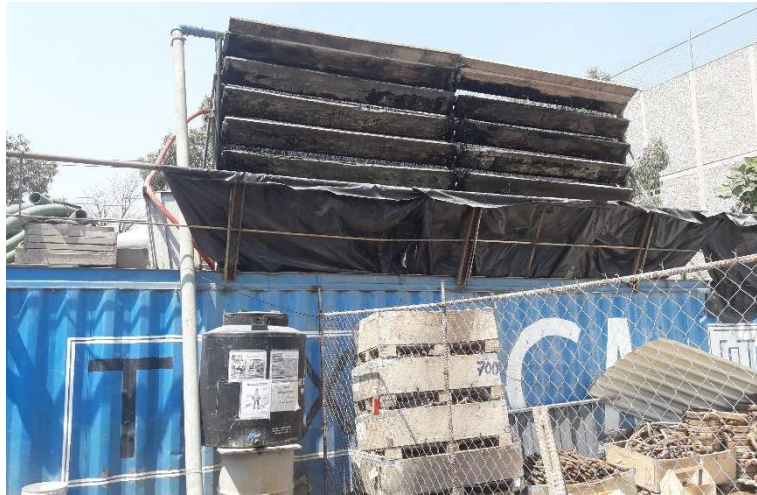
Figura II.12. Sistema de agua del escudo EPB (HK-S364), ubicado en patio de Lumbrera 2, [Propia]
