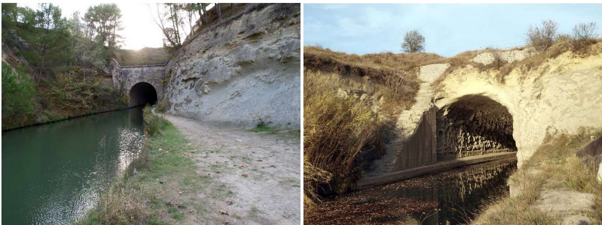
Figura 1.11. Túnel de Malpas (Béziers), Francia. Ref. [25].
