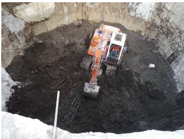
Figura III.57 Excavación de lumbrera 7 a cielo abierto. [Cortesía Ing. Rosalba Trujillo Pech]
