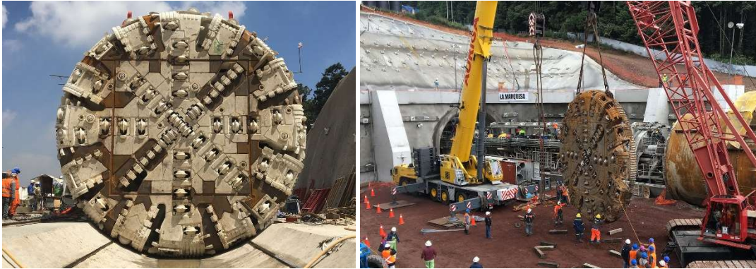
Figura 1.72. Rueda de corte y desmontaje de la rueda de corte de la TBM S-948(TIMT) Ref. [103].
