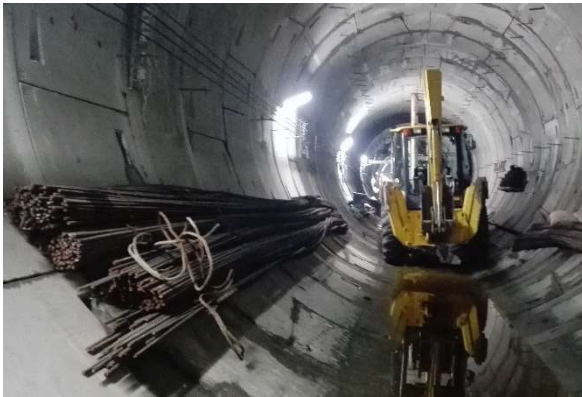
Figura III.144 Acarreo del acero de refuerzo con retroexcavadora, [Propia].
