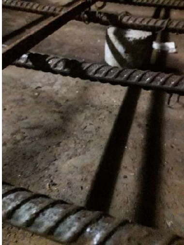
Figura III.148 Separador de concreto en lecho inferior, [Propia].
