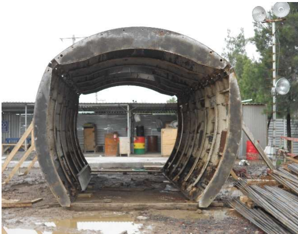
Figura III.151 Ensamble de clave y hastiales de cimbra telescópica en superficie [Cortesía M.I Mario A. Aguilar Téllez].
