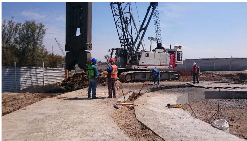
Figura III.38 Relleno de espacio entre brocales con tepetate. [Cortesía ICA].
