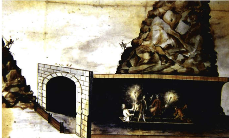
Figura 1.33. Túnel de Huehuetoca visitado por el superintendente Real del Desagüe, Domingo de Trespacios y Escandón, hacia 1760. Ref. [67]
