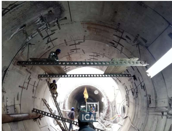
Figura III.142 Troquelado de anillos de atraque, [cortesía ICA].
