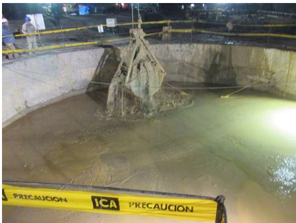
Figura III.59 Excavación con almeja loca [Cortesía Ing. Daniel Falcao].
