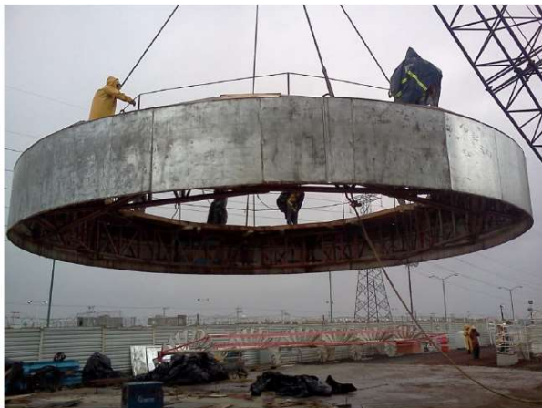
Figura III.66 Izaje de cimbra colgante con grúa [Cortesía ICA]
