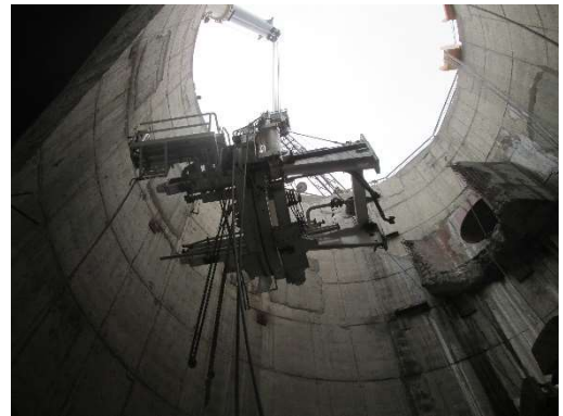
Figura III.128 Bajada del erector del escudo [Cortesía Ing. Eduardo Zaragoza].
