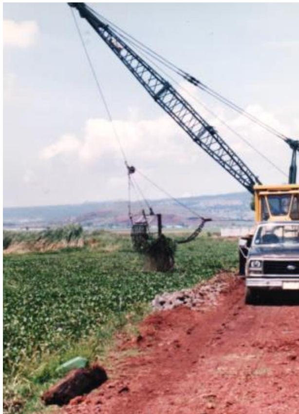
Figura 24. Control de maleza con método mecánico-manual (Fuente Elaboración propia)
