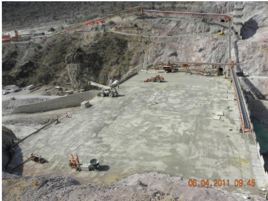
FIG.5.48 AVANCE FISICO DE COLOCACION, ABRIL DEL 2011
