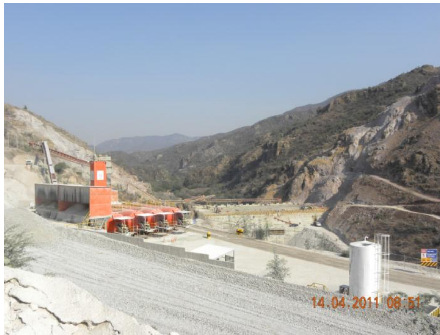
FIG. 5.38 PLANTA DE CONCRETO DE CCR
