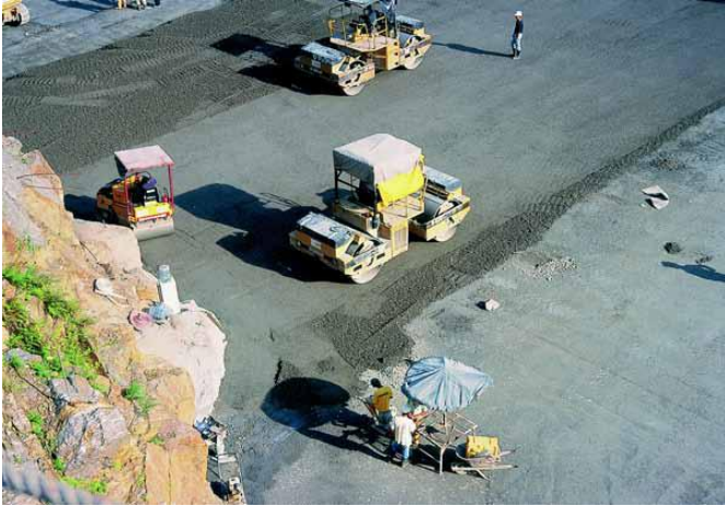
FIG. 4.42 EL VIBRO-COMPACTADOR HACE SEIS PASADAS, LUEGO DE LO CUAL SE VERIFICA LA DENSIDAD LOGRADA DEL CCR POR MEDIO DE DENSÍMETROS NUCLEARES Y EN ZONAS DE DIFÍCIL ACCESO SE UTILIZAN CARGADORES Y COMPACTADORES LIVIANOS. EL TIEMPO MÁXIMO ENTRE MEZCLADO Y COMPACTACIÓN ES DE 40 MINUTOS Y SE DA UNA PENDIENTE A LAS CAPAS DE CCR DEL 1% HACIA AGUAS ABAJO PARA DRENAJE. PRESA MIEL 1.COLOMBIA.
