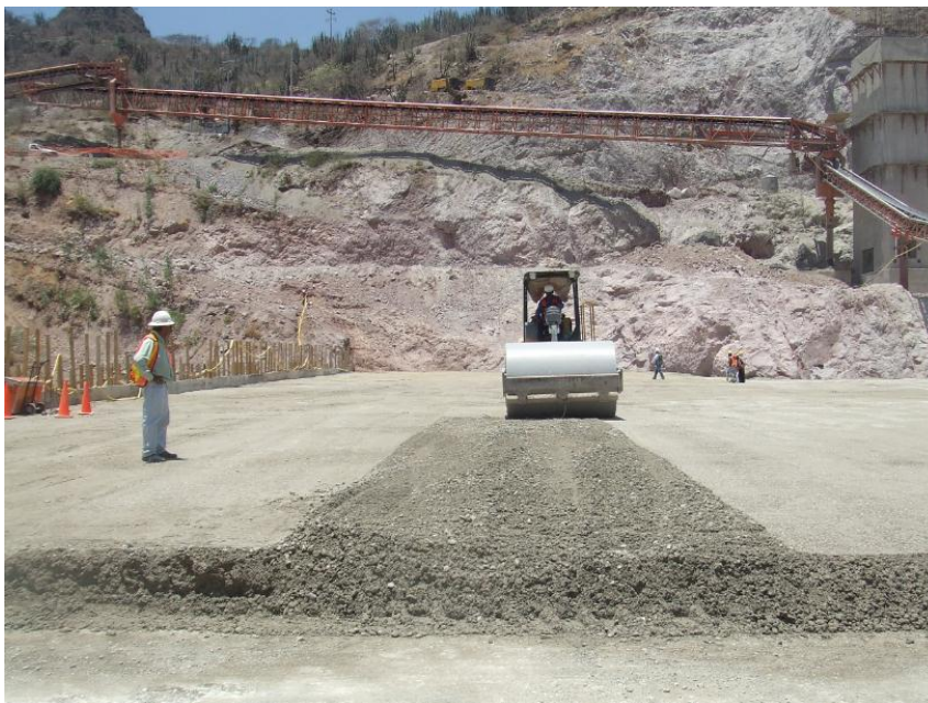
FIG. 5.54 COMPACTACION DE CAPAS
