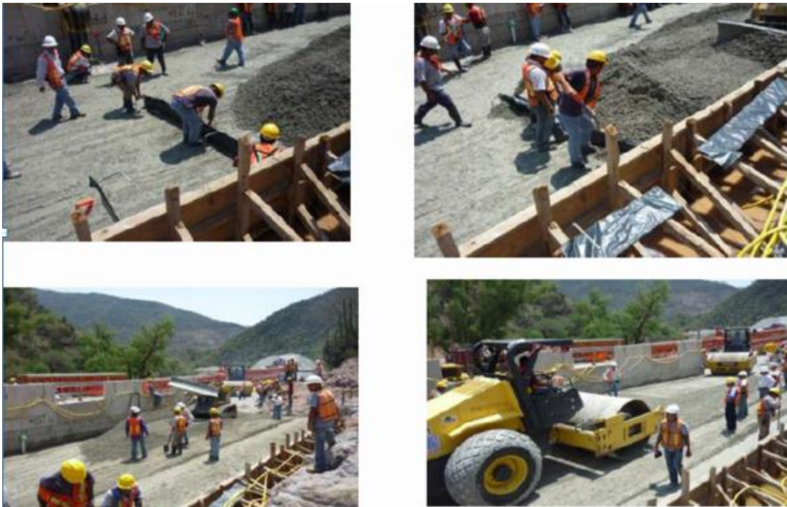
FIG. 5.14 COLOCACION DE JUNTAS DE CONSTRUCCION
