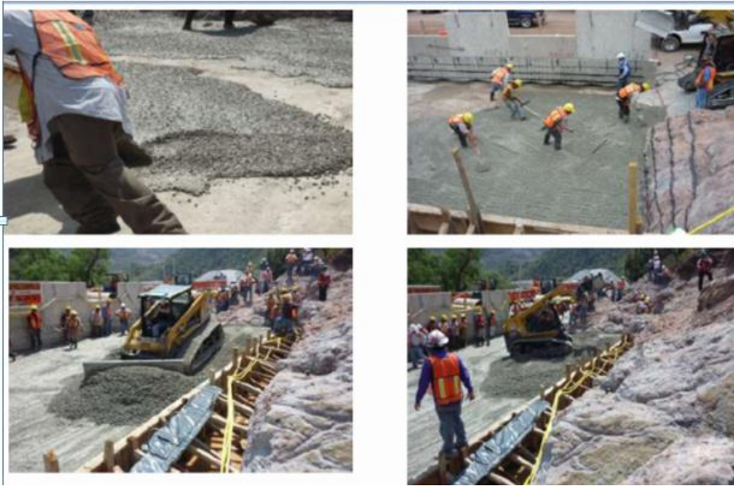
FIG.5.12 COLOCACION DE CONCRETO DE LIGA Y EXTENDIDO DE CCR
