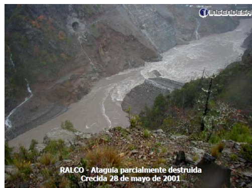
FIG. 2.85 ATAGUIA PARCIALMENTE DESTRUIDA
