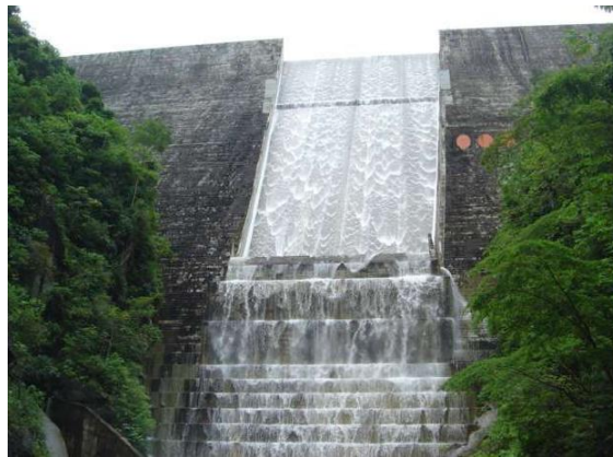
FIG. 2.90 VERTERDOR INCORPORADO EN CORTINA DE CCR
