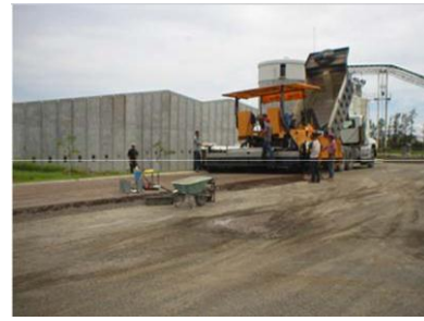
FIG. 4.7 MOVIMIENTO EN CONJUNTO DE LA MAQUINARIA PARA LA COLOCACION DE LA MEZCLA DE CCR
