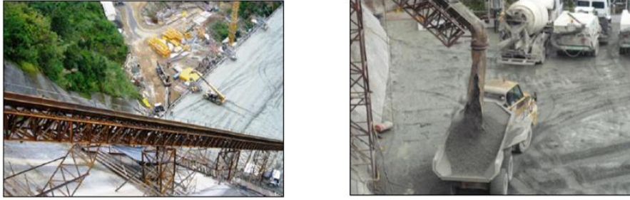
FIG. 4.24 TRANSPORTE CON VAGONETA Y COLOCACIÓN CON CANOA EN EL PROYECTO PIRRI EN COSTA RICA. LA DESCARGA DEL CCR A LA PRESA FUE POR MEDIO DE UNA CANOA METÁLICA COMO ALTERNATIVA A LA BANDA, ESTA ES UNA MODALIDAD CON MENOR RENDIMIENTO Y QUE EXIGE CIERTA GEOMETRÍA, CONFIGURACIÓN Y PENDIENTE DE LA CANOA PARA MANTENER LA CALIDAD DE LA MEZCLA, SOBRETODO EVITAR LA SEGREGACIÓN DEL AGREGADO GRUESO.
