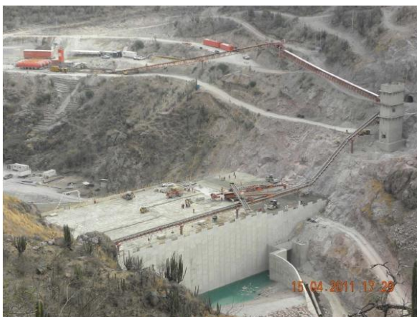
PANORAMICA DE COLOCACION DE CCR EN CORTINA
