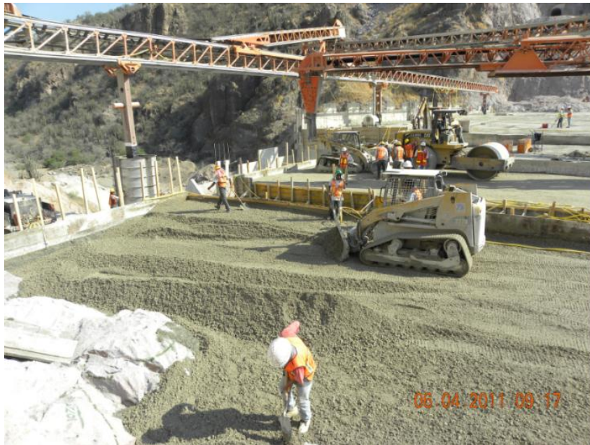
FIG. 5.53 EXTENDIDO DE CONCRETO CCR
