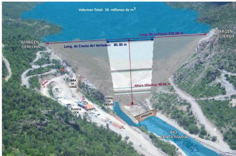
FIG.5.5. DIFERENTES OBRAS QUE INTEGRAN EL PROYECTO
