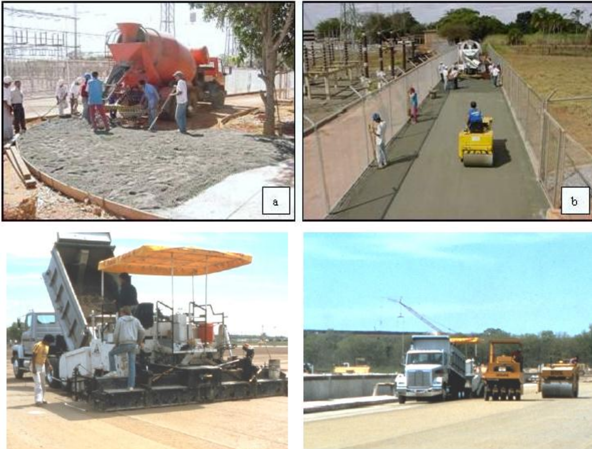
FIG. 4.62 ETAPAS DE CONSTRUCCION DE PAVIMENTOS
