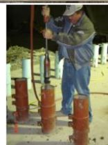
FIG. 3.29 SUPERVISION Y CONTROL DE CALIDAD
