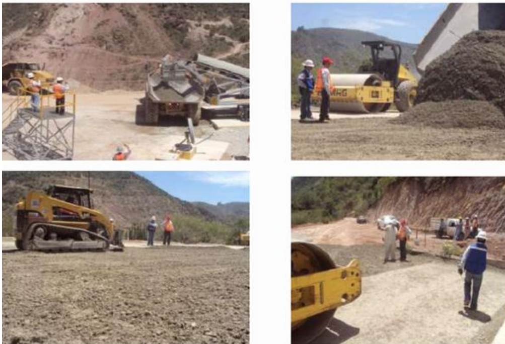
FIG.5.11 CALIBRACION DE PLANTA DE CONCRETO Y PRODUCCION DE CCR.
