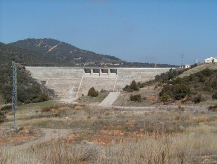
FIG. 4.14 PARA DAR CONTINUIDAD A LAS OBRAS SE TRABAJÓ EN TURNOS DE DÍA Y NOCHE, SIN PARADAS DURANTE LOS FINES DE SEMANA, REDUCIENDO AL MÍNIMO IMPRESCINDIBLE EL NÚMERO DE JUNTAS FRÍAS. PRESA EL ATANCE .ESPAÑA
