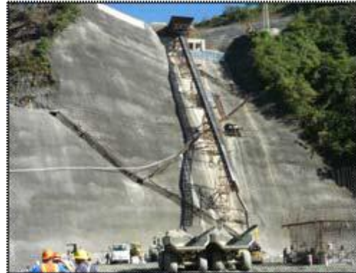
FIG. 2.77 TRANSPORTE Y DESCARGA DEL RCC CON BANDA Y CON CANOA/VAGONETA
