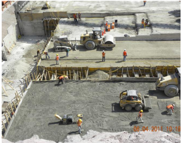
FIG. 5.59 CONSTRUCCION DE LA GALERIA CON FORMAS METALICAS Y RELLENO DE ESPACIOS CON GRAVA O ARENA
