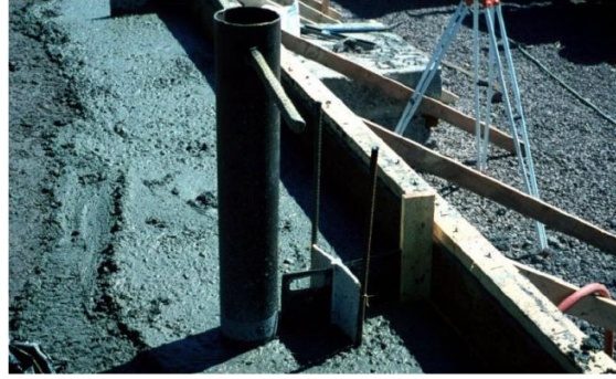
FIG. 4.38 INSTALACION DE BANDA OJILLADA WATERSTOP
