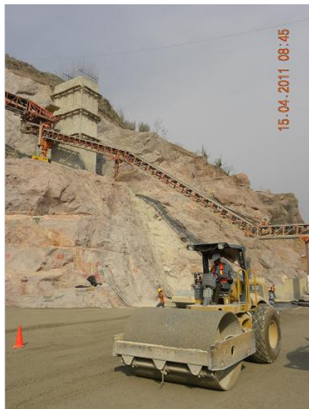
FIG. 5.51 b LA COLOCACION DE CCR ES DURANTE LA MAÑANA Y LA TARDE
