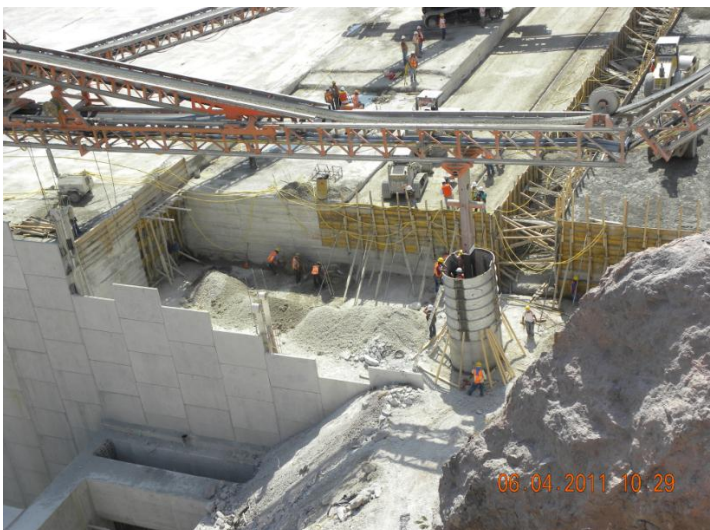
FIG. 5.58 CIMBRA EN GALERIA DE INSPECCION
