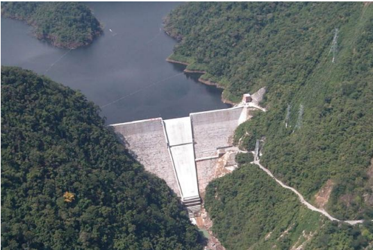
FIG. 2.92 COLOCACIÓN DEL REBOSADERO SOBRE EL CUERPO MISMO DE LA PRESA
