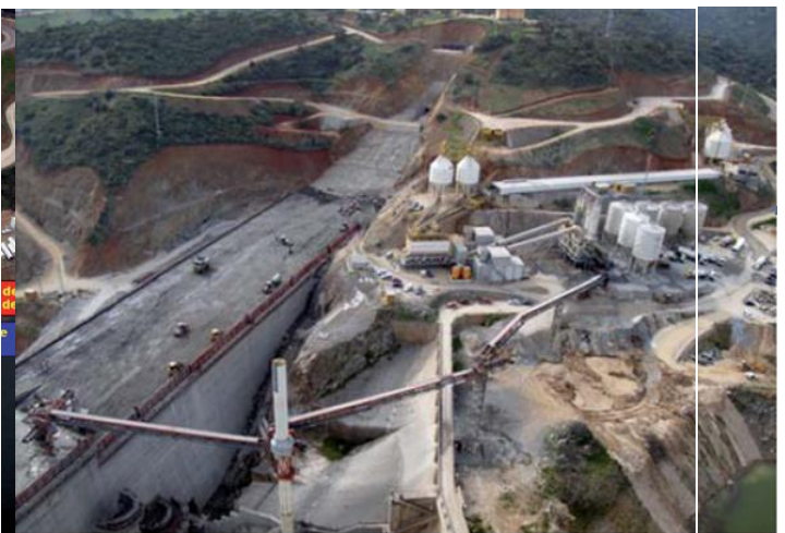
FIG. 2.56 VISTA GENERAL DE EQUIPO AUTOTREPANTE DE BANDAS TRANSPORTADORAS DE CCR
