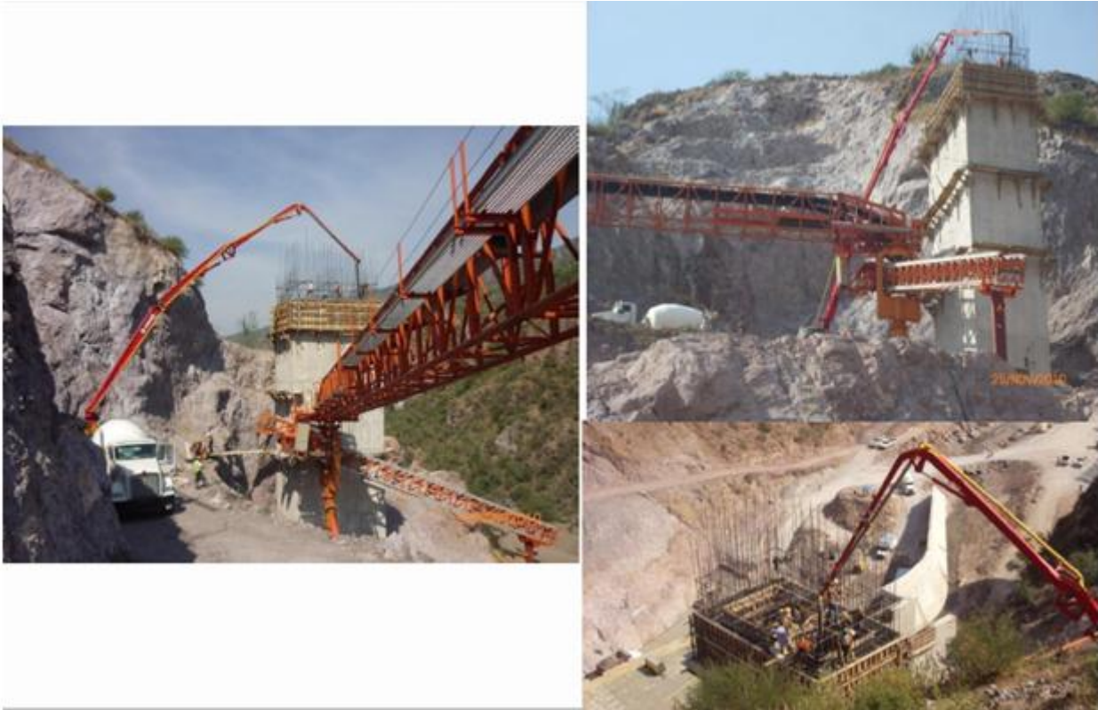
FIG.5.35 COLOCACION DE CONCRETO CONVENCIONAL EN LA OBRA DE TOMA
