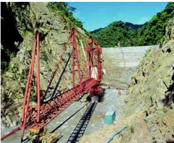
FIG. 2.91 EL SITIO DE PRESA SE CARACTERIZA POR SER UN CAÑÓN PROFUNDO Y ESTRECHO CON PENDIENTE PRONUNCIADA, SUPERIOR A 45°. LAS ROCAS DEL SITIO DEL PROYECTO ESTÁN CONSTITUIDAS ESENCIALMENTE POR GNEIS MICÁCEO DURO Y FRESCO, QUE PRESENTA INTERCALACIONES DE CUARCITA.
