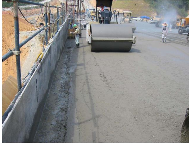
FIG. 4.40 COMPACTACION DE CCR CON EQUIPO VIBROCOMPACTADOR
