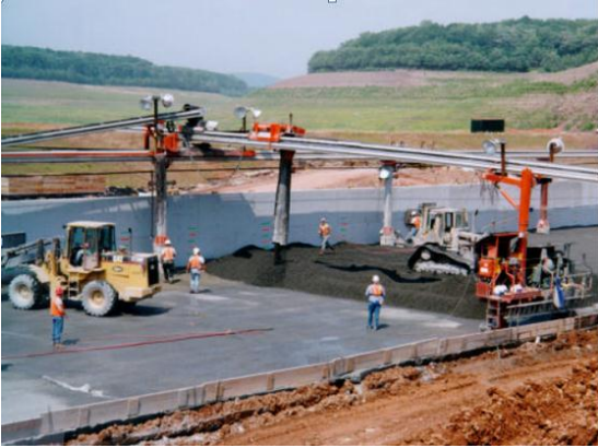
FIG. 4.25 DEBIDO A LOS REQUERIMIENTOS DEL DISEÑO TÉRMICO DE LAS PRESAS, LA TEMPERATURA DEL CONCRETO DURANTE SU COLOCACIÓN DEBE SER INFERIOR A 23°C, PARA LO CUAL EN EL PROCESO DE MEZCLADO EL AGUA SE ENFRÍA A 5°C Y LOS AGREGADOS DE 5CM Y 2,5CM A 9°C.
