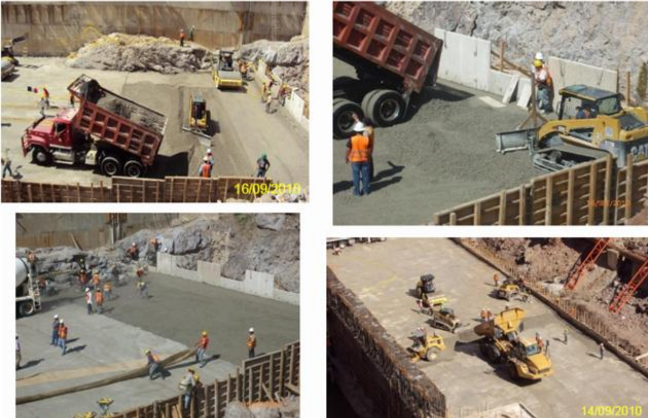
FIG. 5.45 COLOCACION DE CCR EN BLOQUE 5
