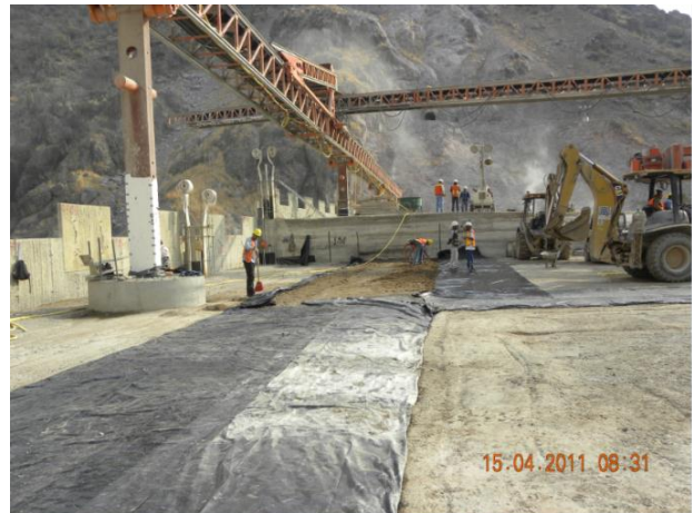
FIG. 5.60 CONSTRUCCION DE GALERIA, COLOCACION DE PLASTICO PARA NO CONTAMINAR EL CCR CON LA ARENA DE RRELLENO DE LA GALERIA
