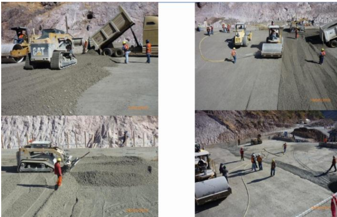
FIG. 5.15 PROCESO DE COLOCACION Y COMPACTADO
