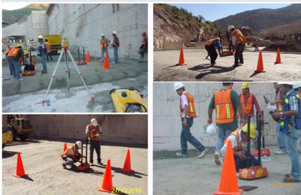
FIG. 5.41 LECTURAS CON EL DENSIMETRO NUCLEAR EN EL CONCRETO COMPACTADO CON RODILLO EN EL BLOQUE No.5 DEL CUERPO DE LA CORTINA
