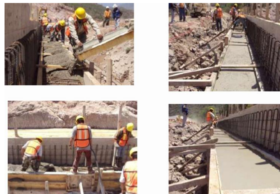
FIG. 5.10 COLADO DE MURO DE CONCRETO
