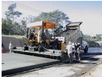
FIG. 4.6 PROYECTO: PAQUETE II, COLOCACION Y COMPACTACION INICIAL DE LA MEZCLA CCR, UTILIZANDO MAQUINA PAVIMENTADORA
