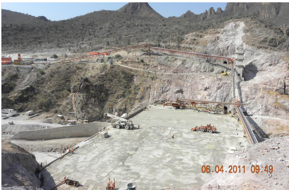
FIG. 5.62 SISTEMA DE TRANSPORTE POR BANDA
