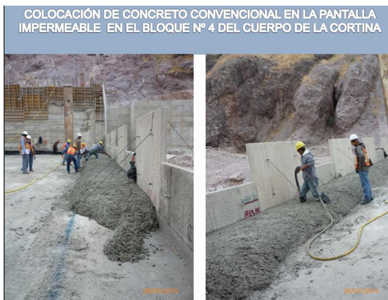
FIG. 5.28 COLOCACION DE CONCRETO CONVENCIONAL EN LA PANTALLA IMPERMEABLE
