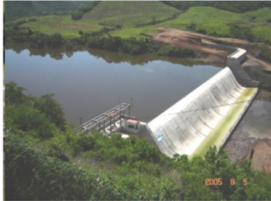
Fig.2.24 PRESA AMATA SINALOA, MEXICO.
