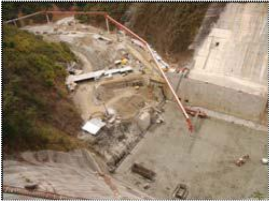
FIG. 2.77 TRANSPORTE Y DESCARGA DEL RCC CON BANDA Y CON CANOA/VAGONETA
