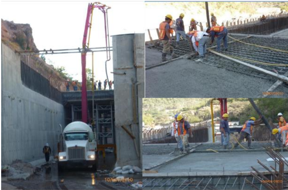
FIG.5.29 COLADO DE CONCRETO CONVENCIONAL EN LOSA DEL CONDUCTO DE DESVIO
