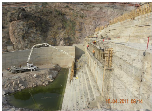
FIG. 5.37 COLADO DE CONCRETO CONVENCIONAL
