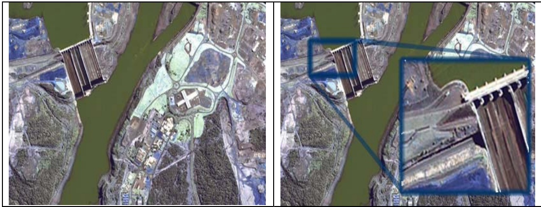
Figura 3.12.- Imagen IKONOS 1m de un sector de la hidroeléctrica Itaipú Binacional [22 p.e].
