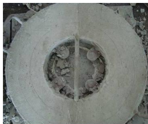
a. Esquema del desarrollo de grietas b. Anillo de la mezcla M1
