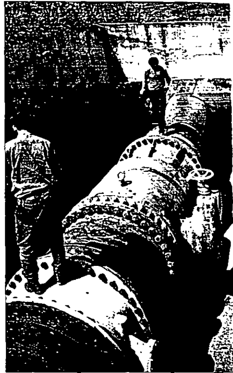
Muchas veces los materiales escogidos para la construcción no son los adecuados para soportar esfuerzos sísmicos.
