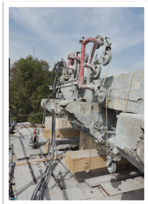
Figuras 56 y 57. Maquinaria con la que se realiza el corte con hilo. (Fotografías tomadas por la empresa Sackbé)
