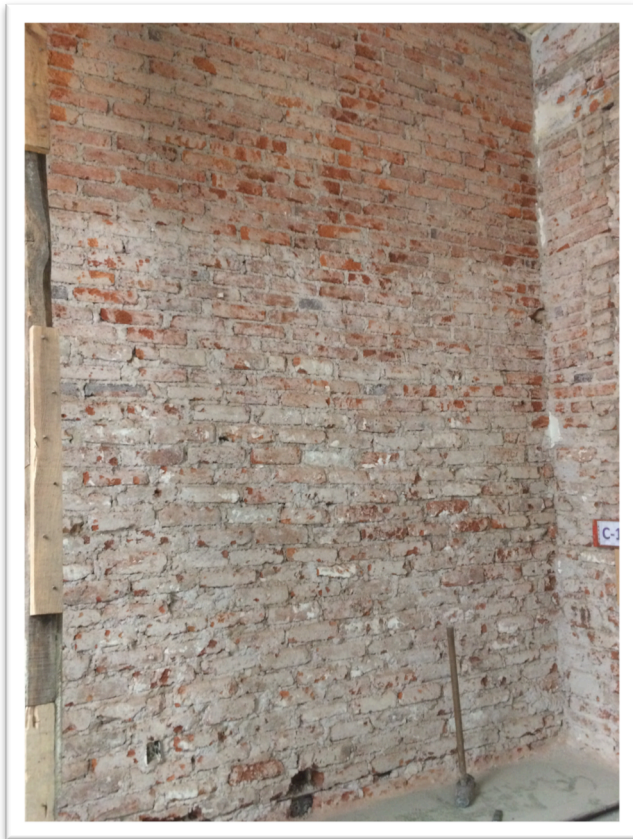
Fig. 9 Muro posterior de tabique rojo, en la Antigua Academia de San Carlos.
