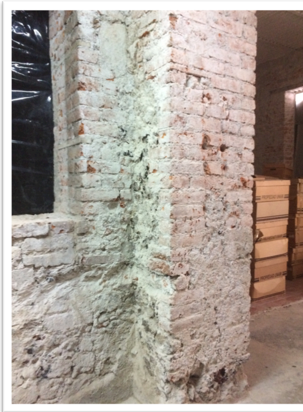
Fig. 8 Columnas y Jambas de tabique rojo en muros de la Antigua Academia de San Carlos.
