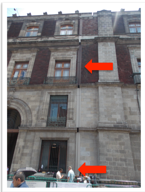
Figuras 32 y 33. Juntas constructivas en la fachada de calle Moneda.
