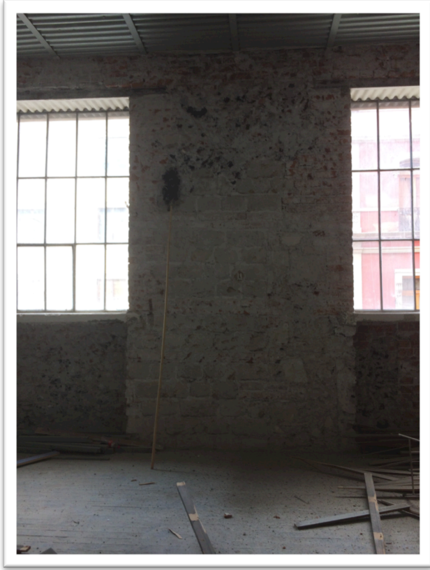
Fig. 7 Fábricas (Sillares de tepetate y tabique rojo) de la Antigua Academia de San Carlos.
