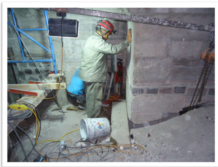
Fig. 36 Trabajos en antiguo templo de San Agustín
