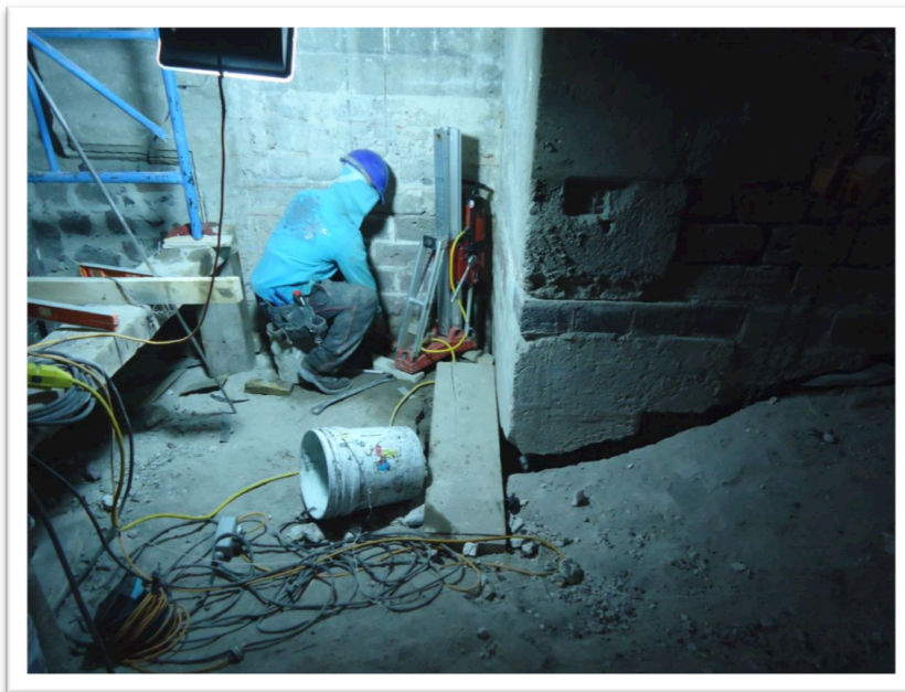
Imagen 39. Trabajos en San Agustín.
