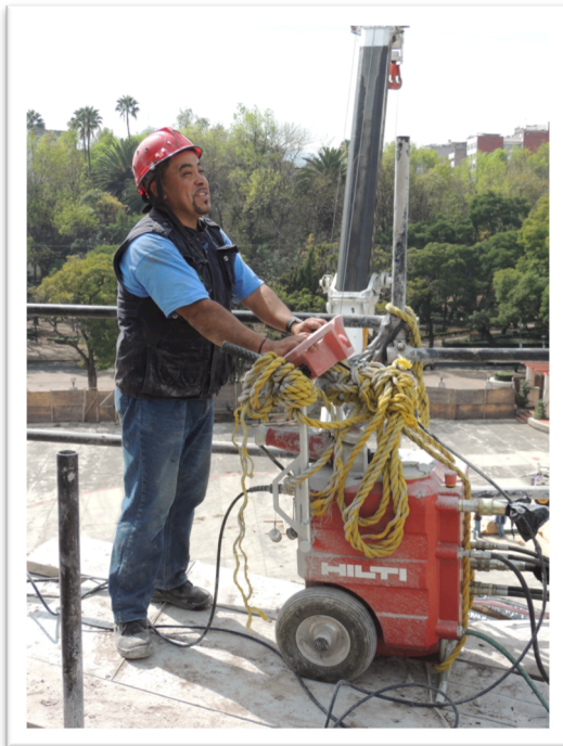
Figuras 56 y 57. Maquinaria con la que se realiza el corte con hilo. (Fotografías tomadas por la empresa Sackbé)
