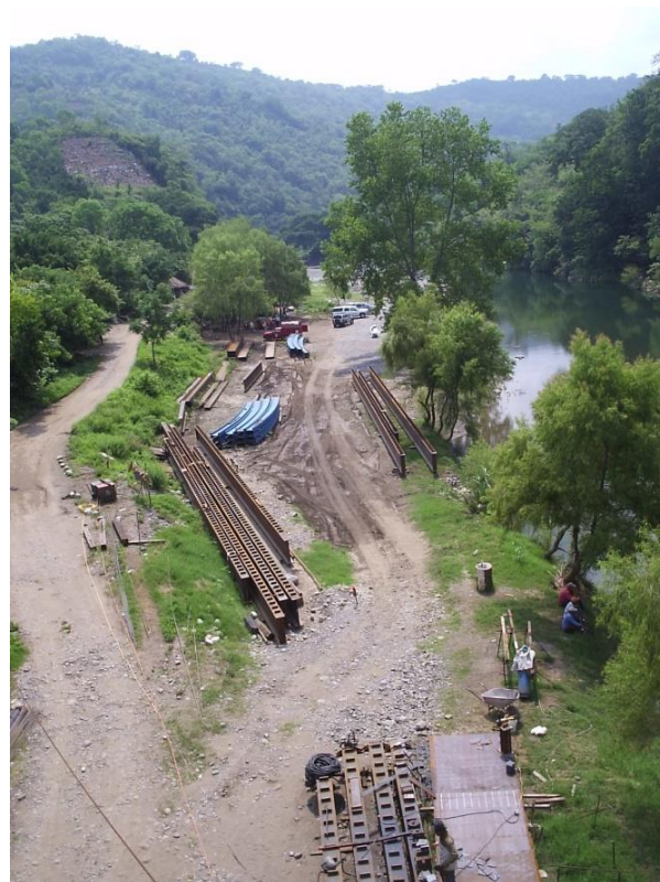
Figura 5.29 Patio de almacenaje de vigas y dovelas del arco.
