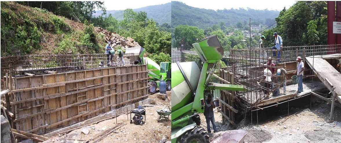
Figura 5.12 Colado del caballete No. 1.
