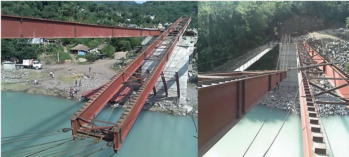
Figura 5.31 Lanzado del segundo par de traveses centrales.
