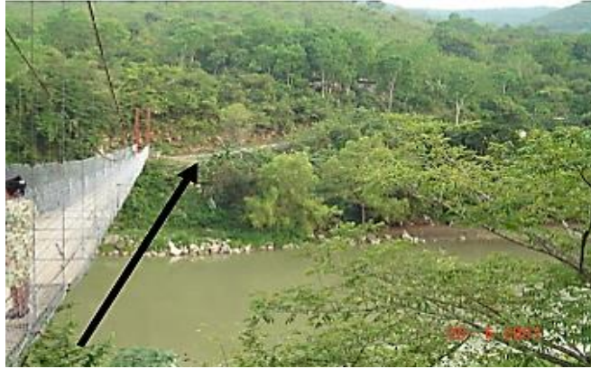
Figura 3.2 Vista hacia enfrente de la selección del sitio, donde fue construido el puente vehicular sobre el río Claro, indicando con la flecha la dirección que tendría el puente.
