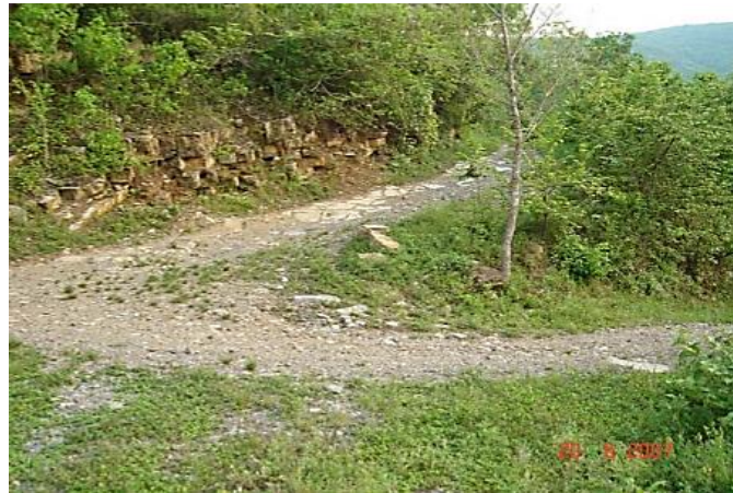
Figura 3.3 Condiciones tanto físicas como bióticas en la salida del puente previo a su construcción, en donde puede observarse que sus elementos habían sido modificados con anterioridad por la construcción del camino existente.
