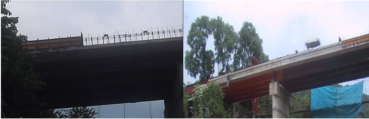
Figura 5.54 Construcción de la guarnición.
