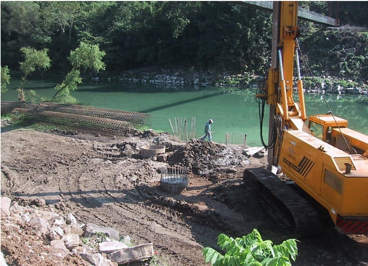
Figura 5.4 Construcción de pilas coladas en sitio.
