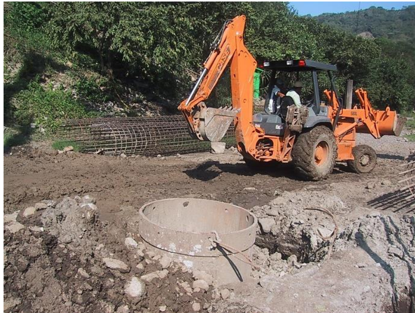
Figura 5.5 Retroexcavadora con cargador frontal.
