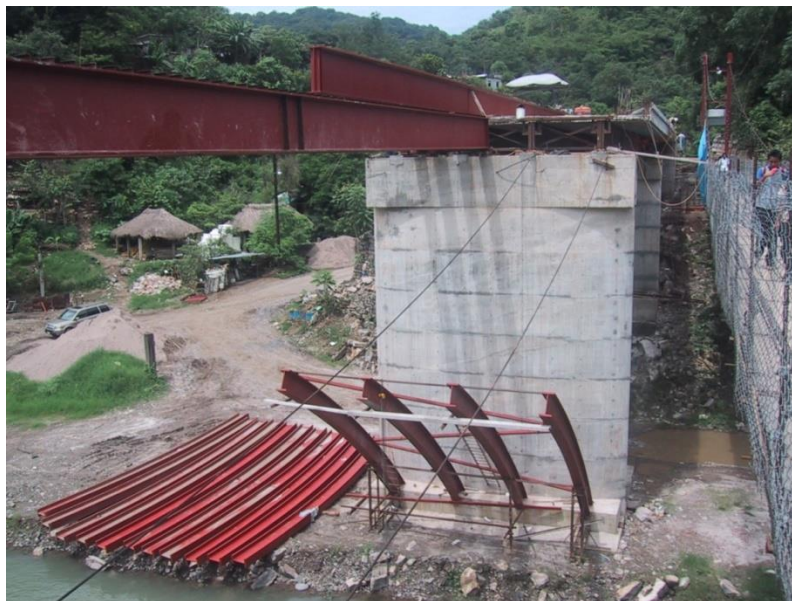
Figura 5.44 Primeras dovelas montadas (pila No. 3).
