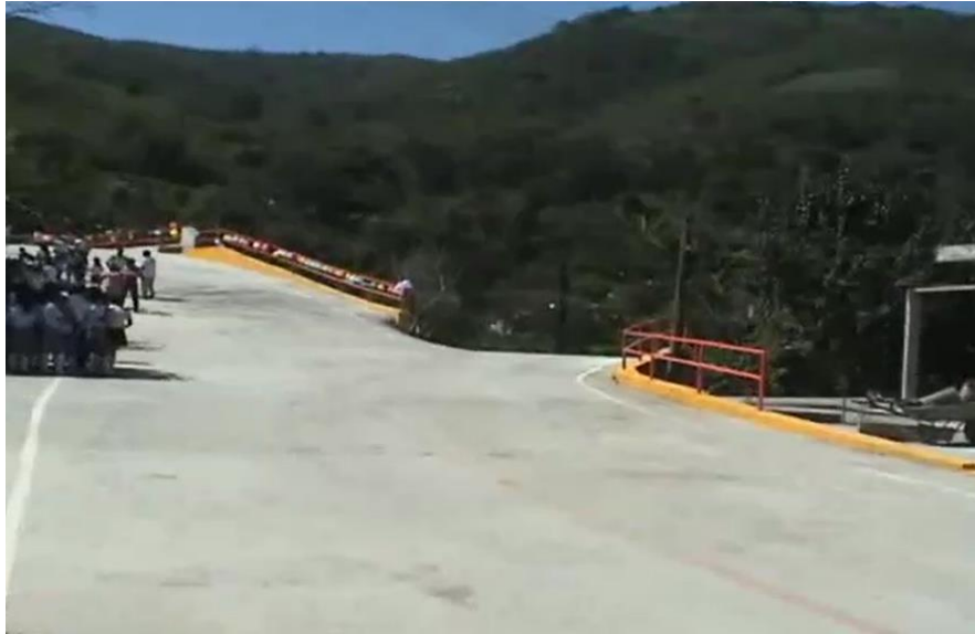
Figura 5.61 Aproche a la entrada del puente (margen derecha) y rampa para bajar al río Claro.
