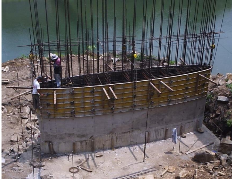
Figura 5.19 Trabajadores colocando la cimbra para el siguiente colado (pila No. 2).
