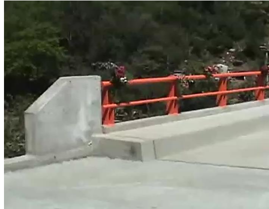
Figura 5.57 Remate de parapeto, banqueta, guarnición y parapetos construidos.
