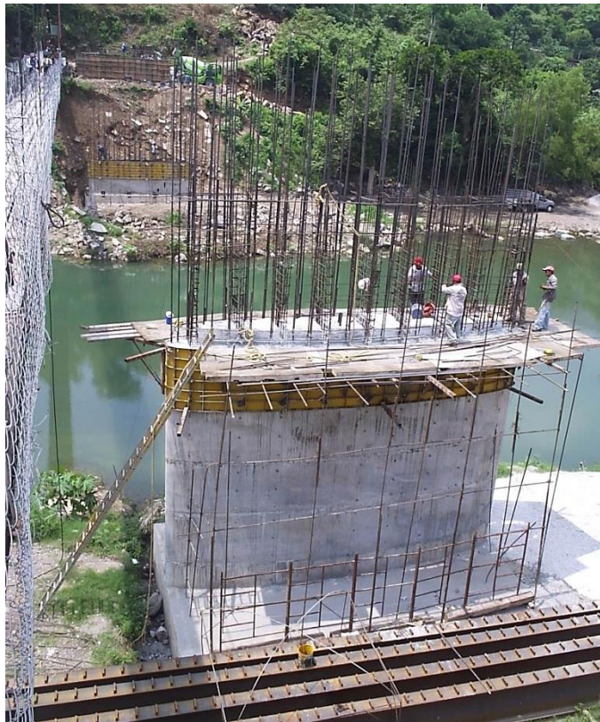
Figura 5.20 Trabajadores continuando con la elaboración del armado sobre el andamio (pila No. 3).
