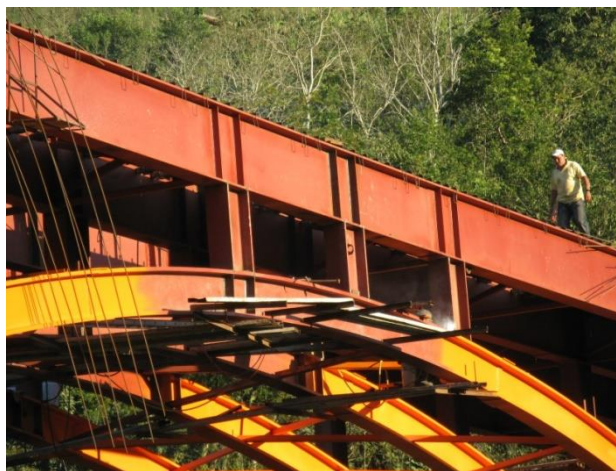
Figura 5.50 Trabajos finales de soldado en los atizadores.
