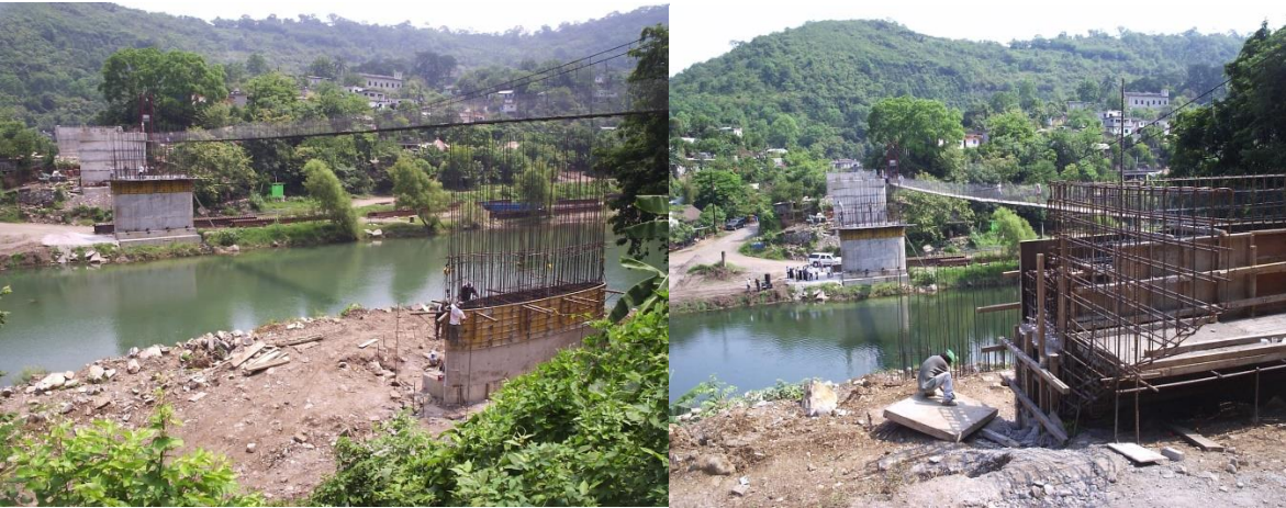
Figura 5.21 Avances simultáneos en la construcción de la subestructura del puente.
