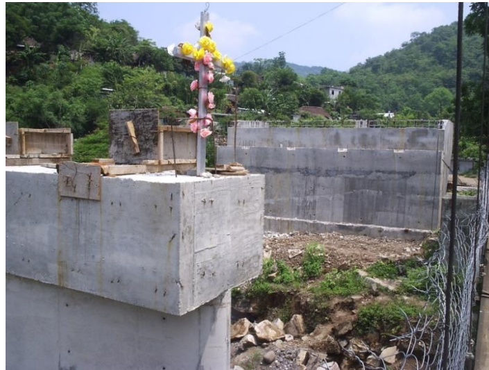
Figura 5.23 En la parte izquierda de la imagen se puede observar la cimbra utilizada para construir los bancos de apoyo de diferentes alturas.
