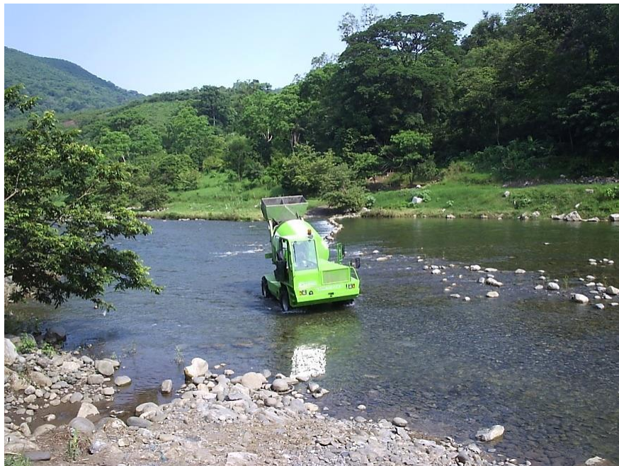
Figura 5.8 Revolvedora cruzando el río Claro por un vado aguas abajo para transportar el concreto.
