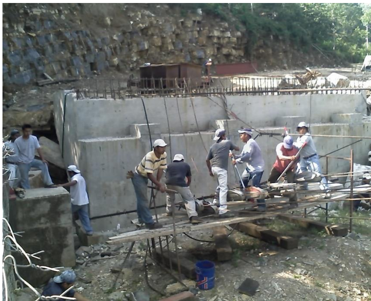
Figura 5.33 Trabajadores accionando el mecanismo para jalar las traves.
