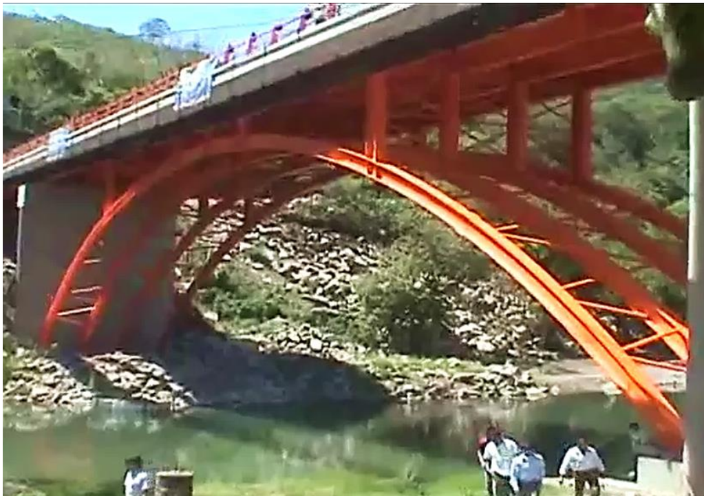
Figura 5.60 Arco del puente una vez terminado.
