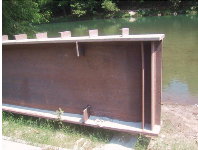
Figura 5.30 Trabe con conectores a cortante y placas para colocar el contraventeo.
