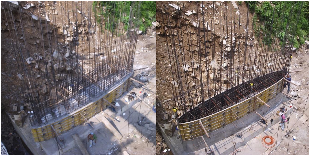
Figura 5.18 Procedimiento constructivo de las pilas (pila No. 2).
