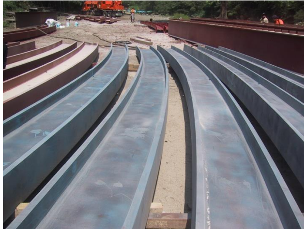
Figura 5.41 Dovelas del arco en sitio.
