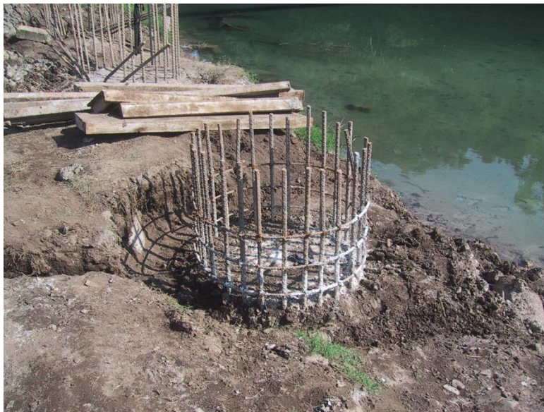
Figura 5.7 Pila descabezada y lista para la unión con la zapata.
