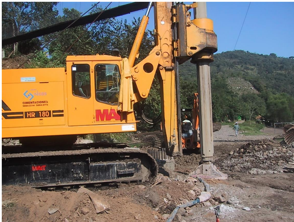
Figura 5.3 Inserción de ademe metálico recuperable.
