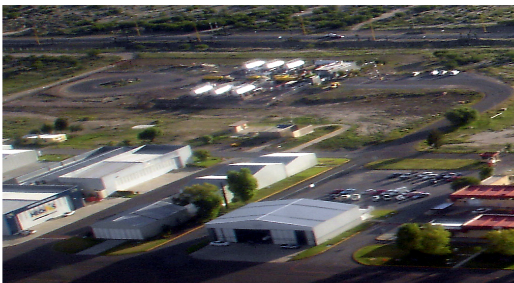
Figura 2.7 Almacenamiento y distribución de combustible.
