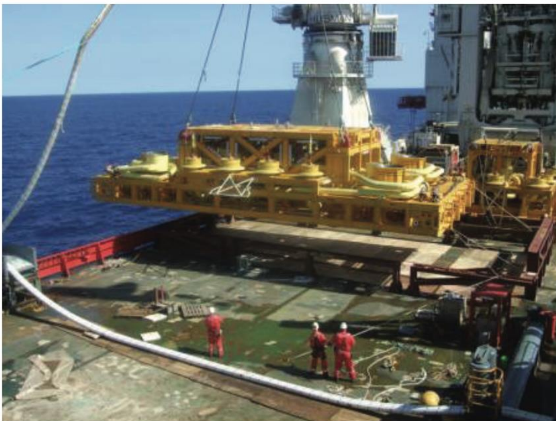
Figura 24.- Instalación del Manifold de elevación artificial Ostra.
