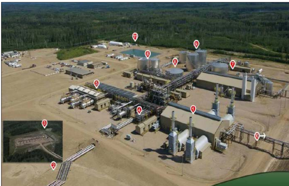
Figura V.6 – Instalaciones requeridas para el SAGD (Conoco Phillips, 2015)
