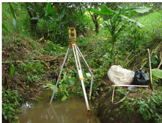
Arrollo levantado para Obra de Drenaje Ubicado su CL en el cadenamamiento 121+122.50
