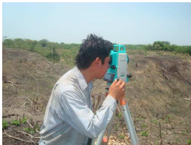
Imagen que muestra el replanteo del eje del camino
