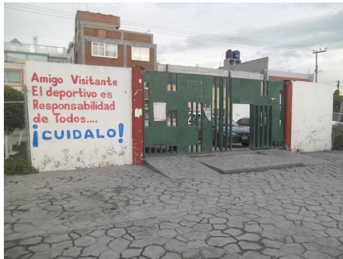
Figura 2.28 Vista interior de la entrada principal al deportivo
