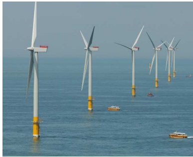
(c) Cimentación de aerogeneradores
