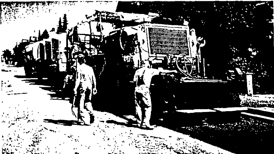
La emulsión asfáltica se utiliza para reciclar y cubrir una capa con restos de alquitrán.
