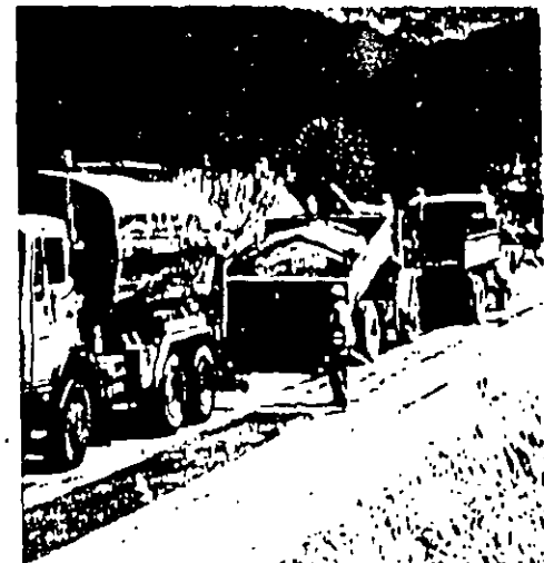
Tratamiento superficial a todo el ancho de calzada.
