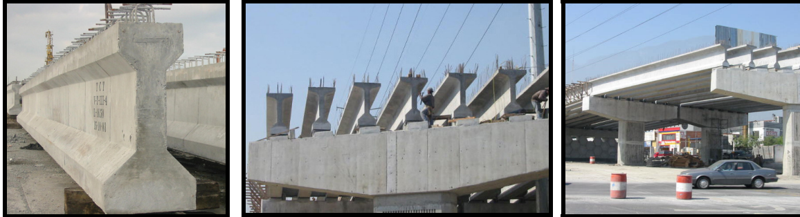
FIGURA IV.33 “TRABES PRESFORZADAS PREFABRICADAS PROPUESTAS”
