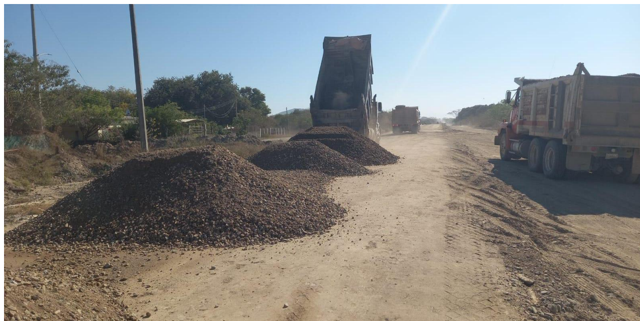
Descarga de material con camión en cuerpo de terraplén
