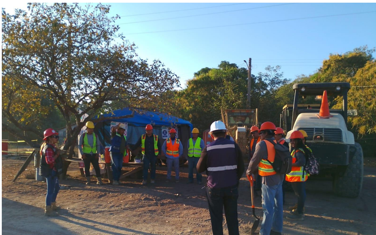
Figura 42 Plática de seguridad e higiene en la obra Línea K
