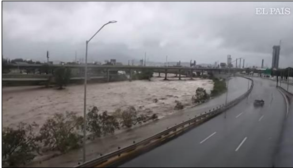
Imagen 1. Vista aérea del Río Santa Catarina en Monterrey, el 20 de junio 2024. [Internet]. 2024 [citado 10 octubre 2024]. Disponible en: https://elpais.com/mexico/2024-06-21/el-paso-de-alberto-por-nuevo-leon-desborda-el-rio-santa-catarina.html
