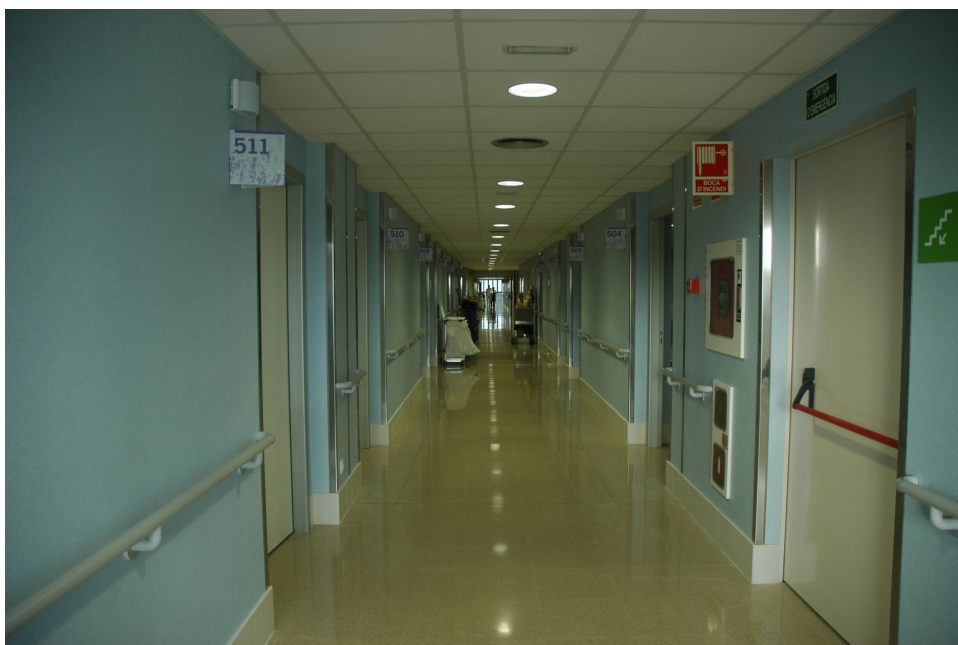
Figura 2.3: Ejemplo de un pasillo de hospital con señalizaciones.
