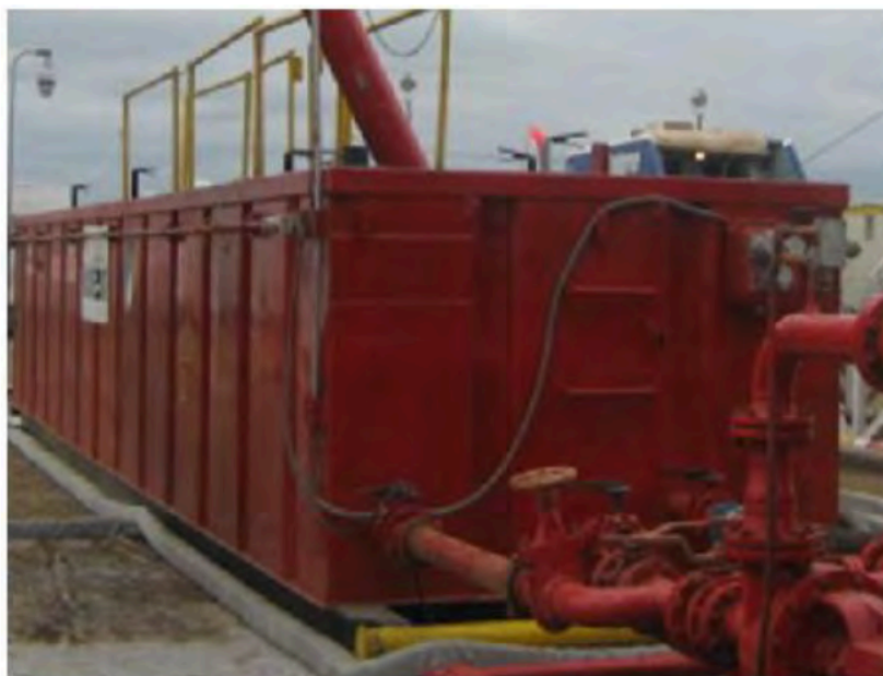
Figura 3.13 Presa de separación Skimmer
