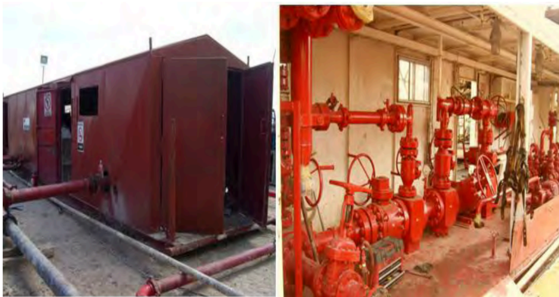
Figura 3.12 Caseta de estrangulador
