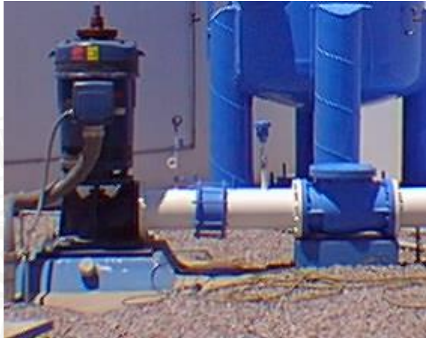
FIGURA 5.18 VÁLVULA DE RETENCIÓN EN LA DESCARGA DE UNA BOMBA
