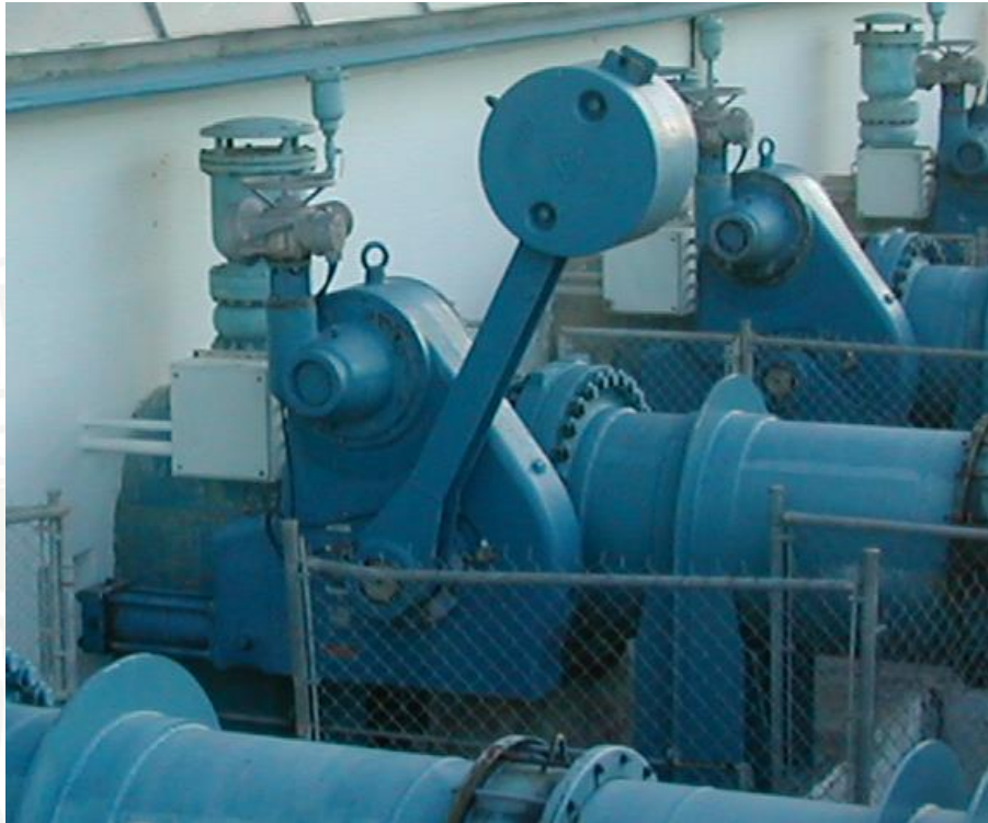
FIGURA 5.20 VÁLVULA DE RETENCIÓN CON AMORTIGUAMIENTO
