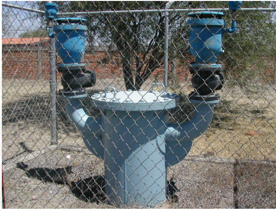
FIGURA 5.41 ÁRBOL DE DOS VÁLVULAS DE ADMISIÓN Y EXPULSIÓN DE AIRE
