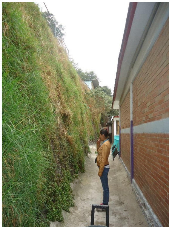
Figura 4.43. Fotografía E de la Zona 3, Jardín de Niños Topilli, talud con una altura de 5 m, que se ubica a 1 m de distancia de las aulas y la conserjería.
