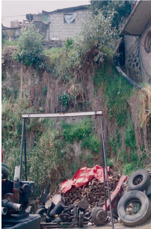
Figura 4.14. Fotografía E de la zona 1, vivienda construida sobre un talud con peligro por derrumbe. La vegetación sobre el talud retiene y protege el material de factores erosivo.
