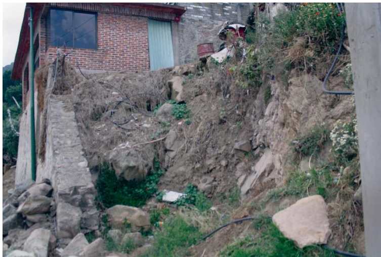
Figura 4.15. Fotografía F de la zona 1, derrumbe en el patio de la vivienda, también se pueden apreciar bloques de diferentes tamaños en una matriz limo-arcillosa.
