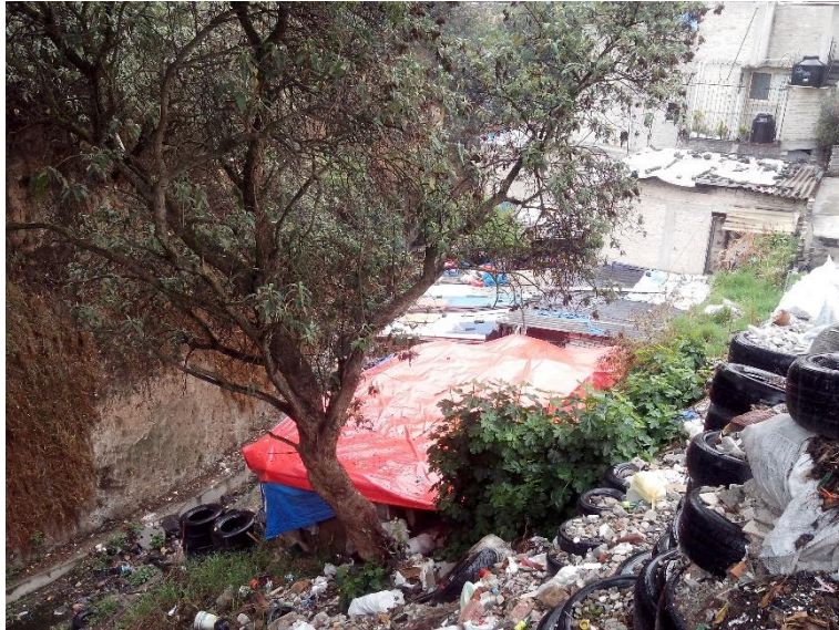
Figura 4.62. Fotografía E de la Zona 7, en la esquina inferior derecha parte de un muro de contención, se puede ver la vivienda que se encuentra dentro de la barranca y la distancia es menor a 2 m del cauce del río.
