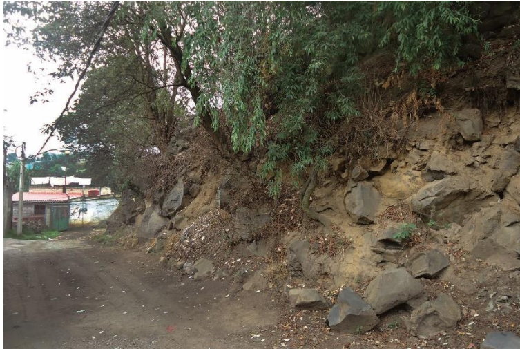
Figura 4.41. Fotografía C de la Zona 3, ladera compuesta principalmente por bloques de gran tamaño y que se encuentran expuestos, que muestran una gran inestabilidad y que representan peligro de caída de rocas en el camino.
