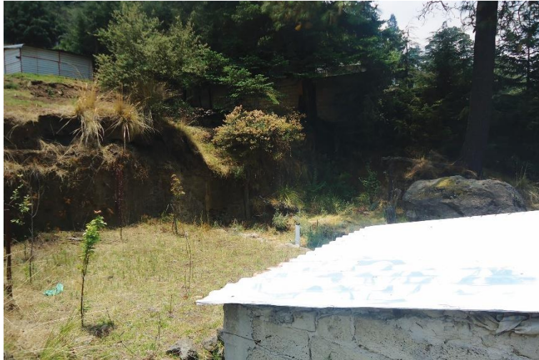
Figura 4.56. Fotografía C de la Zona 6, se observa el tipo de corte que realizan en la ladera para desplantar las viviendas.
