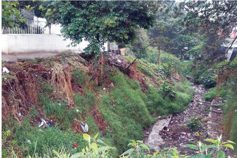
Figura 4.59. Fotografía A de la Zona 7, los sedimentos y bloques de distintos tamaños que han sido transportados por el caudal han rellenado por completo las obras de mitigación, con esto aumenta el peligro de flujos de lodo y rocas.
