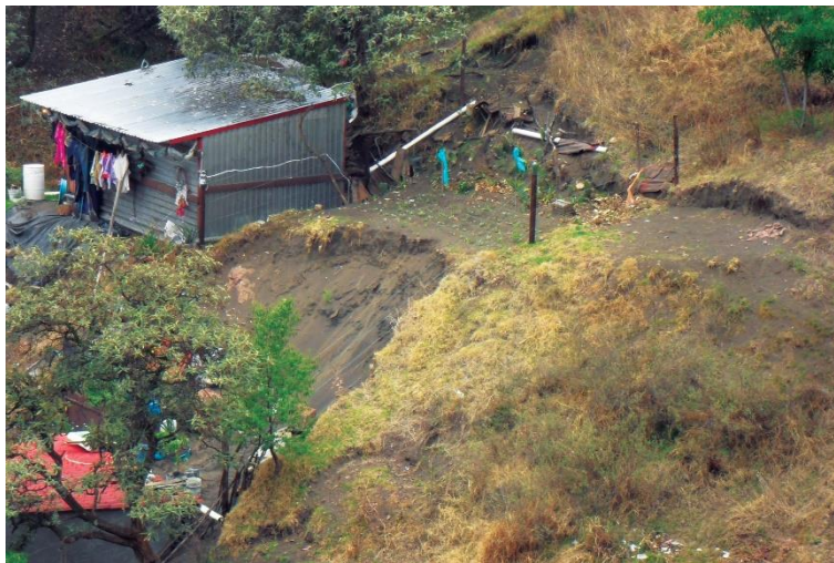
Figura 4.27. Fotografía D de la Zona 2, La ceniza es removida fácilmente, en especial en los taludes hechos para construcción ya que se reduce el nivel de estabilidad de los materiales; en la imagen se puede apreciar la gran actividad que se presenta en los escarpes.
