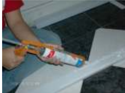
Figura 38. Distribución de pegamento en la canaleta.
