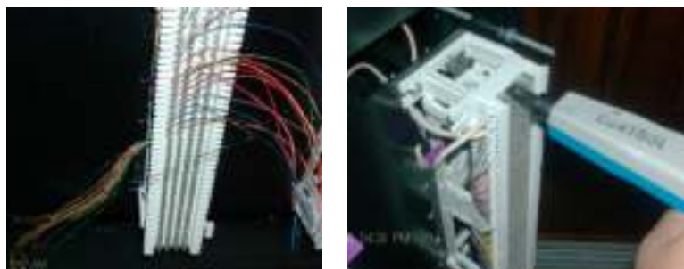
Figura 107. Imágenes del ponchado en la regleta
