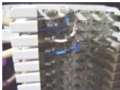
Figura 121. Conexión en la regleta
