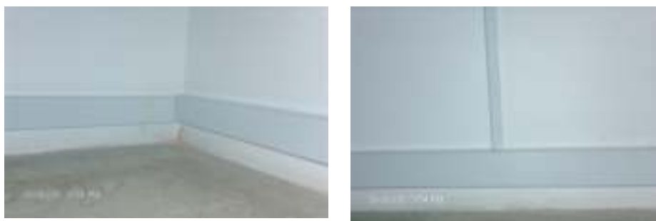
Figura 59. Canaleta fijada en el centro de servicio.
