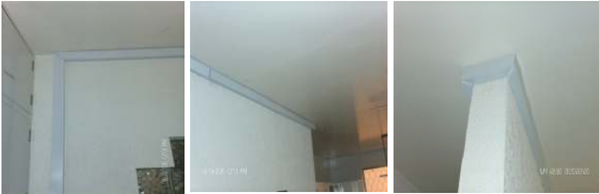
Figura 67. Canaleta fijada a concreto en almacén.
