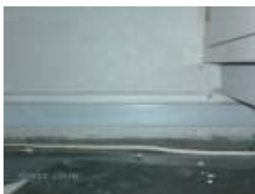
Figura 64. Pegado de canaleta en almacén.
