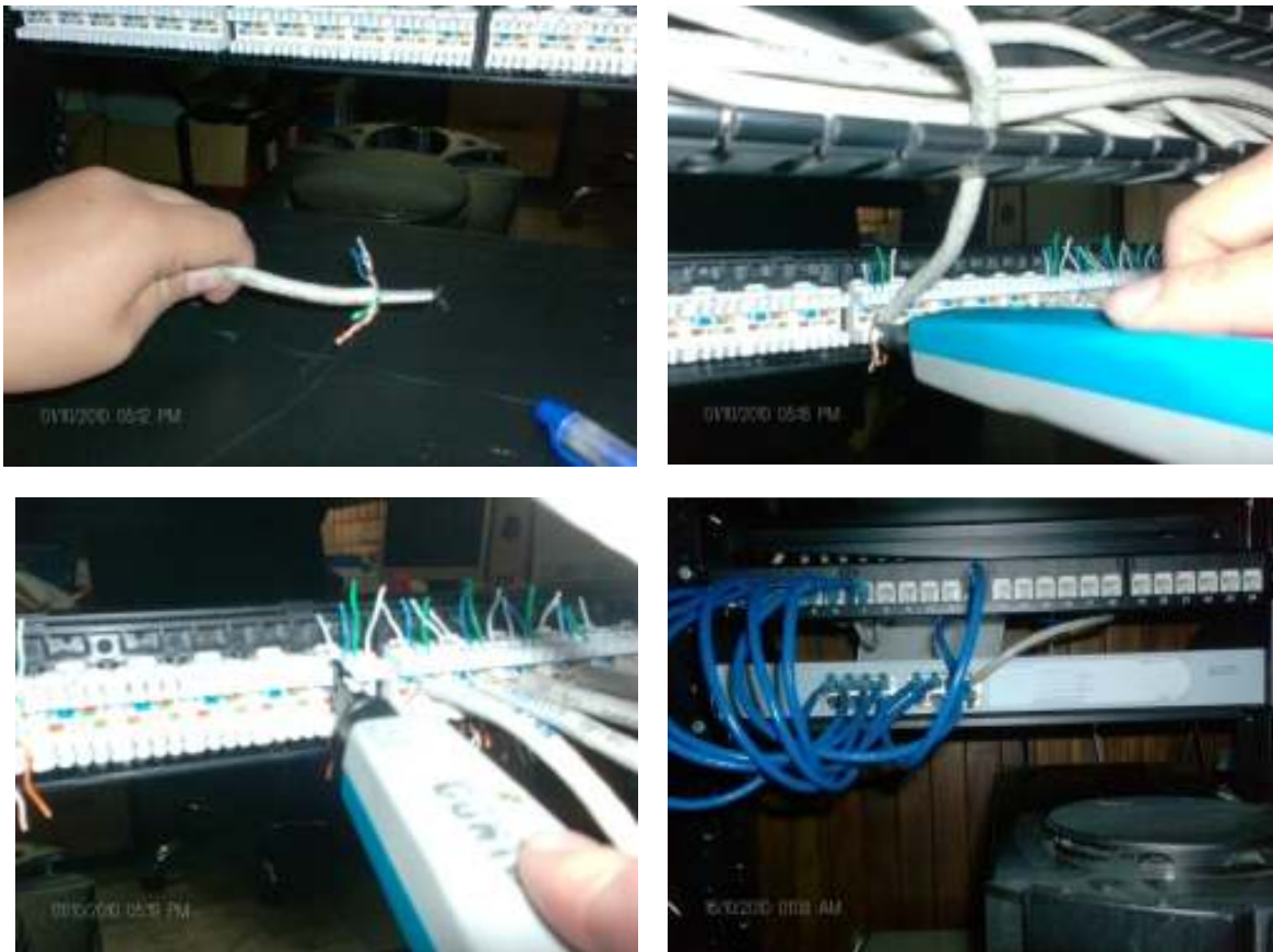
Figura 96. Ponchado del patch panel
