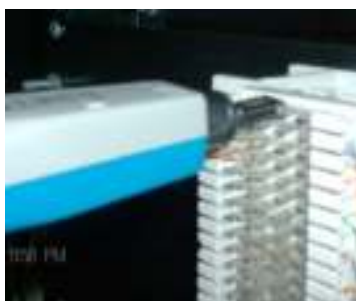
Figura 113. Ponchado de cable telefónico de la extensión 1 en la regleta siemon
