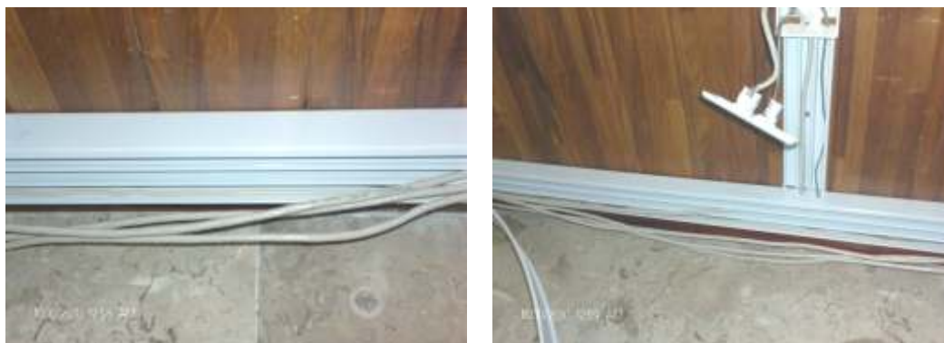
Figura 88. Cable UTP en la canaleta
