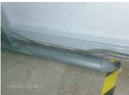
Figura 74. Cableado en el centro de servicio.
