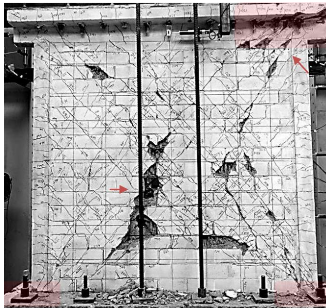
Figura 5.8 Estado final del muro MB-3
