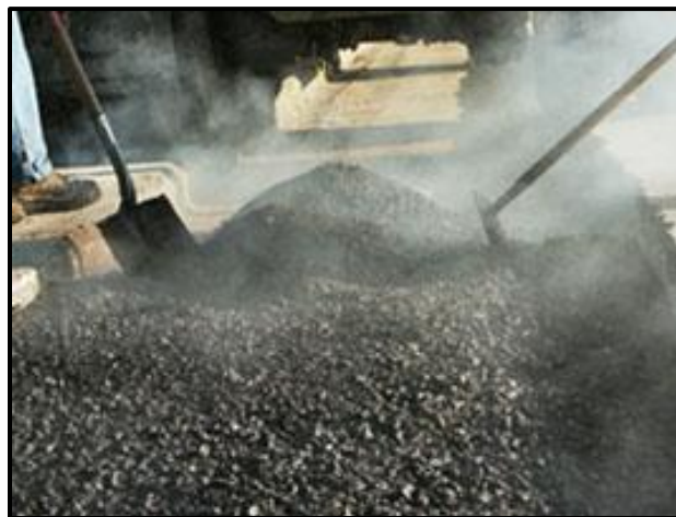
Figura 2.2.2. Evaporación de gases y olores de la mezcla asfáltica en caliente [19].
